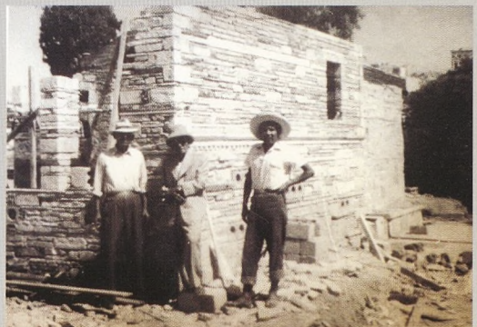
“Ο Πικιώνης στο κέντρο κατά τη διάρκεια της κατασκευής του Αγ. Δημητρίου Λουμπαρδιάρη.”
