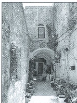
Επέκταση κατοικίας πάνω από το δρόμο και μετέωρη αντηρίδα σε στενό αντίστοιχα, στους Ολύμπους.
