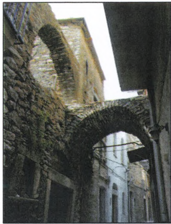
Τοξωτό άνοιγμα ηλιακού στο Πυργί και προεξοχή ορόφου σε τοξύλλια στην Καλαμωτή αντίστοιχα, σήμερα.
