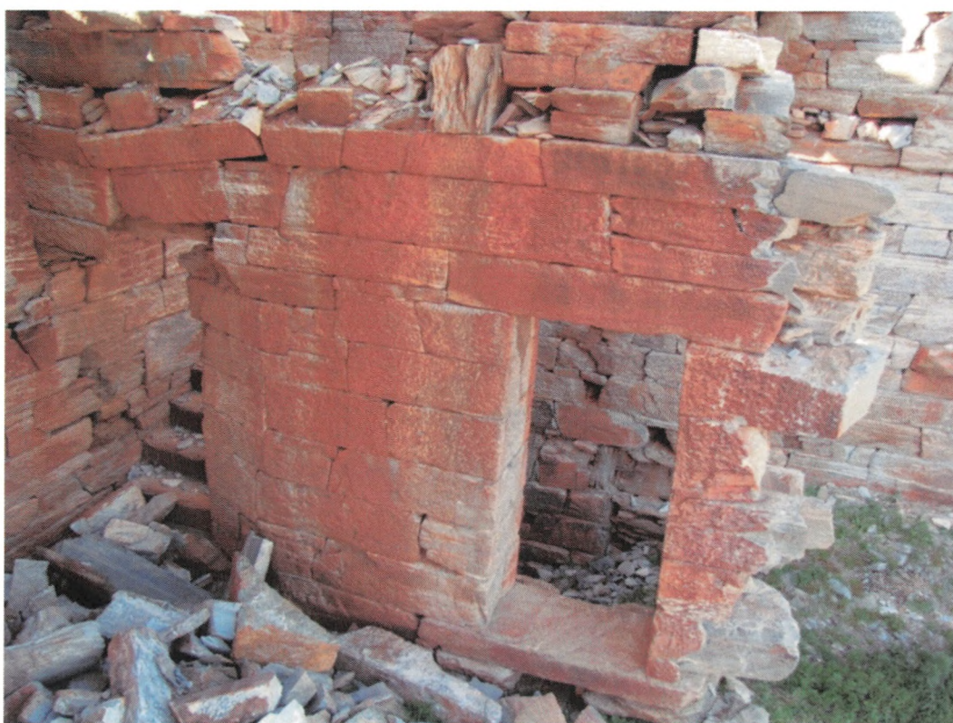
Εικ. 17. Ο μεσότοιχος του Α' ορόφου από ΝΑ. Διακρίνονται τα δυο ανοίγματα θυρών.
