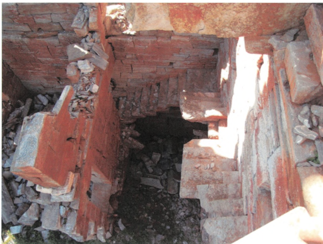
Εικ. 23. Το βόρειο διαμέρισμα του πύργου με τη σωζόμενη λίθινη κλίμακα.
