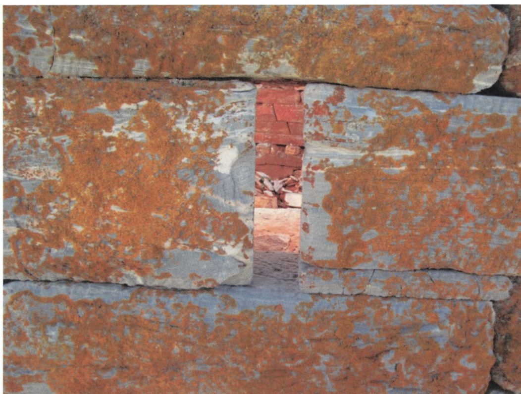
Εικ. 27. Λεπτομέρεια τοξοθυρίδας της βόρειας πλευράς.
