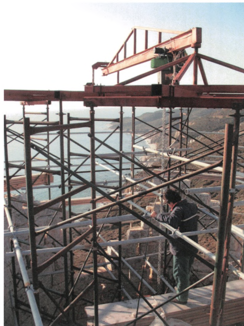
Εικ. 57. Η γερανογέφυρα και ο εσωτερικός πυρήνας του ικρίωματος γερανογέφυρα του έργου αποκατάστασης του πύργου του Δρακάνου Ικαρίας.
