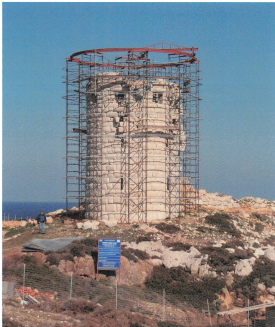
Εικ. 56. Το ικρίωμα και η γερανογέφυρα του έργου αποκατάστασης του πύργου του Δρακάνου Ικαρίας.
