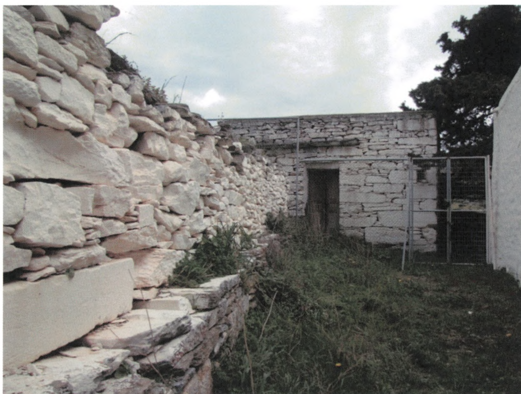
Εικ. 15. Νεώτερο κτίσμα (σήμερα αποθήκη) κτισμένο με λίθους που κατέπεσαν από τον αρχαίο πύργο.
