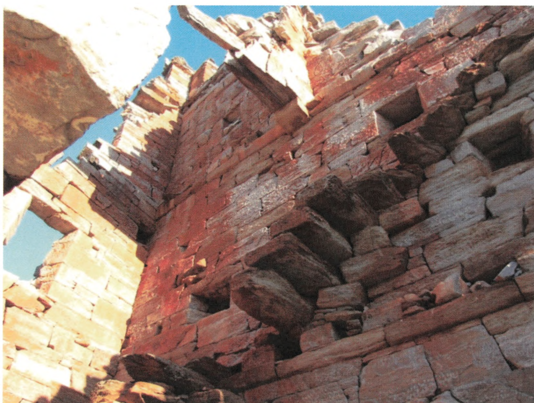
Εικ. 35. Το κρεμάμενο τμήμα του μεσότοιχου του Γ' ορόφου από κάτω.
