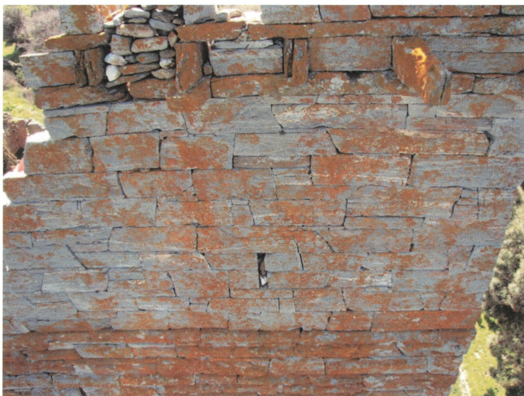
Εικ. 33. Η παραμόρφωση του βόρειου τοίχου εκ των άνω.
