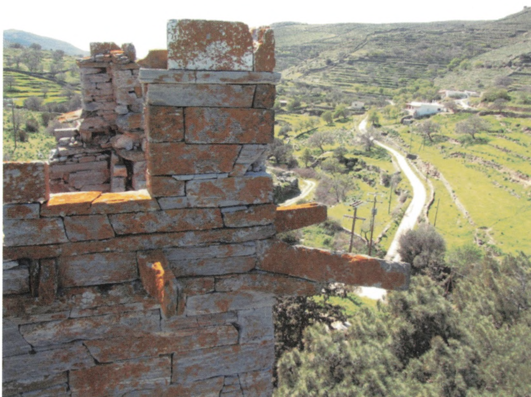
Εικ. 25. Η ΒΔ γωνία με τους προβόλους και τον πεσσό, ο οποίος επιστέφεται με διάζωμα από λευκό μάρμαρο.
