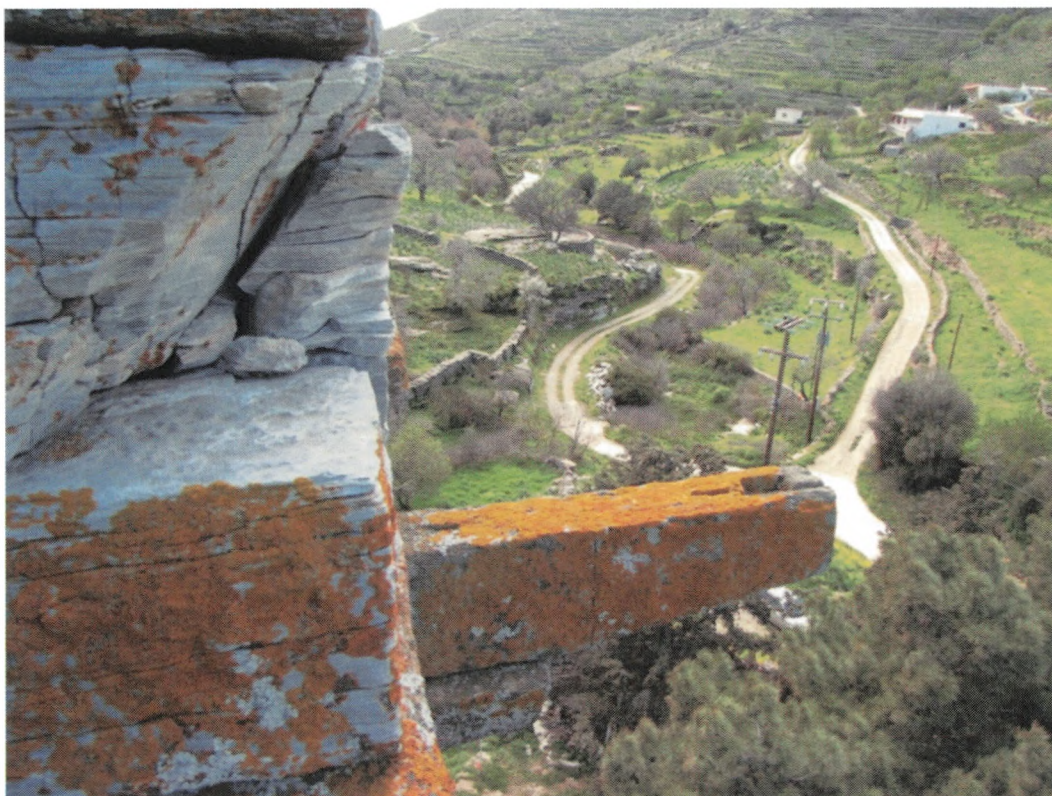
Εικ. 26. Πρόβολος της δυτικής πλευράς μετά τη ΒΔ γωνία με τις εγκοπές πιθανώς για τη στερέωση κουπαστής και πατώματος.
