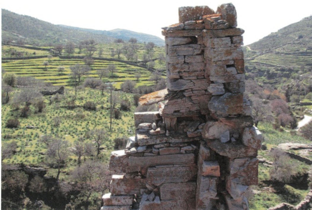
Εικ. 39. Η άνω ΝΔ γωνία του πύργου με την επισφαλή έδραση στις θέσεις των δοκοθηκών.
