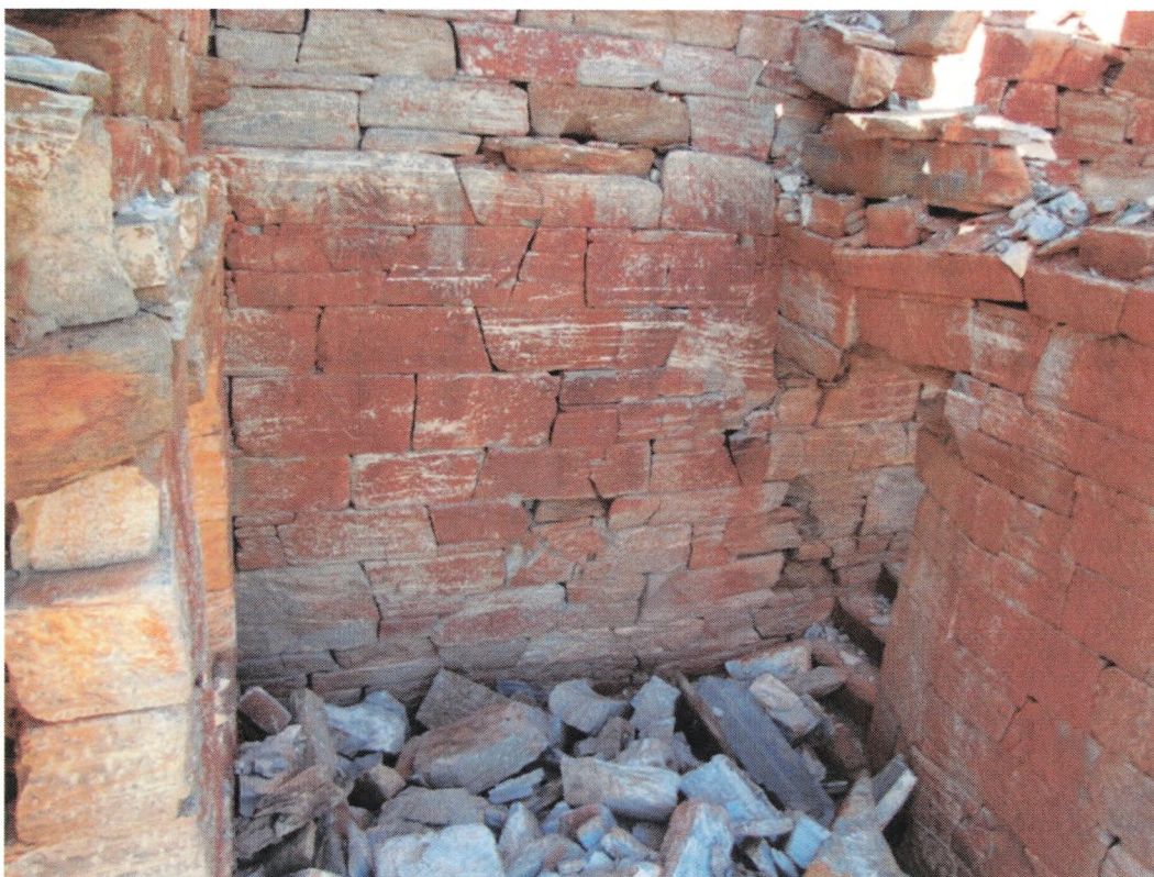
Εικ. 52. Το θραυσμένο και έντονα παραμορφωμένο ανώφλιο του προς Δ. ανοίγματος του μεσότοιχου.
