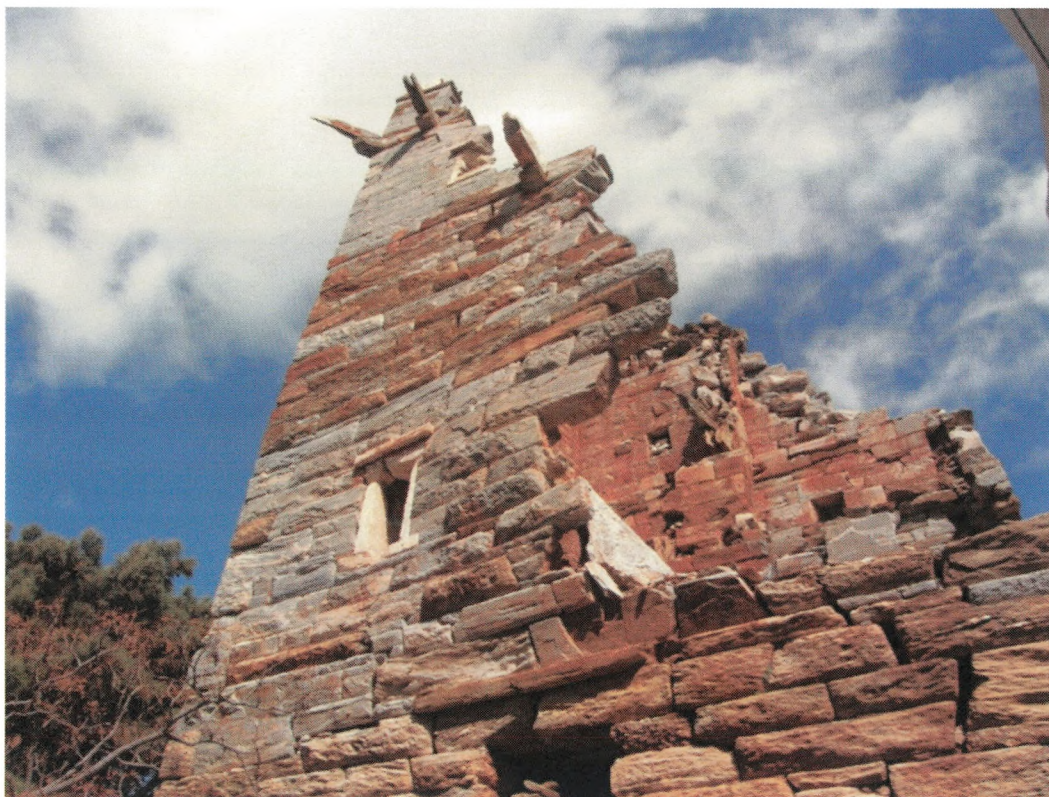
Εικ. 46. Άποψη του νότιου τοίχου από κάτω. Διακρίνεται η έντονη στροφή της εξωτερικής πλευράς προς τα έξω.
