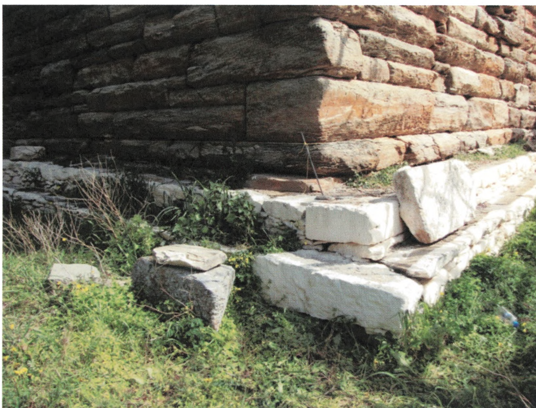
Εικ. 54. Η ΝΔ γωνία της ευθυντηρίας. Έλεγχος με ράμμα της παραμόρφωσής της.
