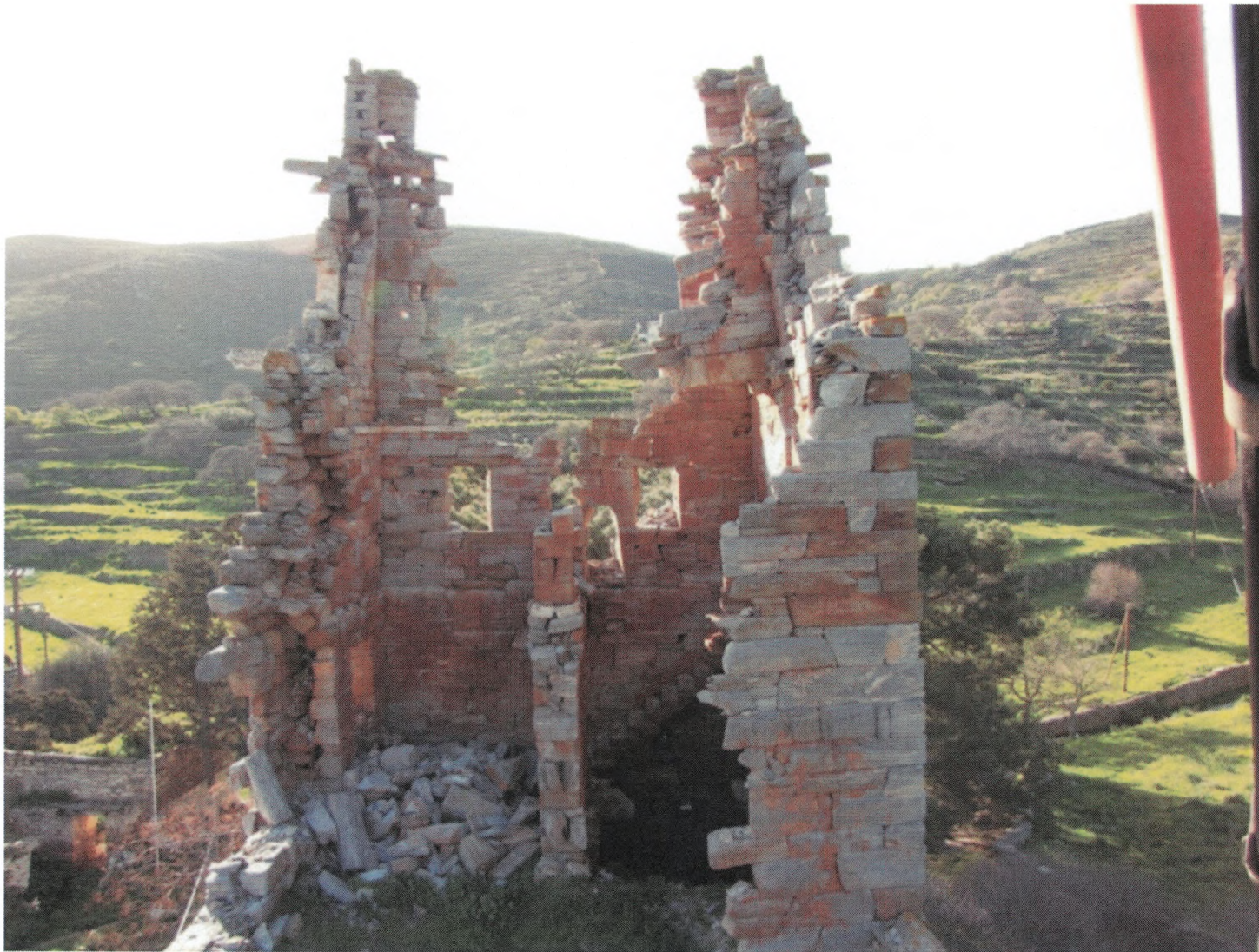
Εικ. 5. Άποψη του πύργου από Α. Διακρίνεται η εσωτερική διαίρεση του χώρου από το μεσότοιχο και τον κρεμάμενο εγκάρσιο τοίχο και η εσωτερική λίθινη κλίμακα. Ο χώρος του ισογείου είναι επιχωσμένος από τα υλικά της κατάρρευσης. Διακρίνονται τα προς δυσμάς παράθυρα του Β' ορόφου.
