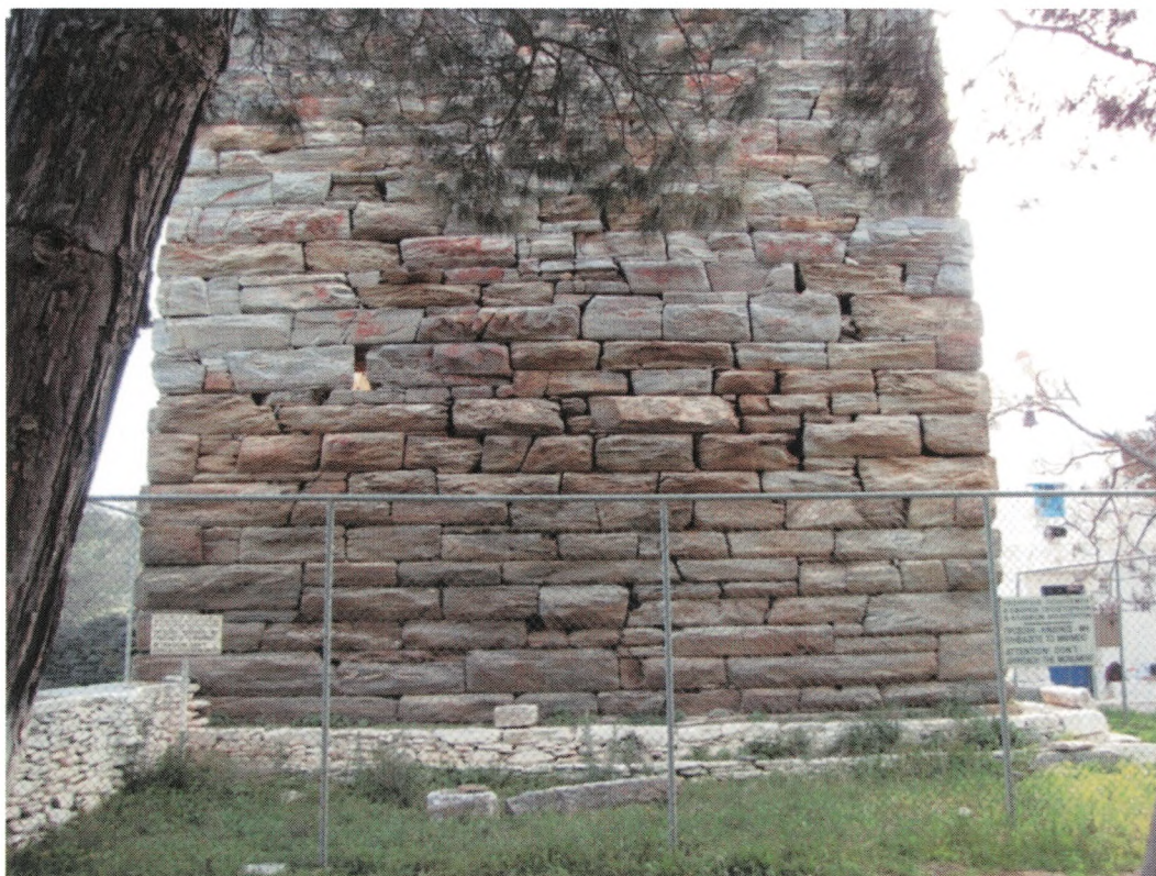
Εικ. 44. Το κάτω τμήμα του δυτικού τοίχου. Διάνοιξη όρθιων αρμών του τοίχου.
