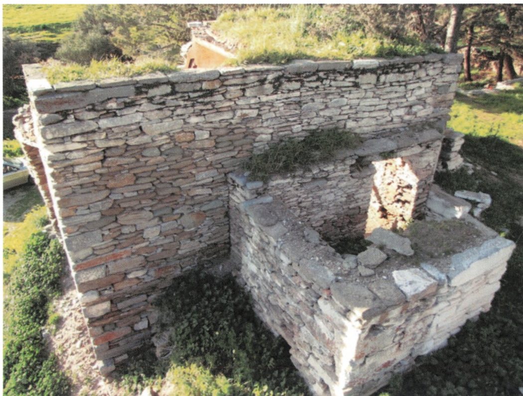
Εικ. 14. Το ερειπωμένο κτίσμα της ΝΔ γωνίας του τείχους της μονής ανακατασκευασμένο με λίθους του αρχαίου πύργου. Η δυτική πλευρά του είναι ετοιμόρροπη.
