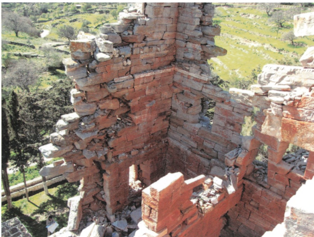
Εικ. 22. Το εσωτερικό του πύργου εκ των άνω. Διακρίνονται τα ίχνη της καθ' ύψος διαίρεσης των χώρων από τα ίχνη των δοκοθηκών που είναι φραγμένα με αργούς λίθους (πάνω από το παράθυρο και πάνω από το γείσωμα με το λευκό μάρμαρο).
