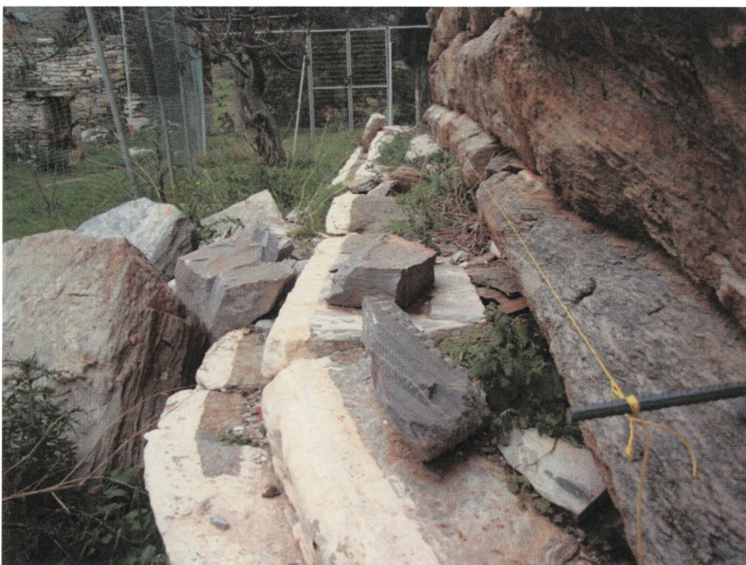
Εικ. 55. Έλεγχος με ράμμα της παραμόρφωσής της νότιας πλευράς της ευθυντηρίας.
