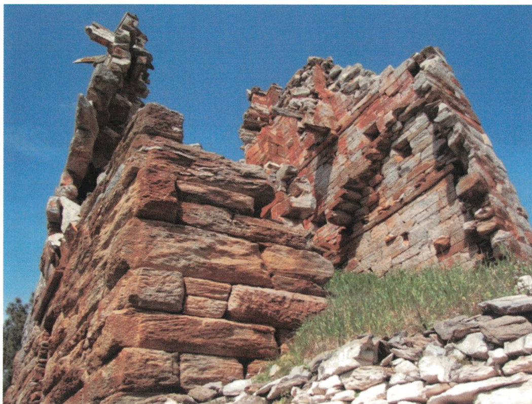
Εικ. 47. Άποψη του νότιου τοίχου από ΝΑ και κάτω. Διακρίνεται η έντονη στροφή της εξωτερικής πλευράς προς τα έξω.
