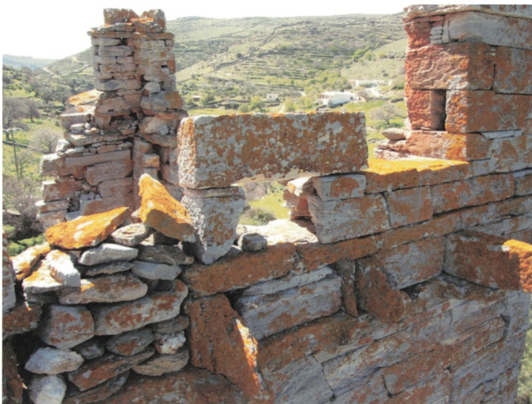
Εικ. 24. Το άνω τμήμα του βόρειου τοίχου με τους προβόλους και τους πεσσούς. Αριστερά άνοιγμα φραγμένο με αργούς λίθους.
