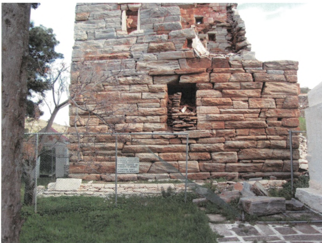
Εικ. 45. Το κάτω τμήμα του νότιου τοίχου. Διάνοιξη όρθιων αρμών του τοίχου και θραύση του ανωφλίου στο άνοιγμα της εισόδου.
