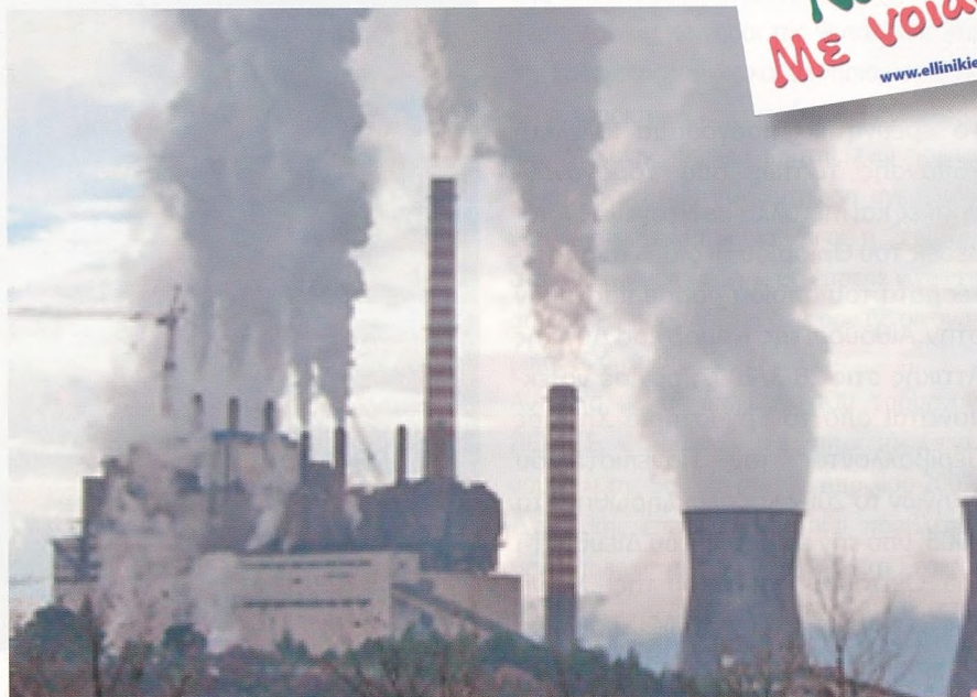
Εκπομπή ρύπων από το εργοστάσιο παραγωγής ηλεκτρικής ενέργειας στη Μεγαλόπολη
