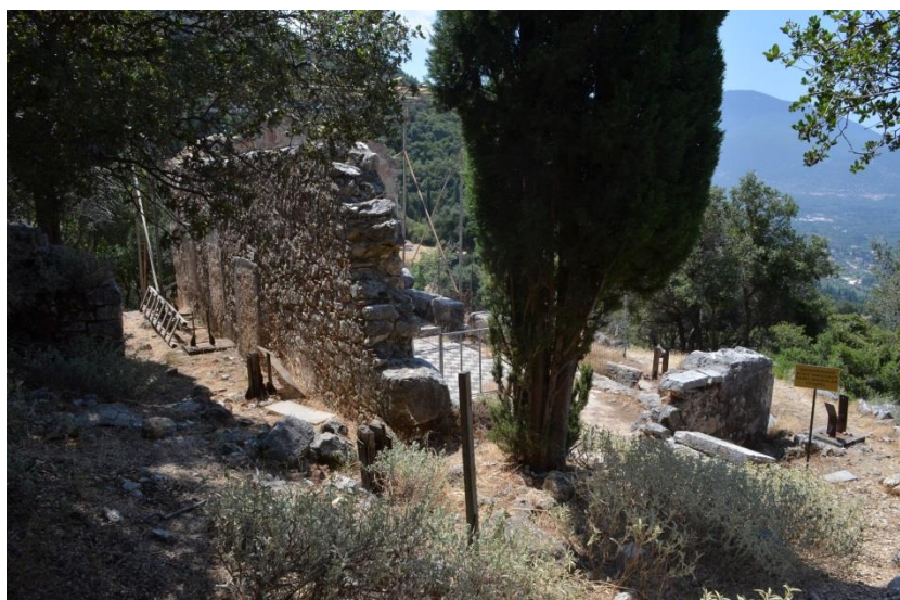
Εικ. 57 Άποψη του ναού από τα βορειοδυτικά.
