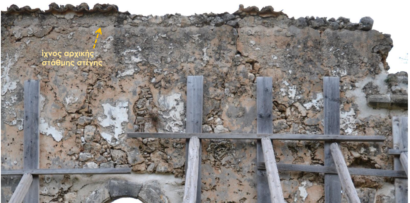
Εικ. 37 Απόληξη του νότιου τοίχου. Διακρίνονται τα σωζόμενα κεραμίδια αλλά και το ίχνος των κεραμιδιών της αρχικής στέγης.
