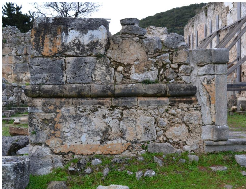
Εικ. 27 Βόρειο τμήμα δυτικής όψης. Σώζεται ο χρωματισμός κατακόρυφων και οριζόντιων ζωνών.
