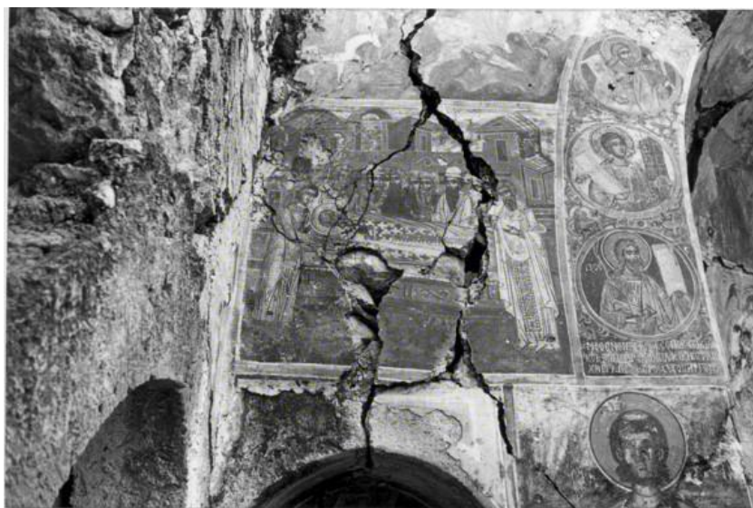
Εικ. 55 Ρωγμή πάνω από την κόγχη της πρόθεσης (1970-1980). Από το αρχείο του Κοργιαλενείου Ιδρύματος.
