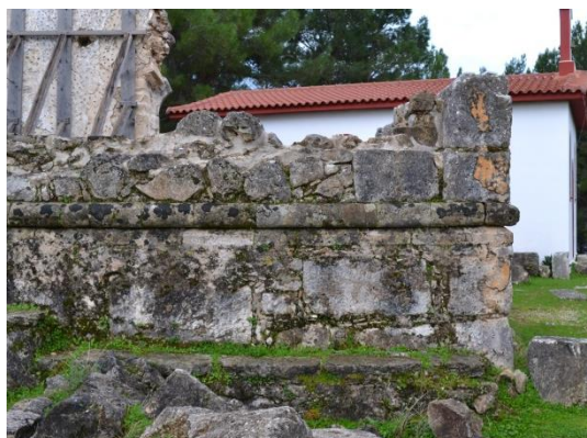
Εικ. 16 Δυτικό άκρο του βόρειου τοίχου.
