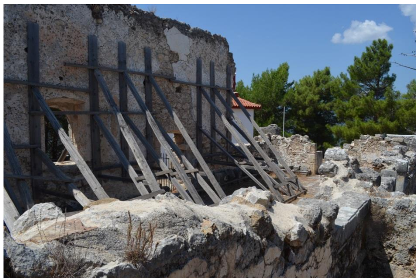
Εικ. 50 Η αντιστήριξη του νότιου τοίχου στο εσωτερικό του ναού.
