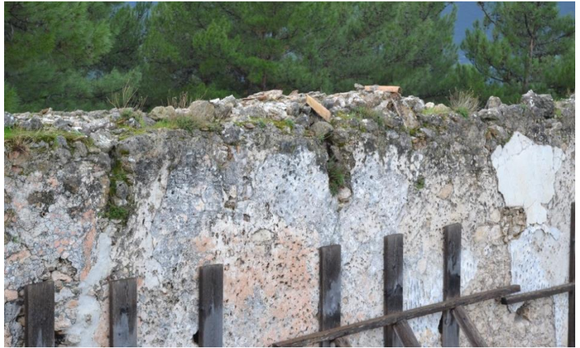
Εικ. 35 Εσωτερική παρειά του νότιο τοίχου. Διακρίνονται οι δοκοθήκες της ξύλινης στέγης.
