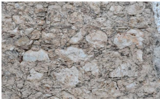
Εικ. 15 Λεπτομέρεια της τοιχοποιίας.
