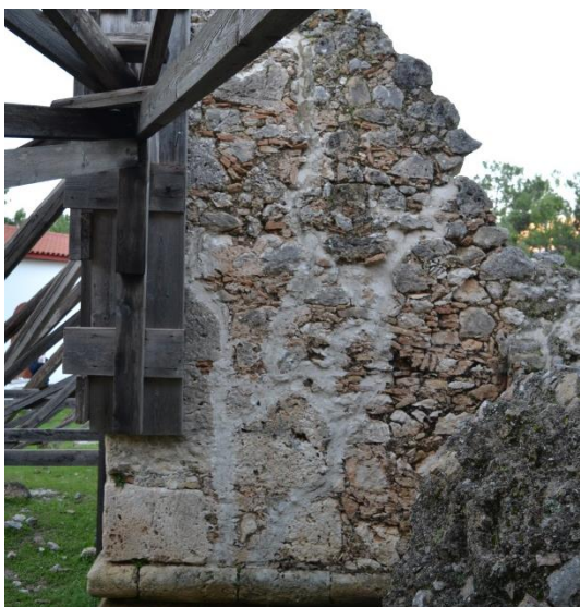
Εικ. 49 Το νότιο άκρο του ανατολικού τοίχου.
