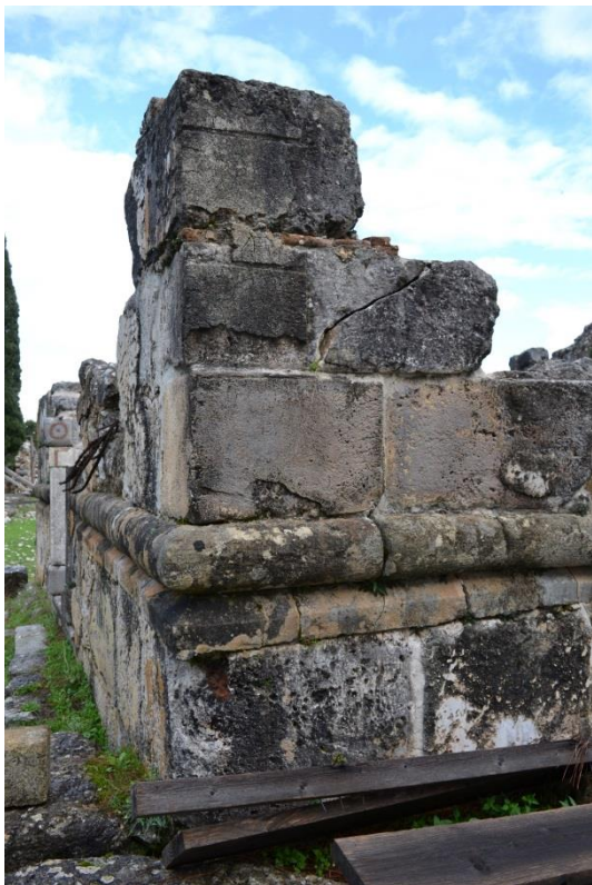
Εικ. 25 Απομίμηση γωνιόλιθων στο αρχικό επίχρισμα της νοτιοδυτικής γωνίας του ναού.
