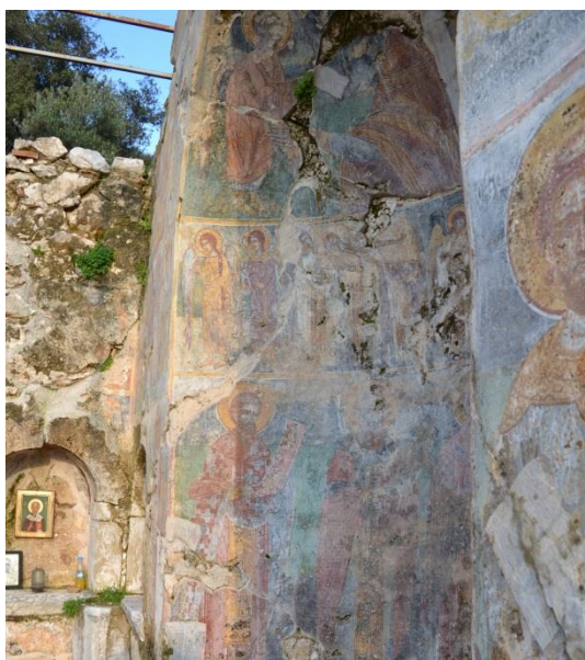
Εικ. 65 Άποψη της κόγχης του ιερού από τα νοτιοανατολικά.
