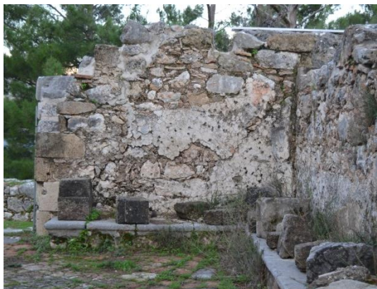
Εικ. 28 Βόρειο τμήμα της δυτικής πλευράς. Διακρίνονται τα διαδοχικά στρώματα των εσωτερικών επιχρισμάτων.
