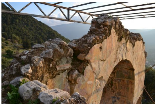
Εικ. 64 Η απόληξη του ανατολικού τοίχου.
