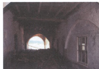
Εικ. 4-6. Οι στοές (νότια, ανατολική και δυτική) γύρω από τον κεντρικό ναό του 19 ου αιώνα. Από αυτές κατεδαφιστές θα πρέπει να θεωρηθούν μόνον οι οριζόντιες πλάκες από οπλισμένο σκυρόδεμα (βλ. Εικ..5).
