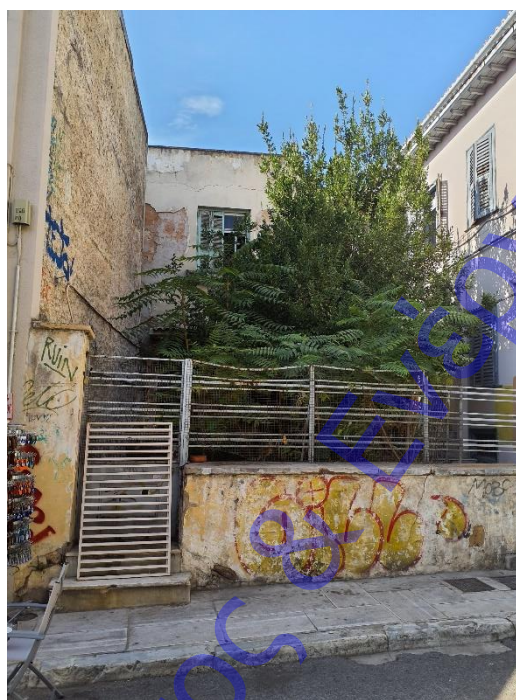
Εγκαταλελειμμένη κατοικία στο νότιο όμορο οικόπεδο.
