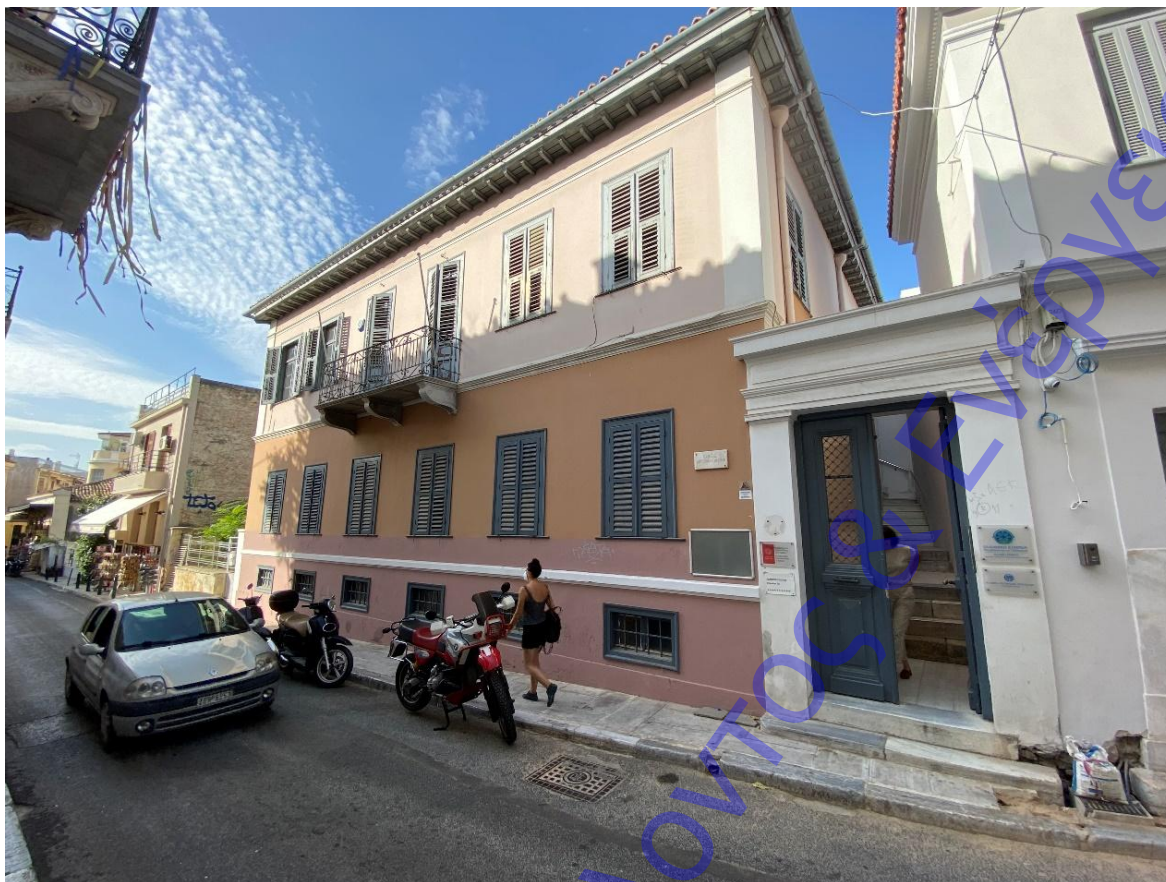
Άποψη υφιστάμενης κατάστασης πρόσοψης
