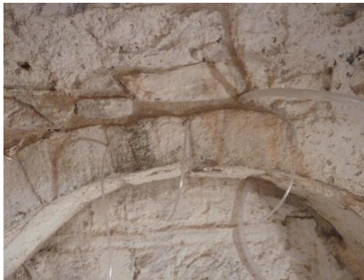
Ανάταξη τόξου τζιβίκωμα, βαθύ αρμολόγημα τοποθέτηση σωληνίσκων για τα ενέματα.
