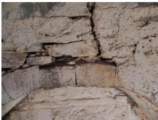
Ανάταξη τόξου τζιβίκωμα, βαθύ αρμολόγημα τοποθέτηση σωληνίσκων για τα ενέματα.
