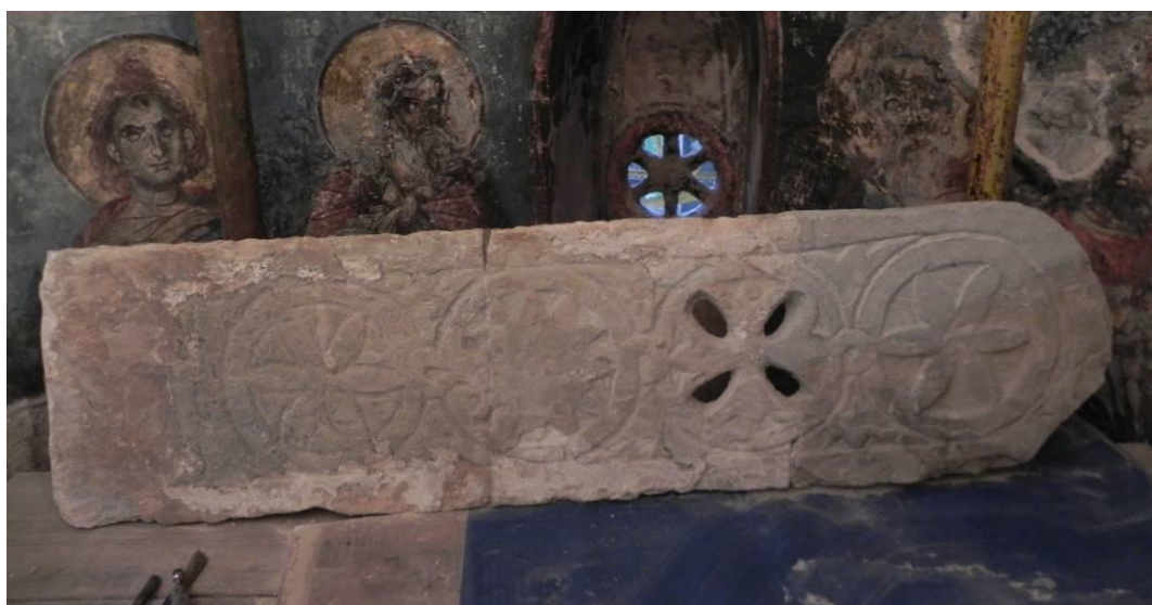
Αποκατάσταση του νότιου διαφράγματος του τρούλου, με συγκόλληση των σπασμένων τμημάτων και συμπλήρωση με κονίαμα της απώλειας του πάνω μέρους.
