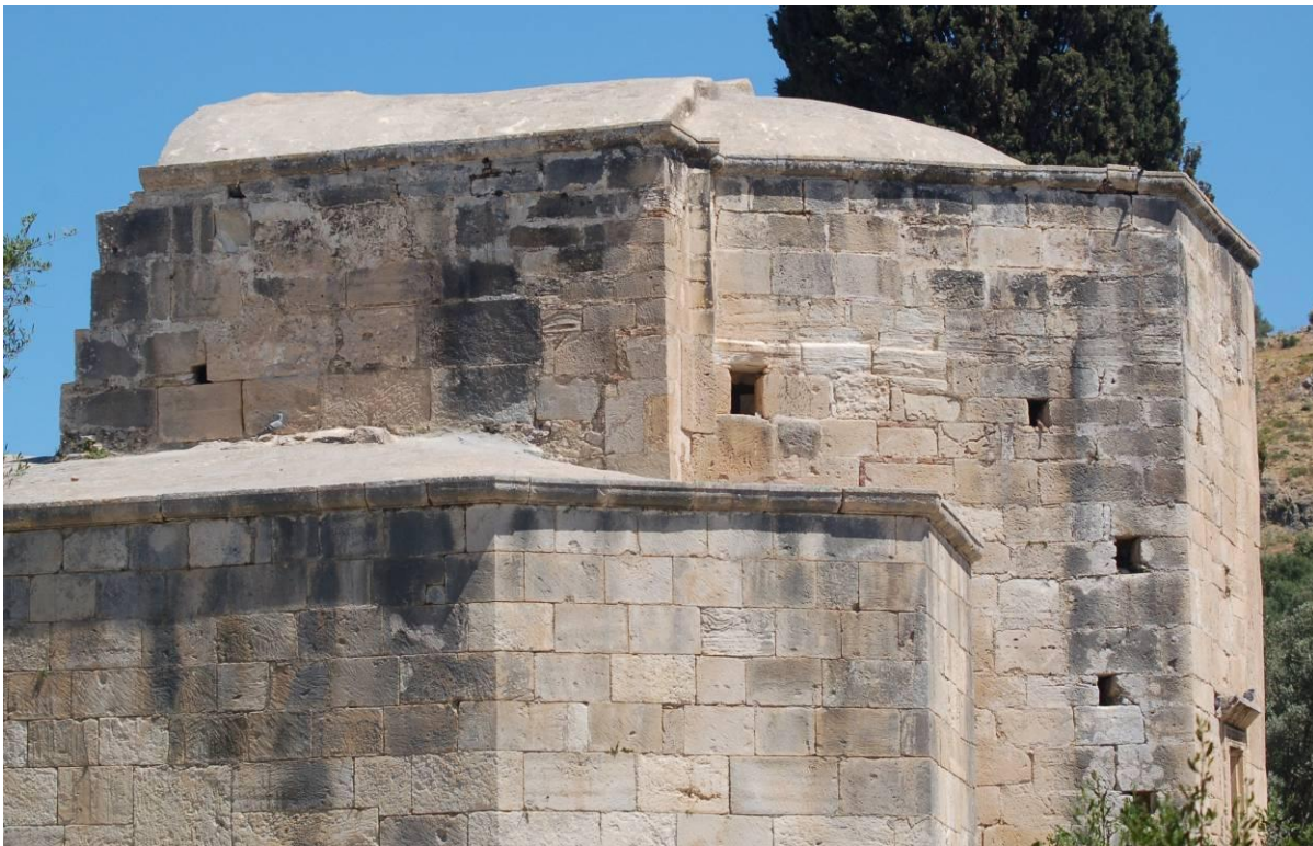
Εικ.25 Γόρτυς Ν. Ηρακλείου Κρήτης, Ναός Αγ. Τίτου. Άποψη των στεγών του ανατολικού τμήματος από τα νότια.
