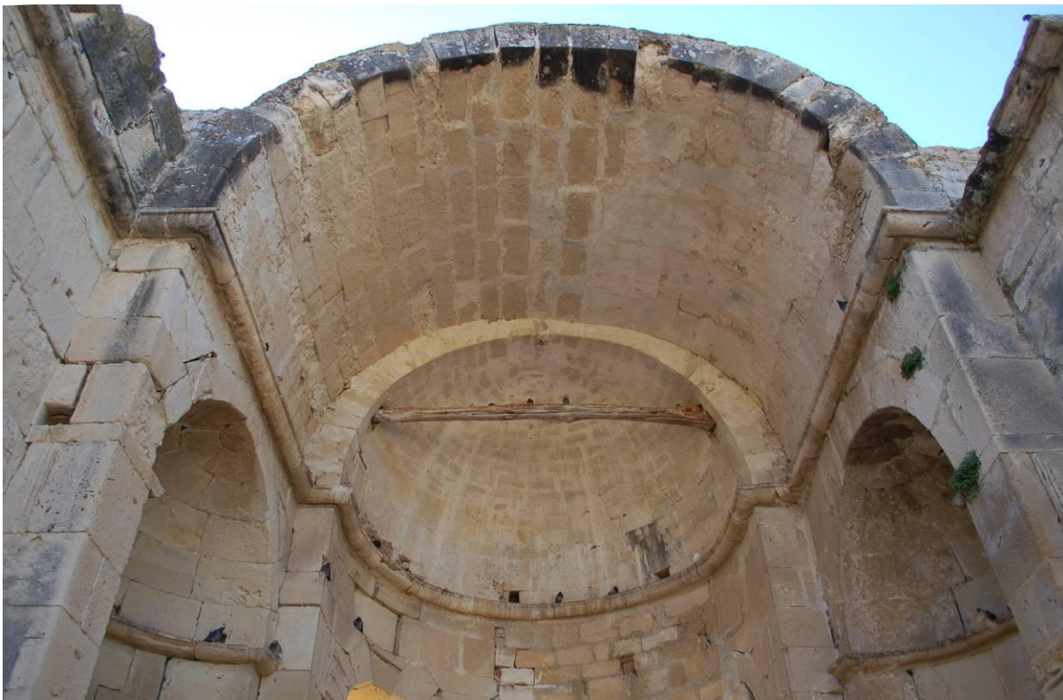
Εικ.31 Γόρτυς Ν. Ηρακλείου Κρήτης, Ναός Αγ. Τίτου. Ιερό Βήμα. Άποψη της θολοδομίας προς τα ανατολικά.
