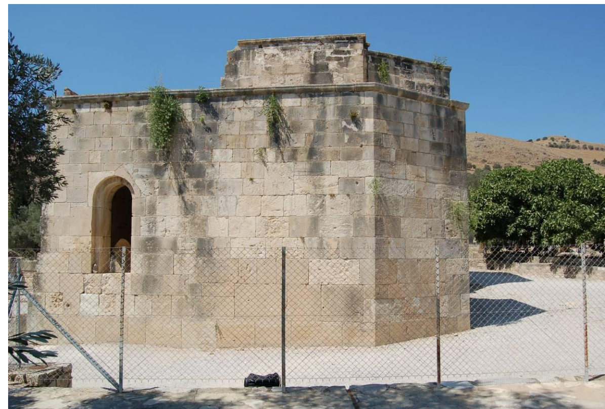
Εικ.24 Γόρτυς Ν. Ηρακλείου Κρήτης, Ναός Αγ. Τίτου. Γενική άποψη του ανατολικού τμήματος της νότιας πλευράς από τα νότια.
