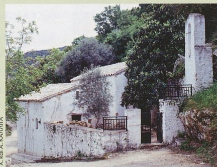
Ναός Κοιμήσεως της Θεοτόκου πριν την αποκατάσταση.
