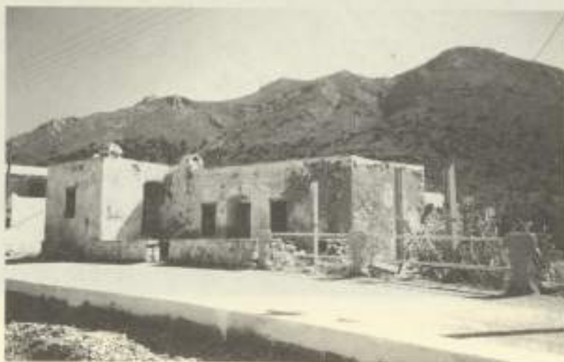
17. Παλιό διασηρητέο κτίριο στα Λιβόδια Τήλου.
