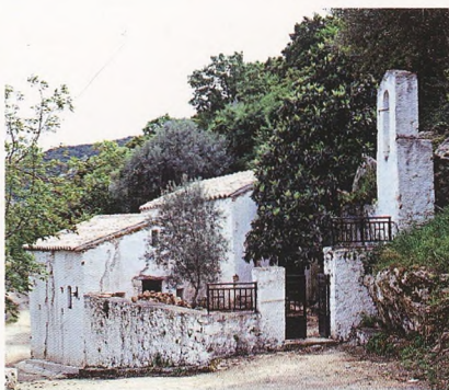
Οι ναοί πριν την αποκατάσταση
