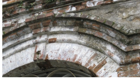
Μαύρη κρούστα, απώλεια ασβεστοκονιάματος και οξείδωση μεταλλικών στοιχείων σε λεπτομέρεια της κεντρικής πόρτας.
