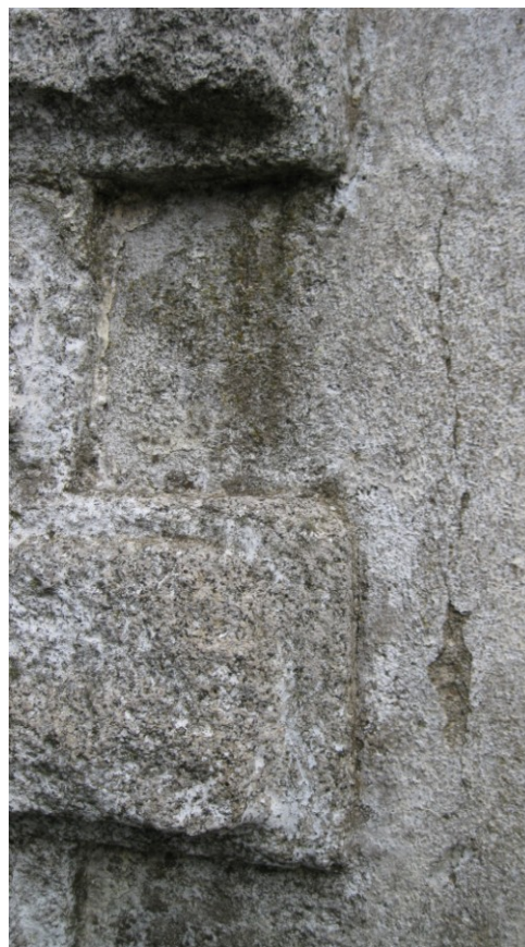
Μαύρη κρούστα και απώλεια υλικού στο γρανίτη.
