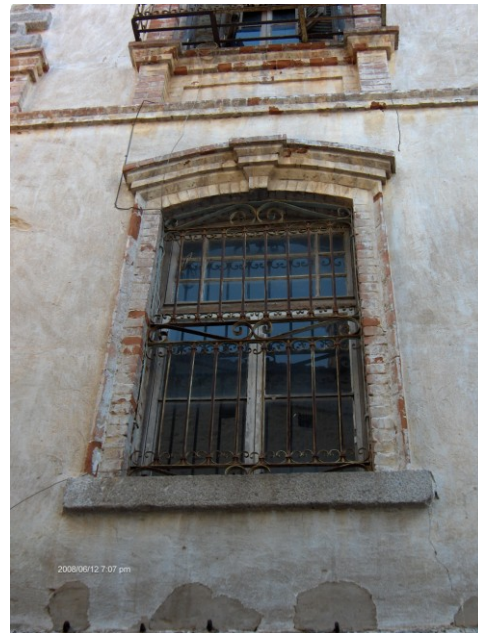
Μαύρη κρούστα, οξείδωση μεταλλικών στοιχείων, προηγούμενες επεμβάσεις συντήρησης, ατμοσφαιρικοί ρύποι και απώλειες ασβεστοκονιαμάτων και ξύλινου υλικού στην πλάγια όψη του κτιρίου.
