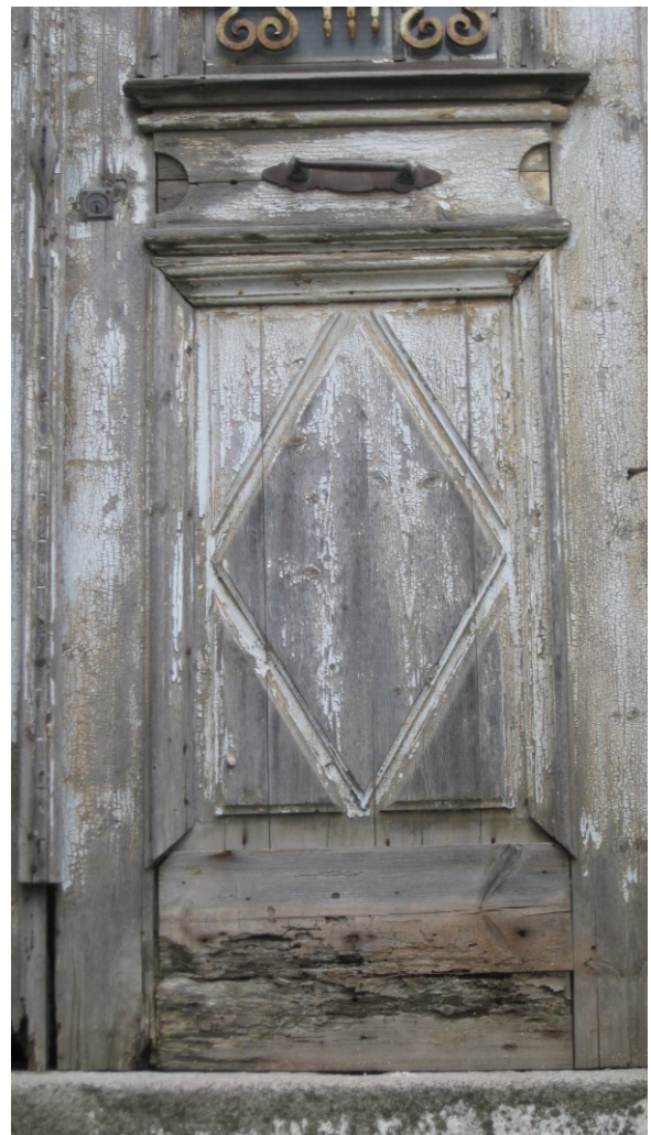
Απώλεια βαφής, απώλεια ξύλινου υλικού, οξείδωση μεταλλικών στοιχείων και ίχνη δυο χρωμάτων βαφής σε λεπτομέρεια της κεντρικής πόρτας.
