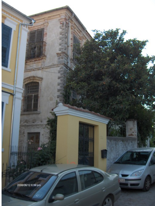
Πλάγια όψη κτιρίου.
