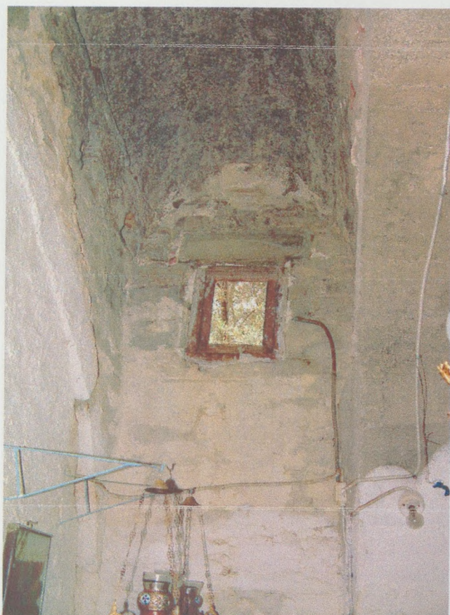
Πιν.1 Η εγκάρσια καμάρα του ναού. Διακρίνεται τμήμα του Α ενισχυτικού τόξου (2005).
