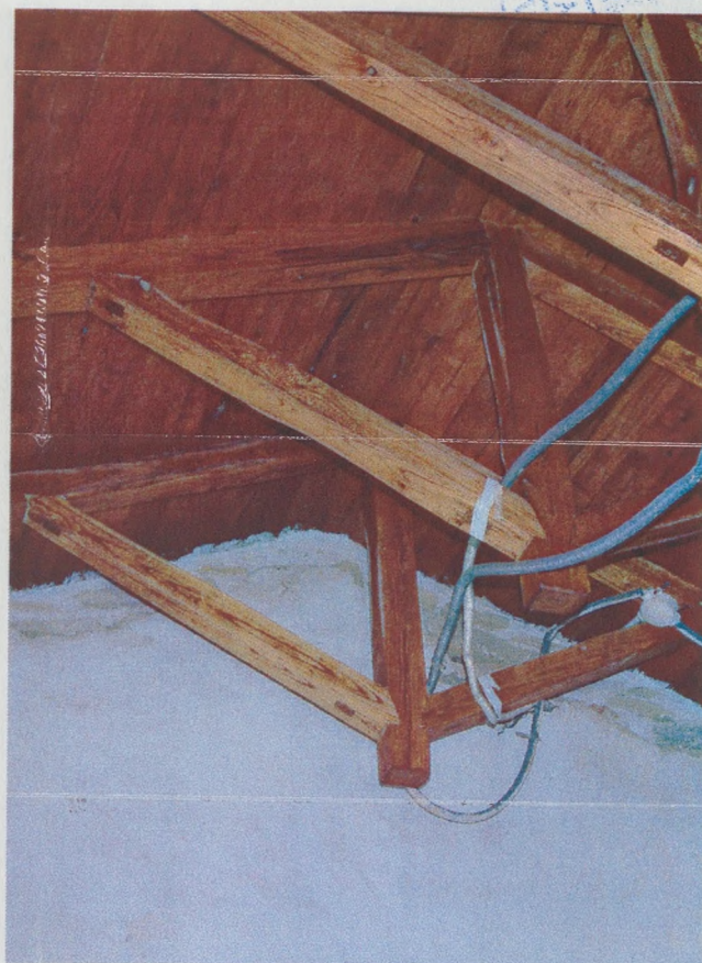
Πιν.2 Η ξύλινη στέγη του νάρθηκα, όπως ανακατασκευάστηκε από την 1η Ε.Β.Α. (2006)
