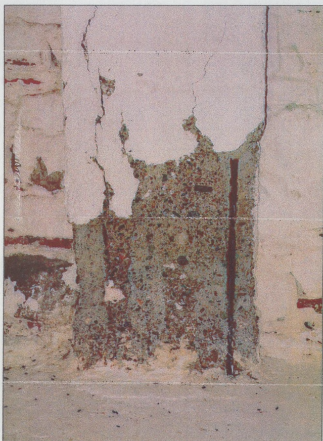
Πιν.35 Χαρακτηριστική εικόνα της παθολογίας των βάσεων των ενισχυτικών τόξων από ΩΣ (2007).
