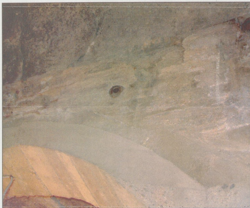
Εικ.35 Άποψη του λίθινου ενισχυτικού τόξου του Δ τμήματος της κατά μήκος καμάρας. Διακρίνεται πάνω από το τόξο από οπλισμένο σκυρόδεμα, που τοποθετήθηκε κατά τις αναστηλωτικές εργασίες του Στίκα το 1953. Δεν είναι δυνατόν να διαγνωστεί η κατάσταση διατήρησής του (2008).
