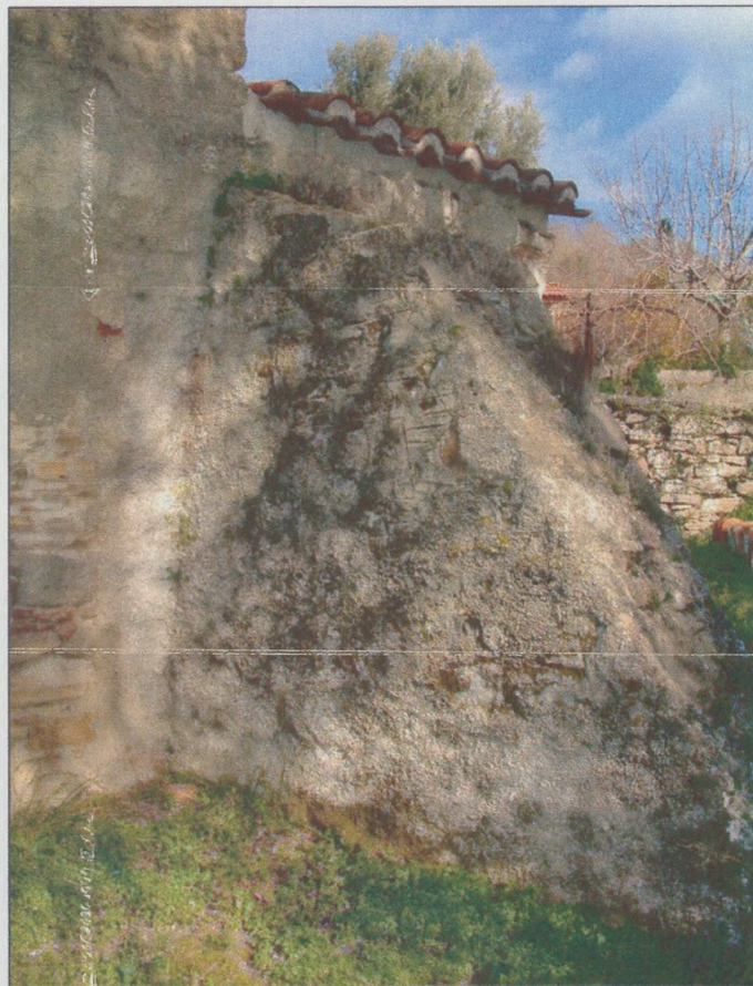
Εικ.39 Μια εκ των αντηρίδων του Στίκα (1953) που τοποθετήθηκε για να συγκρατήσει τον Ν τοίχο του ναού με εμφανή προβλήματα από την υγρασία (2008).
