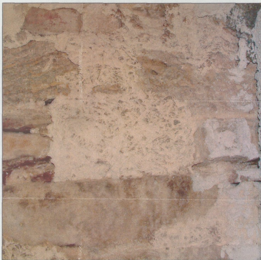
Εικ.33 Κονίαμα που χρησιμοποιείται ως υπόβαθρο για την κατασκευή των τοιχογραφιών (2008).
