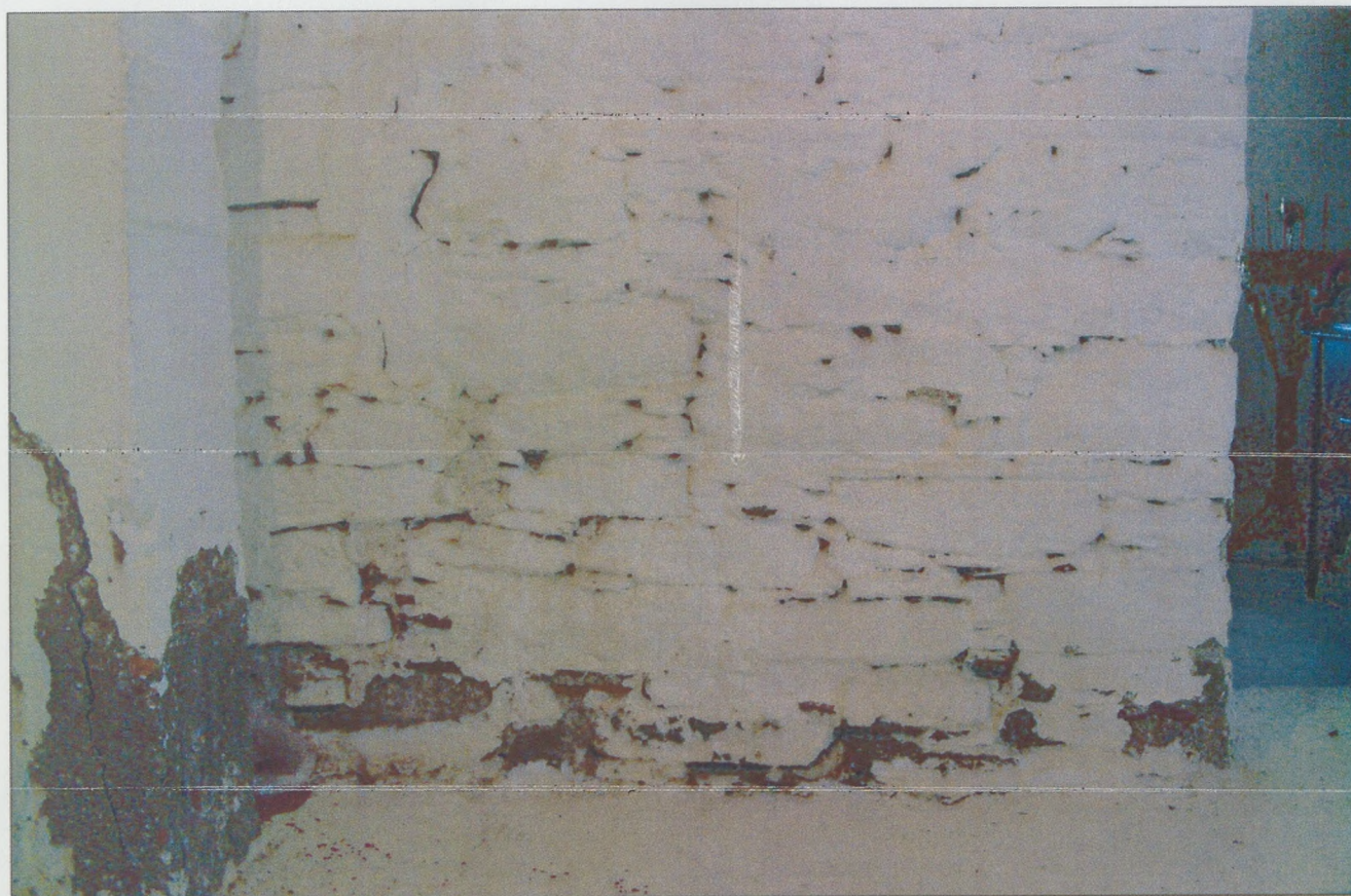
Πιν.28 Δείγμα τοιχοποιίας από τον τοίχο που διαχωρίζει τον νάρθηκα από τον κυρίως ναό (2008).
