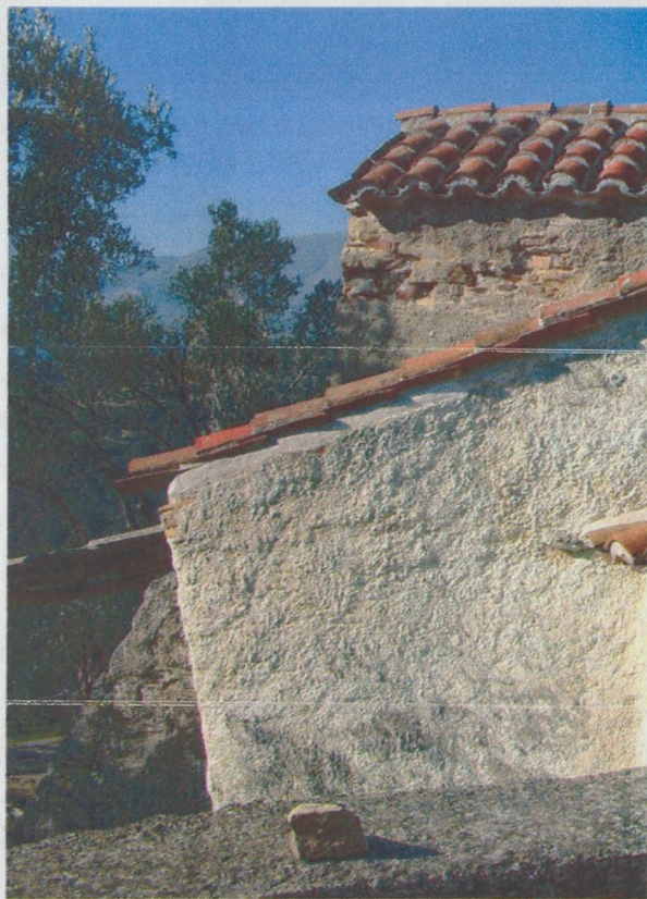
Εικ.38 Η χαρακτηριστική απόκλιση από την κατακόρυφο της ΝΑ γωνίας του ναού (2008).
