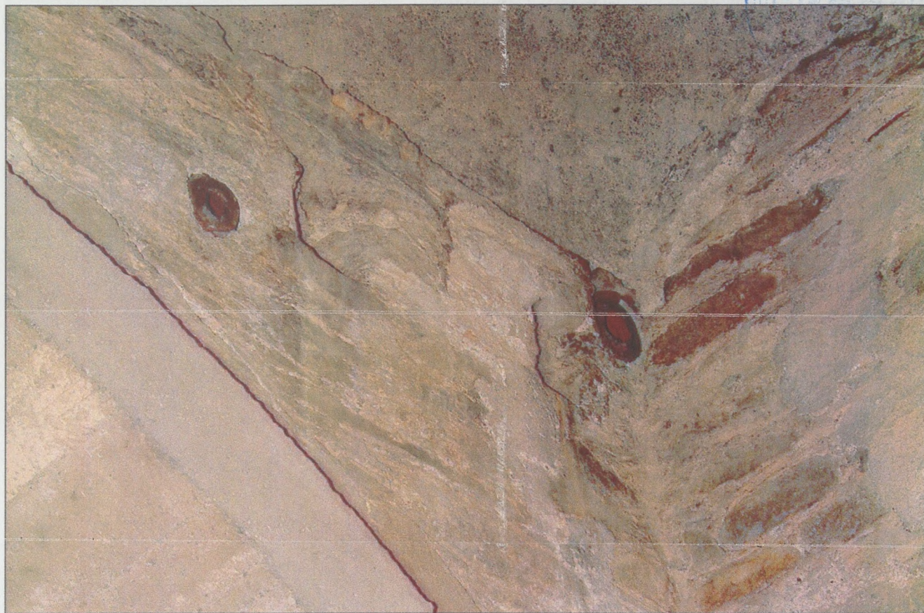
Πιν.33 Άποψη της αλληλοτομίας εγκάρσιας και κατά μήκος καμάρας. Διακρίνονται οι θέσεις του ξυλοτύπου για την κατασκευή της εγκάρσιας καμάρας, καθώς και τα ανοικτά στόμια των πήλινων "ηχείων" (2007).
