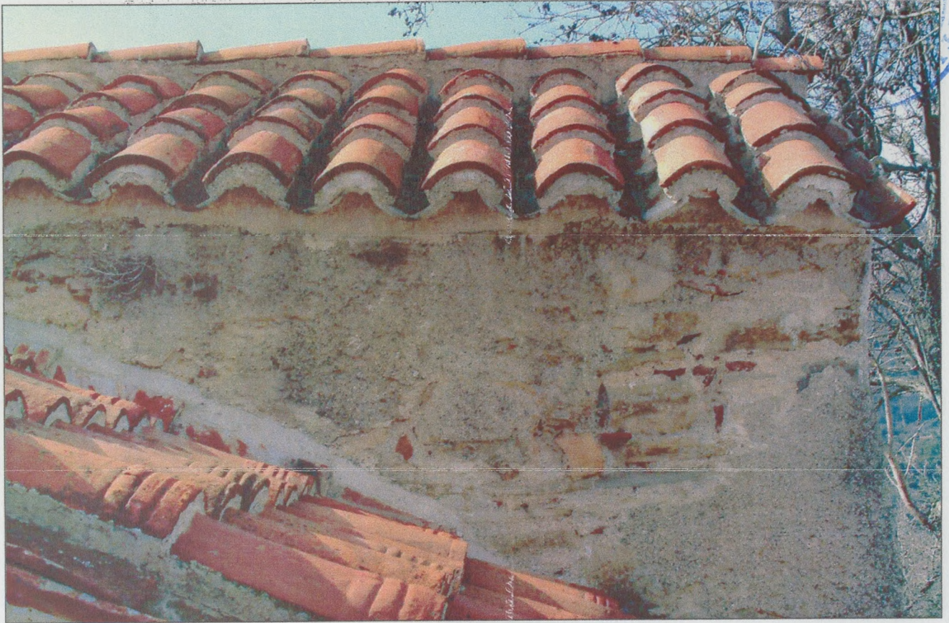
Πιν.31 Εξωτερική άποψη της εγκάρσιας καμάρας από τα Α. Διακρίνεται η ποικιλία των αρμολογημάτων και επιχρισμάτων, που έχουν κατά καιρούς εφαρμοστεί στο μνημείο (2008).
