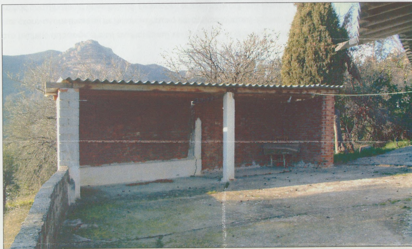
Εικ.37 Το πρόχειρο στέγαστρο στα Δ του ναού, που χρησιμοποιείται σε διάφορες θρησκευτικές εκδηλώσεις (2008).
