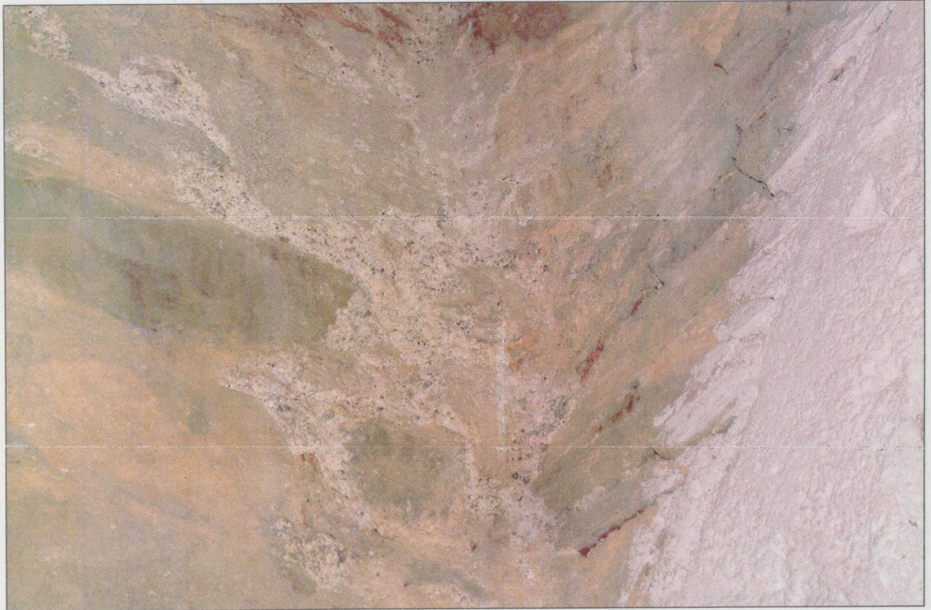
Πιν.32 Εσωτερική άποψη του ναού. Διακρίνεται η ποικιλία των αρμολογημάτων, που έχουν κατά καιρούς εφαρμοστεί στο μνημείο, καθώς και τμήμα του ασβεστομένου λίθινου ενισχυτικού τόξου (2008).
