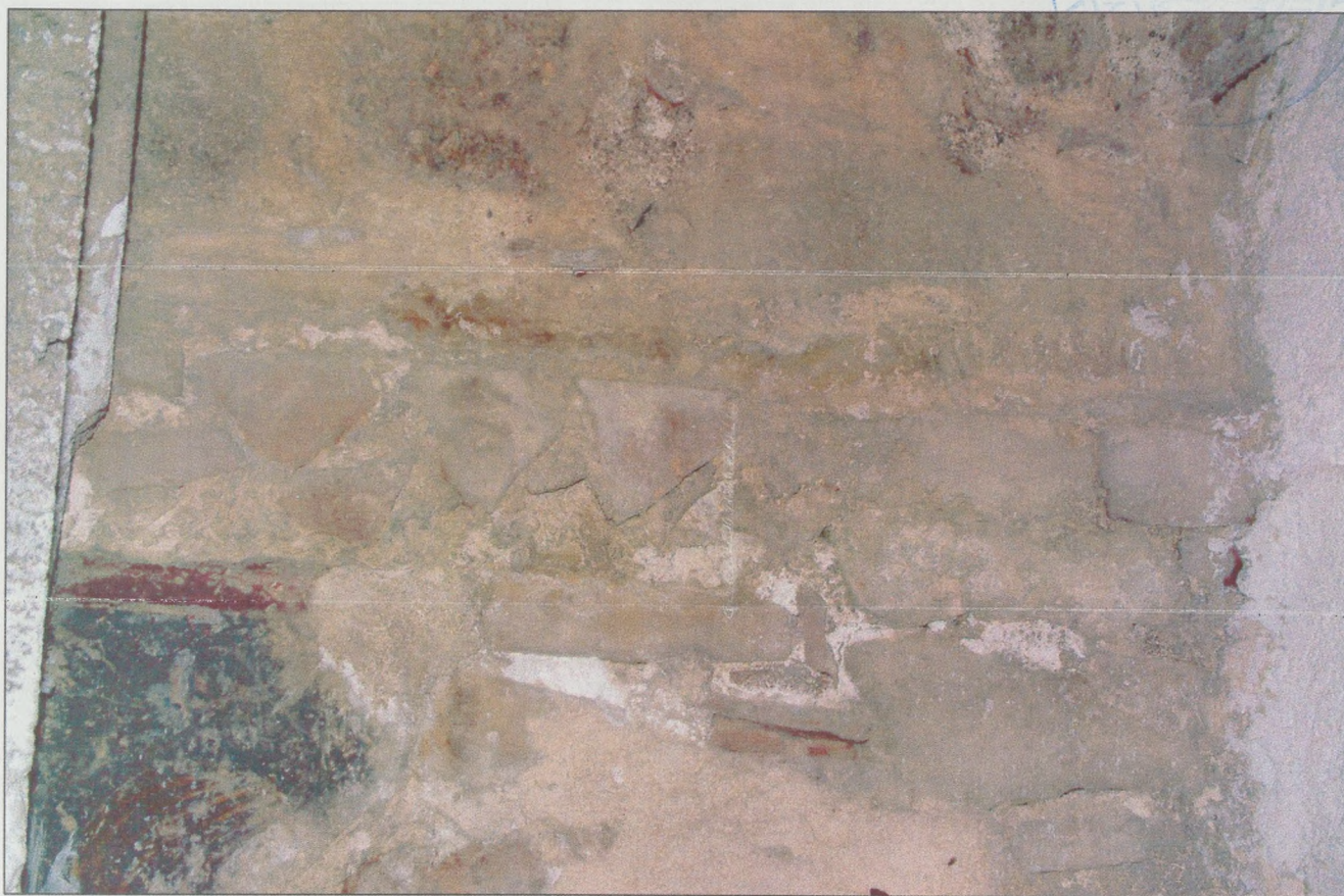
Πιν.15 Ίχνος κατασκευής κοσμήτη στο ύψος της γένεσης της κατά μήκος καμάρας (2008).
