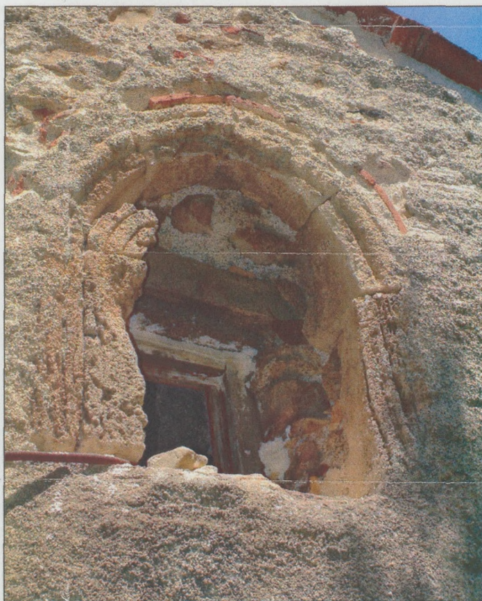
Εικ.16 Άποψη του λίθινου πλαισίου του παραθύρου στο Ν τύμπανο της εγκάρσιας καμάρας του ναού (2006).
