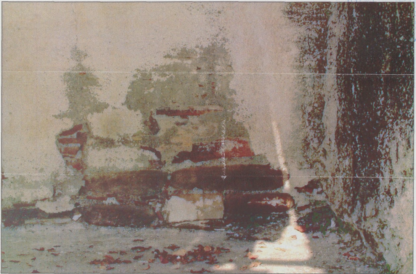
Πιν.29 Προβλήματα στην εξωτερική παρειά της τοιχοποιίας, λόγω ανερχόμενης υγρασίας (2008).
