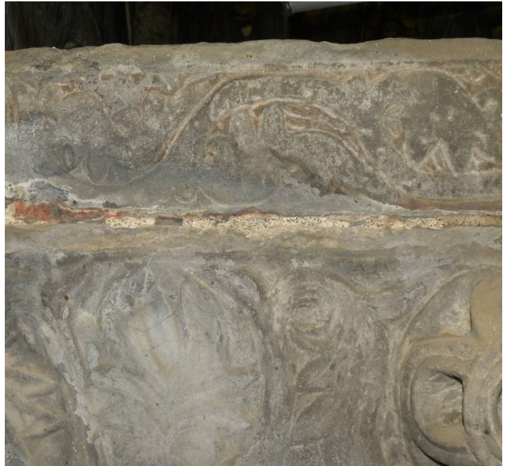
Εικ. 8. Στο αρμό διακρίνεται κονίαμα παρόμοιο με το κονίαμα δομής που βρέθηκε στην κατασκευή των τοιχοποιιών.
