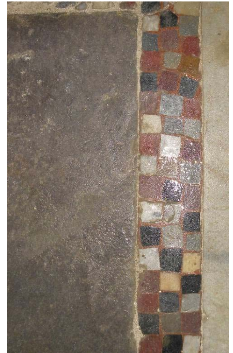
Εικ.22. Λεπτομέρεια από το δάπεδο το κονίαμα των μαρμαροθετημάτων είναι ερυθρωπό, εξαιρετικά σταθερό, συμπαγές και από τη χρήση, έχει γίνει λείο.
