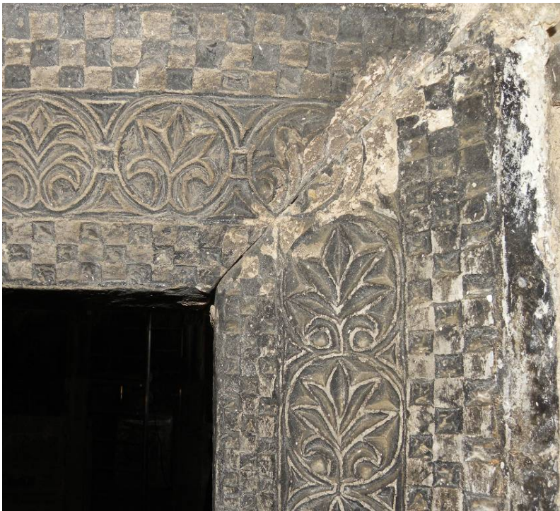
Εικ.13. Λεπτομέρεια από το θύρωμα της Δ. εισόδου διακρίνονται οξειδωμένες λιπαρές ουσίες, που έχουν αναμειχθεί με την αιθάλη.
