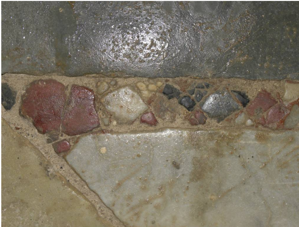
Εικ.21. Λεπτομέρεια από το δάπεδο, στα μαρμαροθετήματα παρατηρούνται κάποιες ελλείψεις και θραύσεις σε ορισμένες από τις έγχρωμες ψηφίδες.
