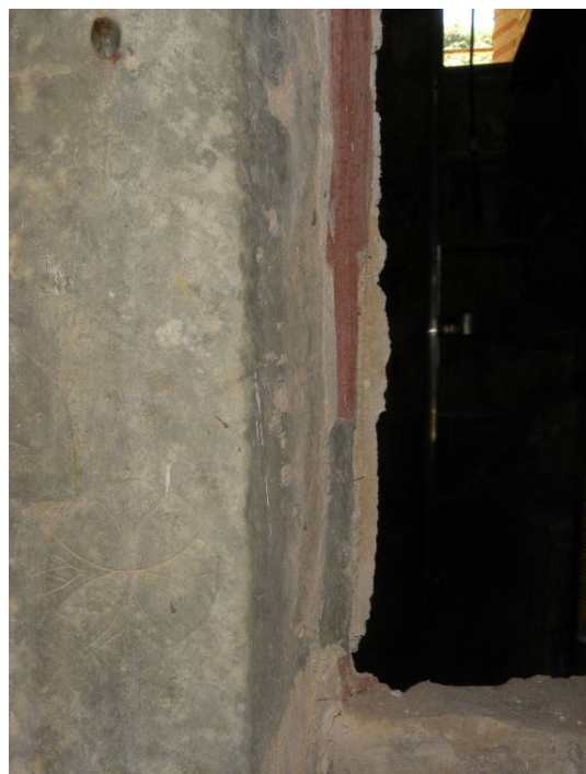
Εικ.18. Λεπτομέρεια από το τέμπλο, διακρίνονται τα κατάλοιπα του κονιάματος με το οποίο είχαν εντοιχιστεί οι Δεσποτικές εικόνες.
