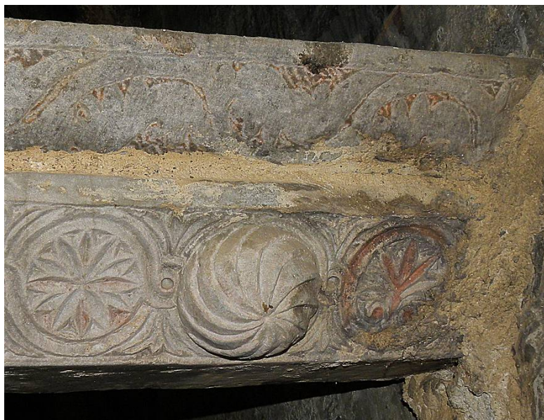
Εικ.5. Λεπτομέρεια από το Ν. τμήμα του τέμπλου όπου διακρίνονται κατάλοιπα της αυθεντικής βαφής στο βάθος του ανάγλυφου..
