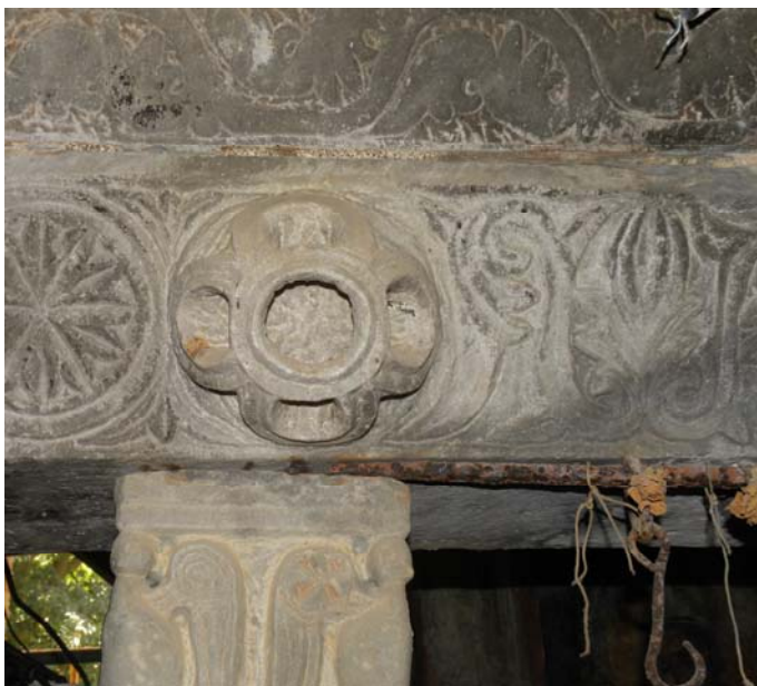
Εικ.19. Λεπτομέρεια του τέμπλου, τα ενσφηνωμένα μεταλλικά στοιχεία έχουν οξειδωθεί σχηματίζοντας κηλίδες στα μαρμάρινα μέλη.
