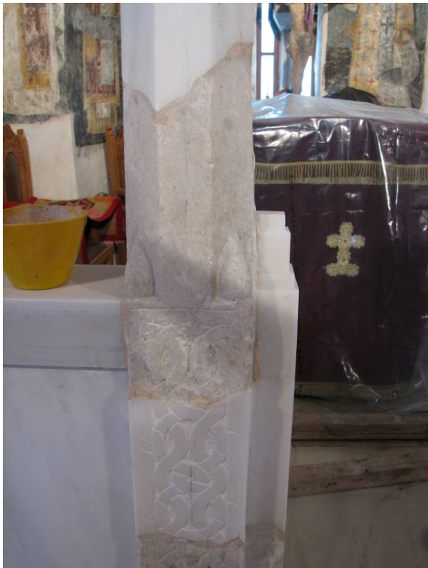
Εικ.27. Τα ελλείποντα τμήματα, μπορούν να συμπληρωθούν με τη λήψη εκμαγείων των θραυσσιγενών επιφανειών και τη διαμόρφωση νέων μαρμάρινων συμπληρωμάτων.
