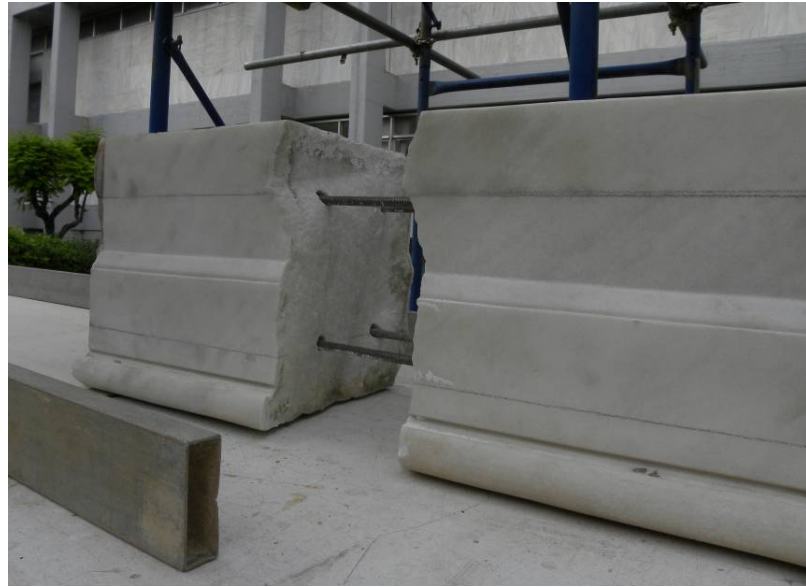
Εικ.26. Κατά τη συγκόλληση τοποθετούνται εσωτερικά καρφίδες ανοξείδωτου μετάλλου οι οποίες δεν εμφανίζονται στις εξωτερικές επιφάνειες.
