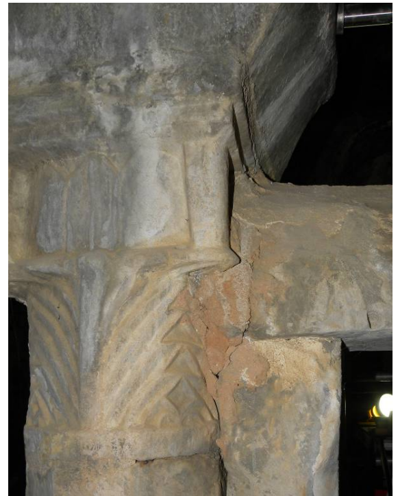
Εικ.14. Λεπτομέρεια από την εσωτερική όψη του ΒΑ κιονοκράνου διακρίνονται αποθέσεις αλάτων που έχουν σχηματίσει κρούστες.
