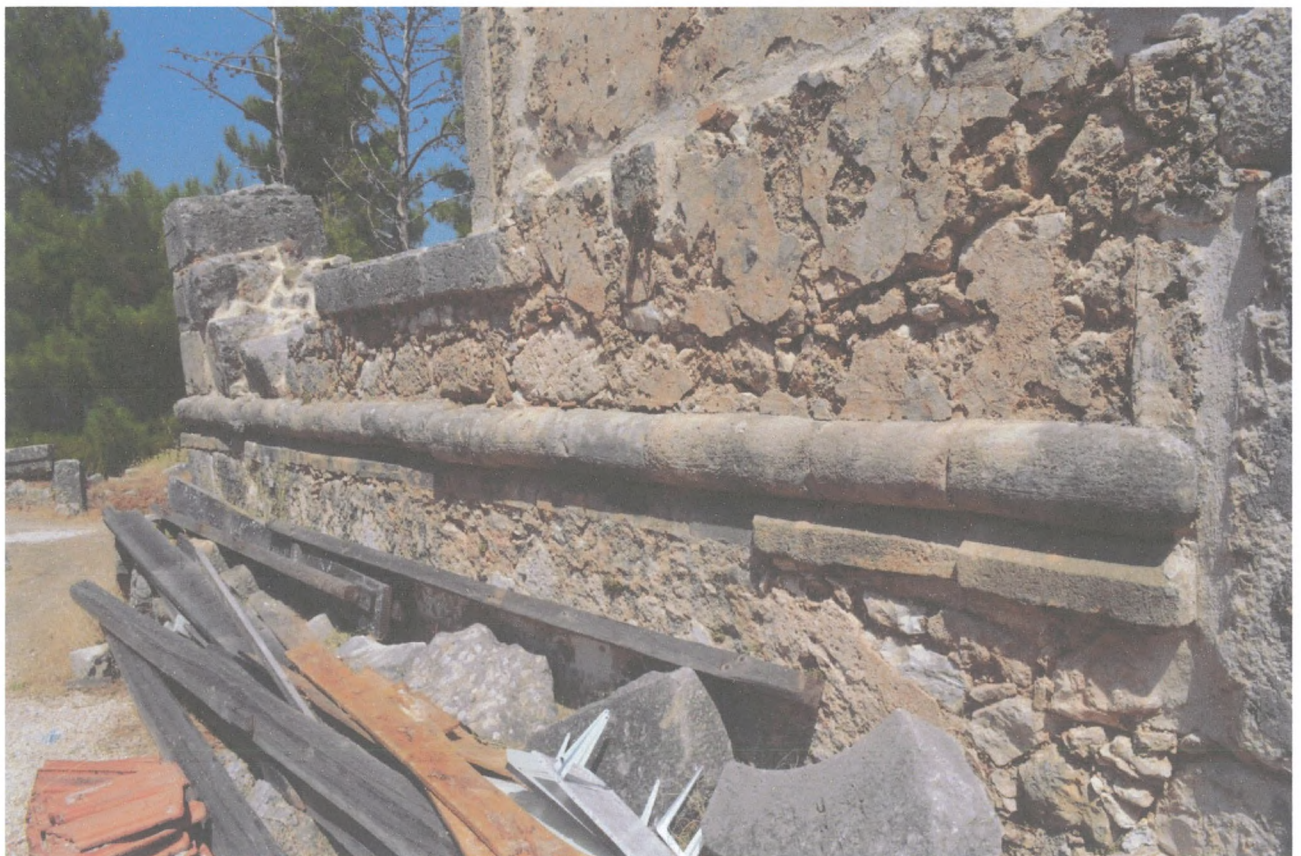
Φωτ.13 Ο κοσμήτης (cordone) κάτω από τα παράθυρα, στο δυτικό τμήμα του νότιου τοίχου.
