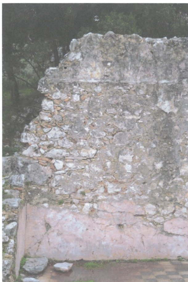
Φωτ.100 Το δυτικό άκρο της βόρειας πλευράς.
