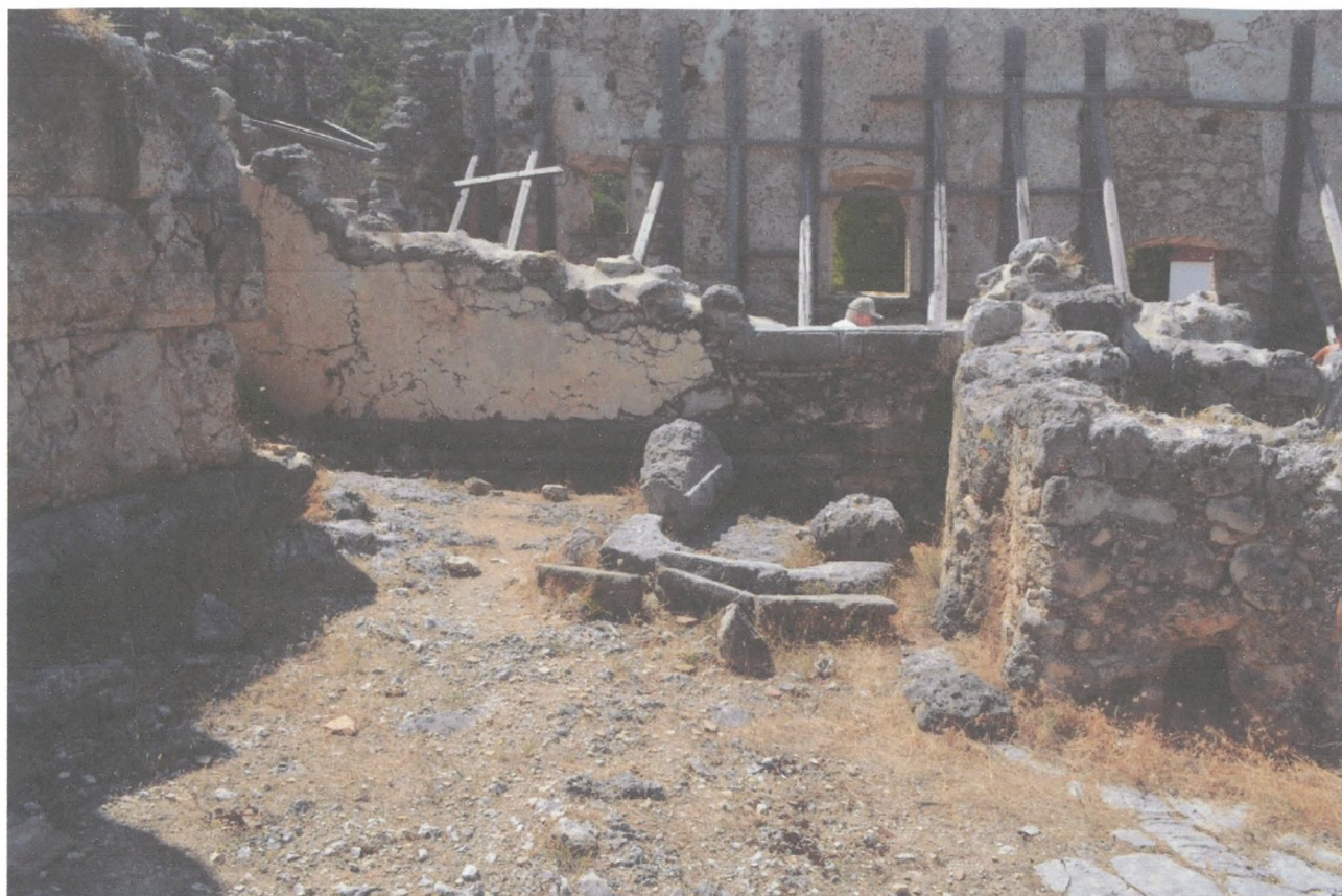
Φωτ.49 Το ανατολικό τμήμα του βόρειου τοίχου. Διακρίνεται η ποδιά του παραθύρου ΠΒ2 στην θέση της και τα υπόλοιπα μέλη του πλαισίου στο δάπεδο.
