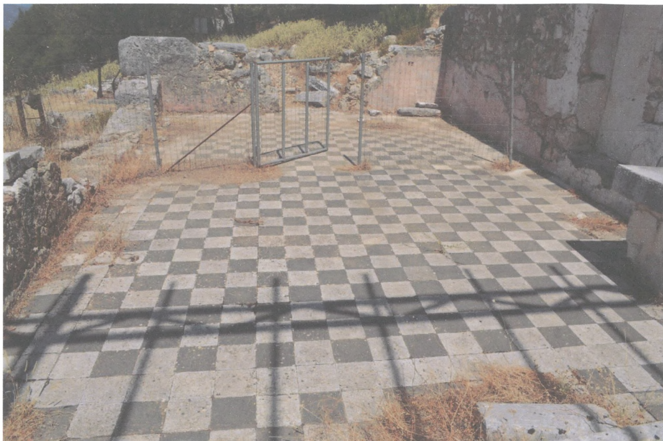
Φωτ.117 Το δυτικό τμήμα του ναού.
