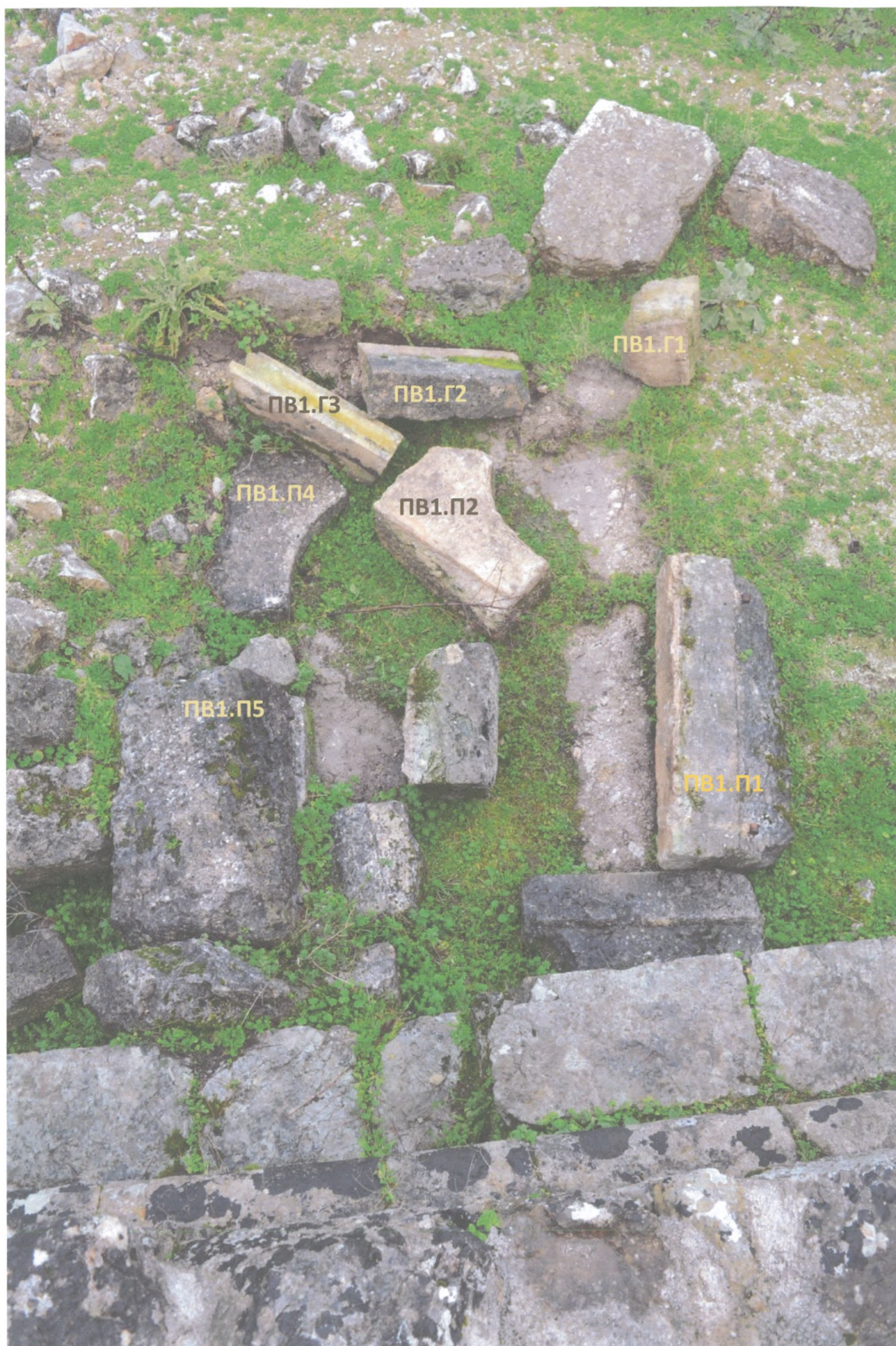
Φωτ.93 Μέλη του λίθινου πλαισίου (ΠΒ1.Π1), (ΠΒ1.Π2), (ΠΒ1.Π4), (ΠΒ1.Π5), και του λίθινου γείσου (ΠΒ1.Γ1), (ΠΒ1.Γ2), (ΠΒ1.Γ3) από το δυτικό παράθυρο της βόρειας πλευράς (ΠΒ1).
