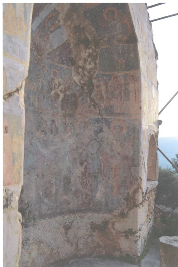
Φωτ.111 Άποψη της κόγχης του ιερού από τα βορειοδυτικά.
