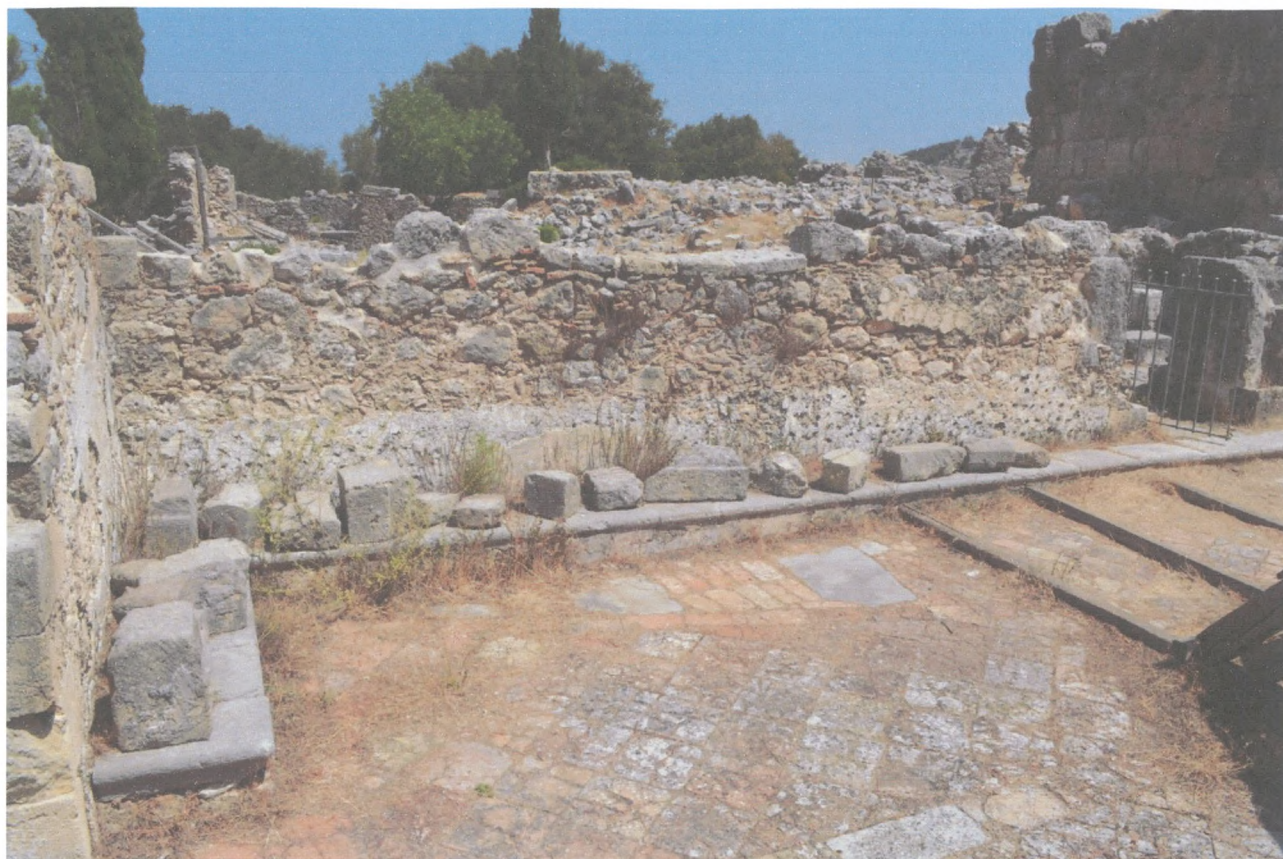
Φωτ.52 Το δυτικό τμήμα του βόρειου τοίχου από το εσωτερικό. Διακρίνεται η ποδιά του παραθύρου ΠΒ1.
