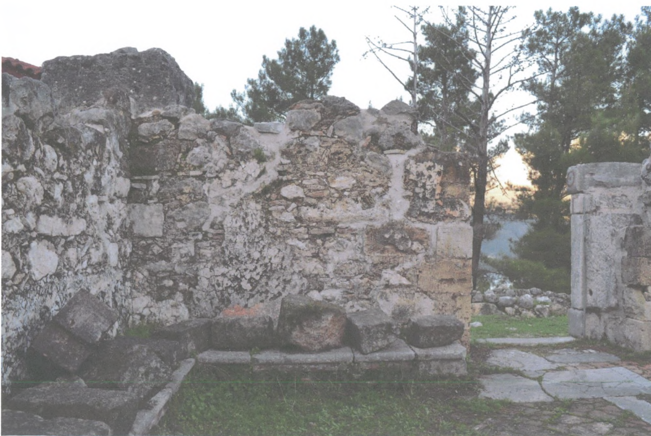
Φωτ.41 Το νότιο τμήμα του δυτικού τοίχου από το εσωτερικό του ναού.
