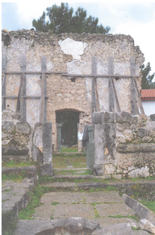
Φωτ.47 Η βόρεια θύρα.
