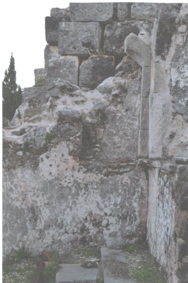
Φωτ.59 Η κόγχη στο ανατολικό άκρο του βόρειου τοίχου.
