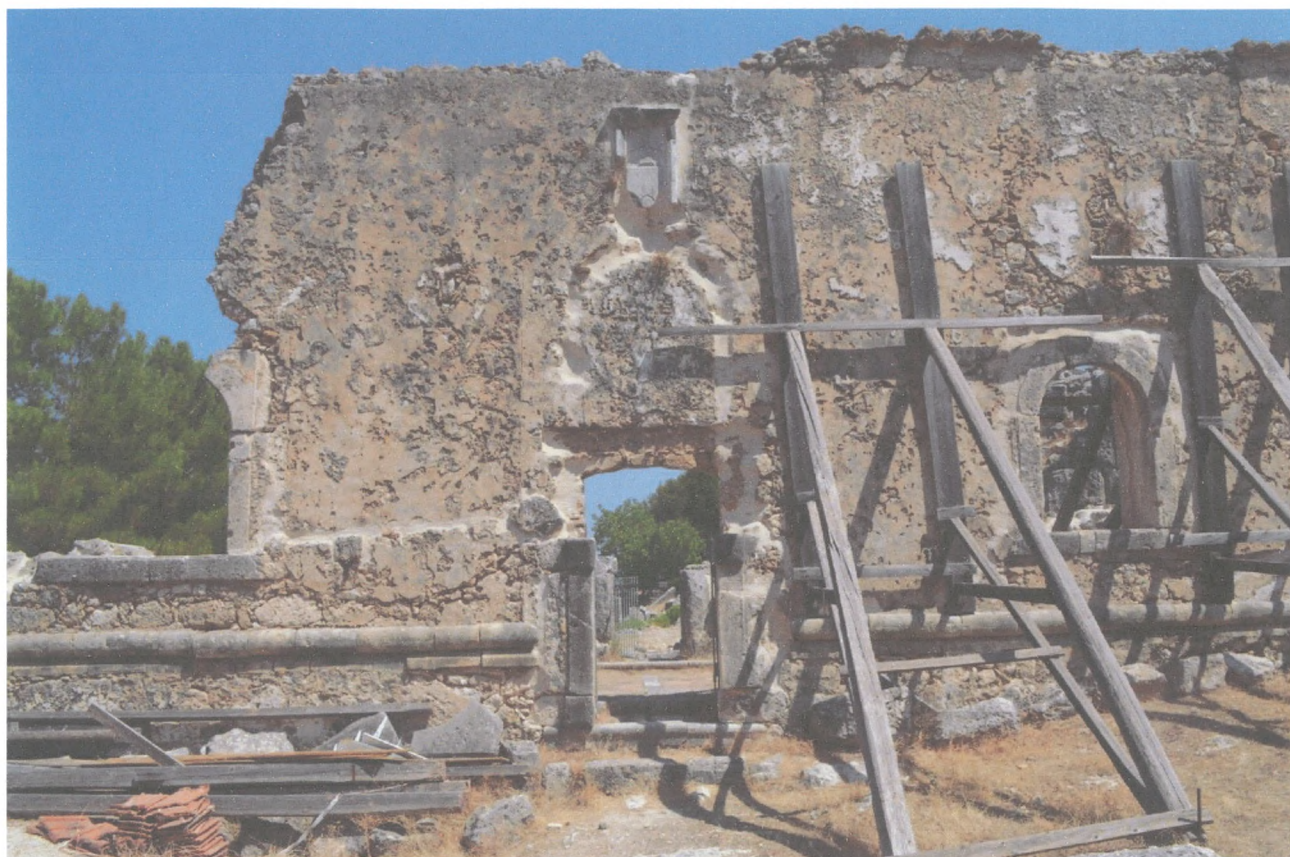
Φωτ.14 Το κεντρικό τμήμα της νότιας όψης.
