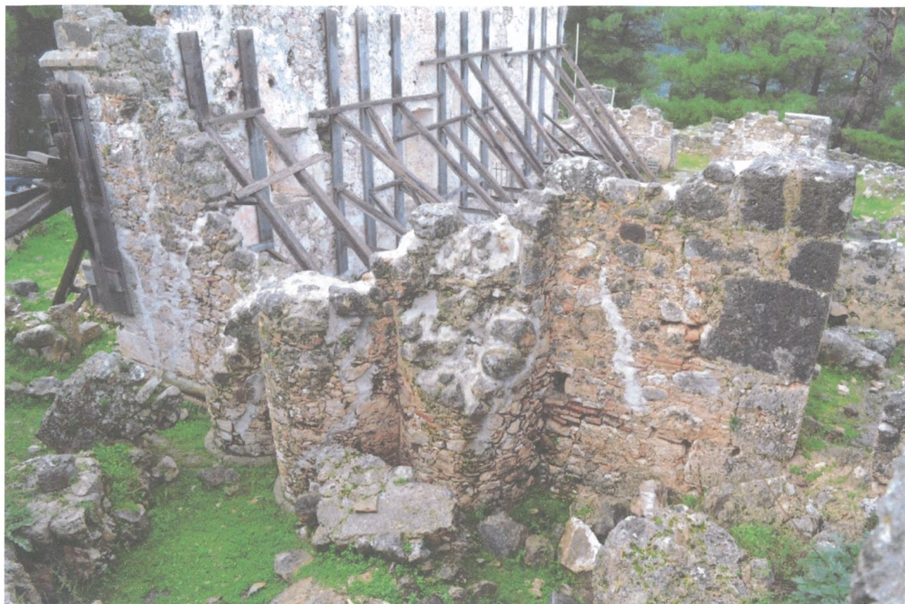
Φωτ.61 Γενική άποψη της ανατολικής πλευράς.
