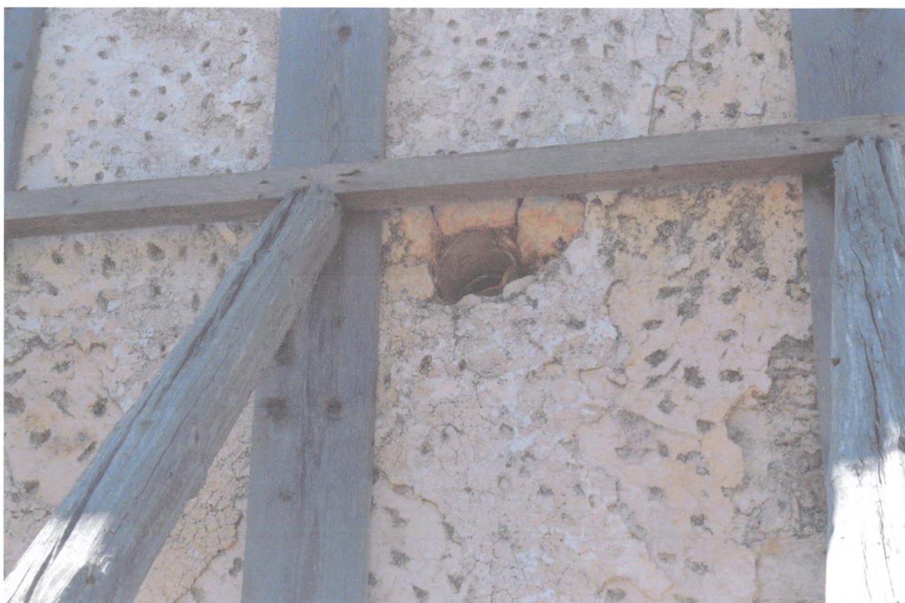
Φωτ.31 Στόμιο «χηρτικού αγγείου» στον νότιο τοίχο.
