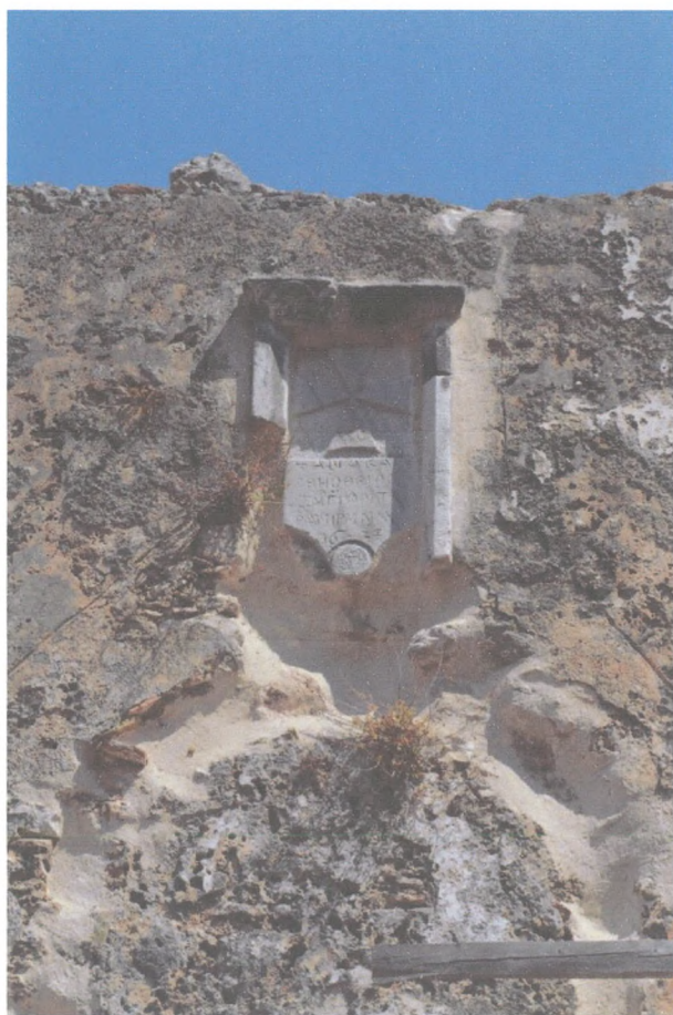
Φωτ.15 Η κτητορική επιγραφή πάνω από τη νότια θύρα.
