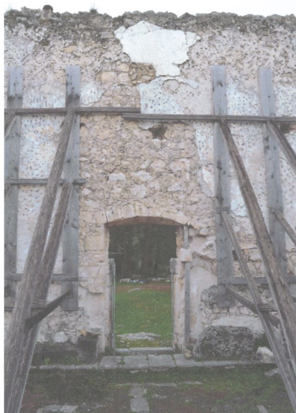
Φωτ.27 Η νότια θύρα από το εσωτερικό του ναού.
