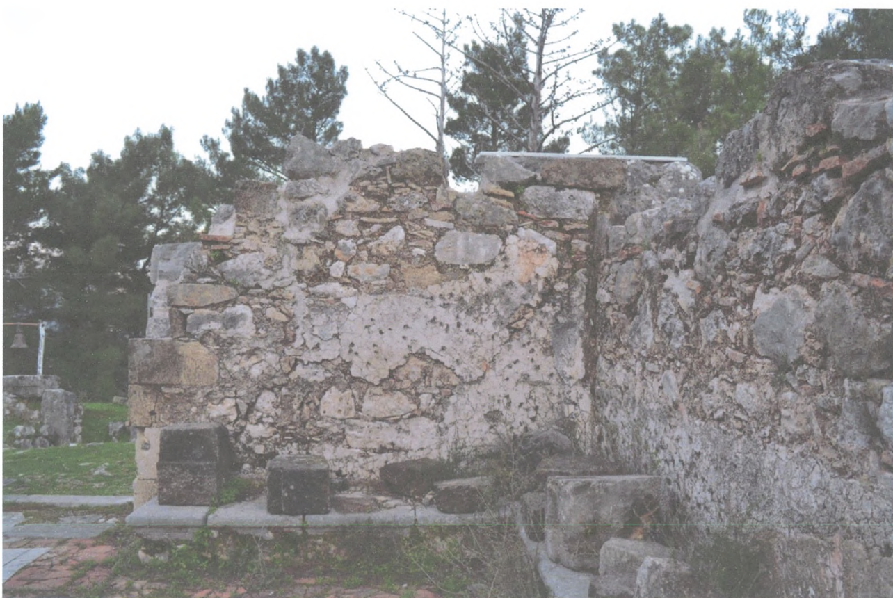
Φωτ.43 Το βόρειο τμήμα του δυτικού τοίχου από το εσωτερικό του ναού.
