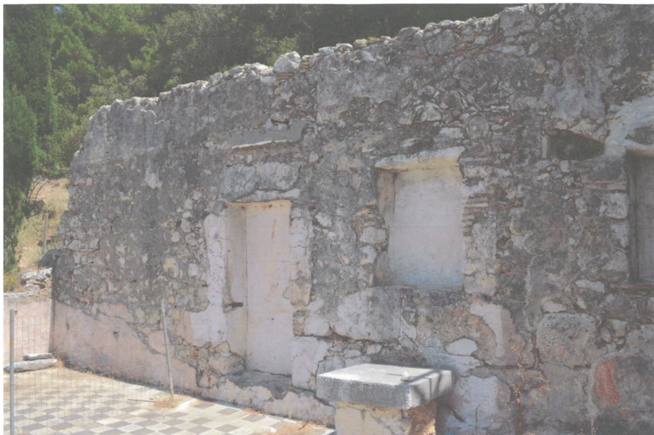
Φωτ.99 Το δυτικό τμήμα της βόρειας πλευράς.
