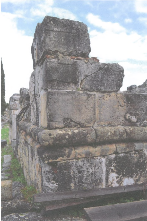
Φωτ.11 Η νοτιοδυτική γωνία του καθολικού.
