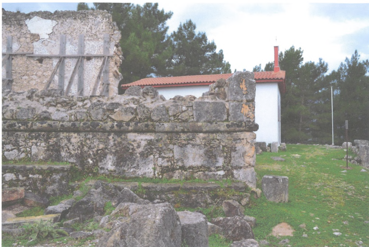
Φωτ.44 Το δυτικό άκρο της βόρειας όψης του καθολικού.
