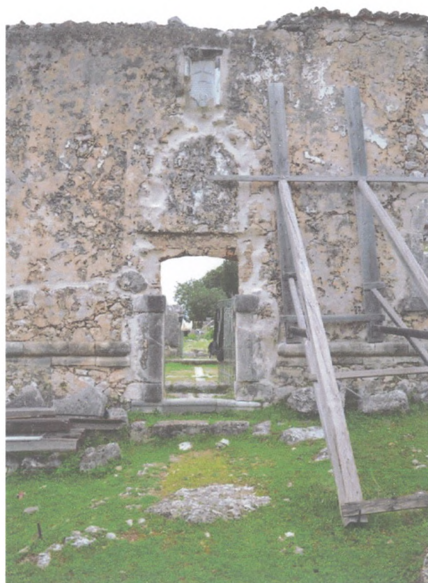
Φωτ.16 Η νότια θύρα του καθολικού.
