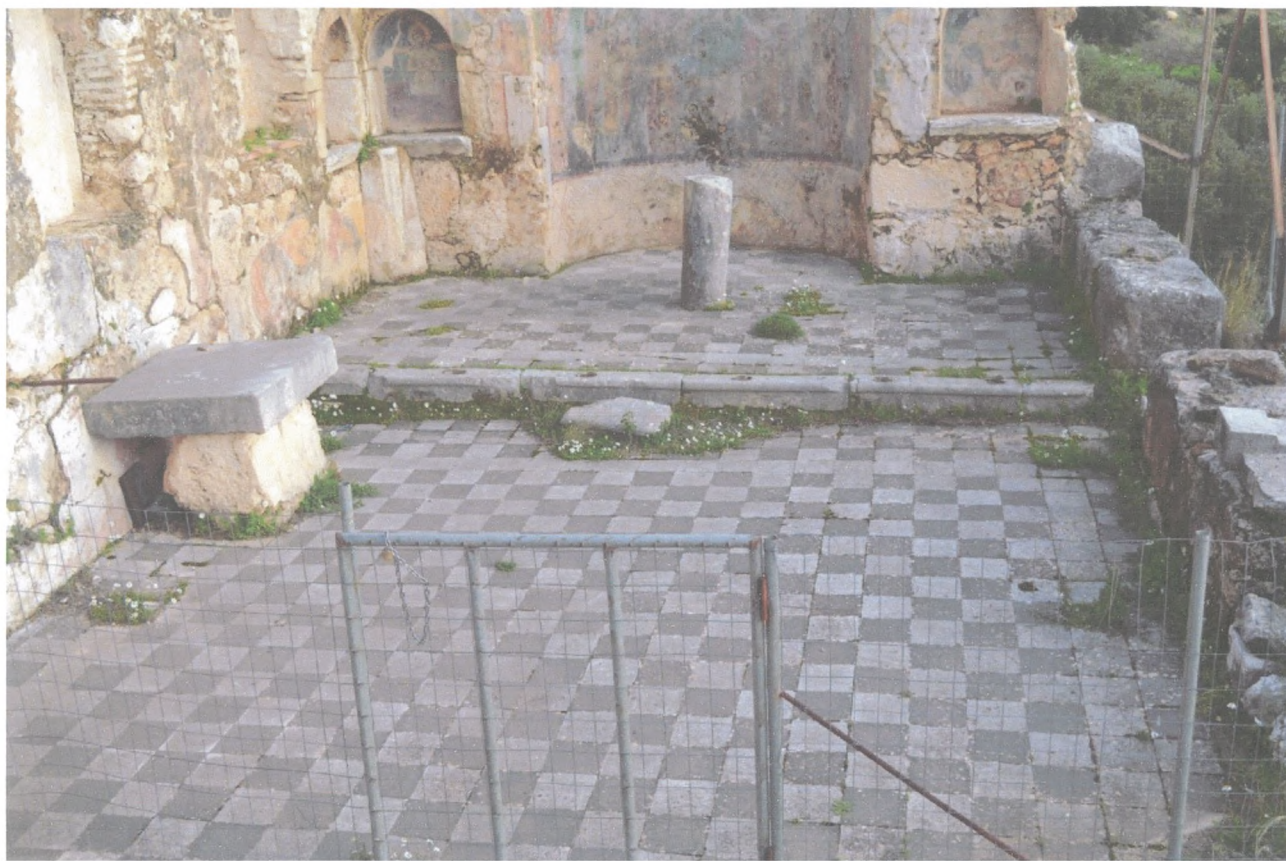
Φωτ.119 Το ανατολικό τμήμα του ναού. Διακρίνεται ο κίονας της αρχικής Αγίας Τράπεζας, η λίθινη βαθμίδα του ιερού με εγκοπές για την στερέωση του τέμπλου και η νεώτερη Τράπεζα στην βόρεια πλευρά.
