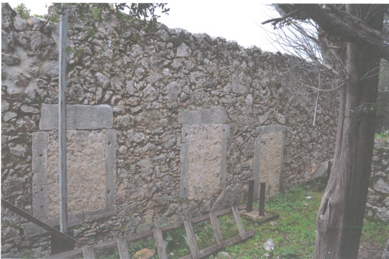
Φωτ.108 Η βόρεια πλευρά του ναού.
