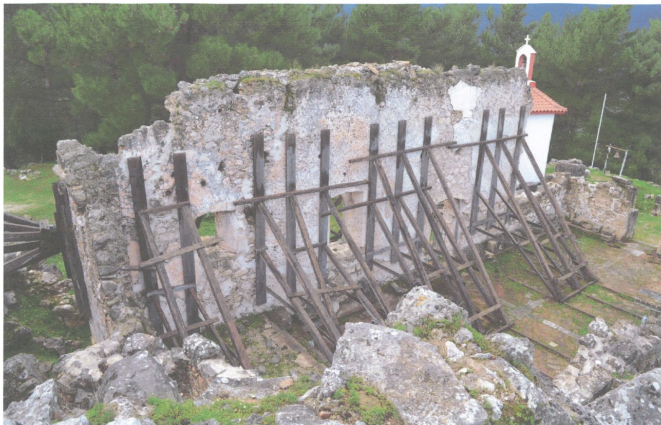
Φωτ.23 Γενική άποψη του νότιου τοίχου από τον πύργο στα βορειοανατολικά.
