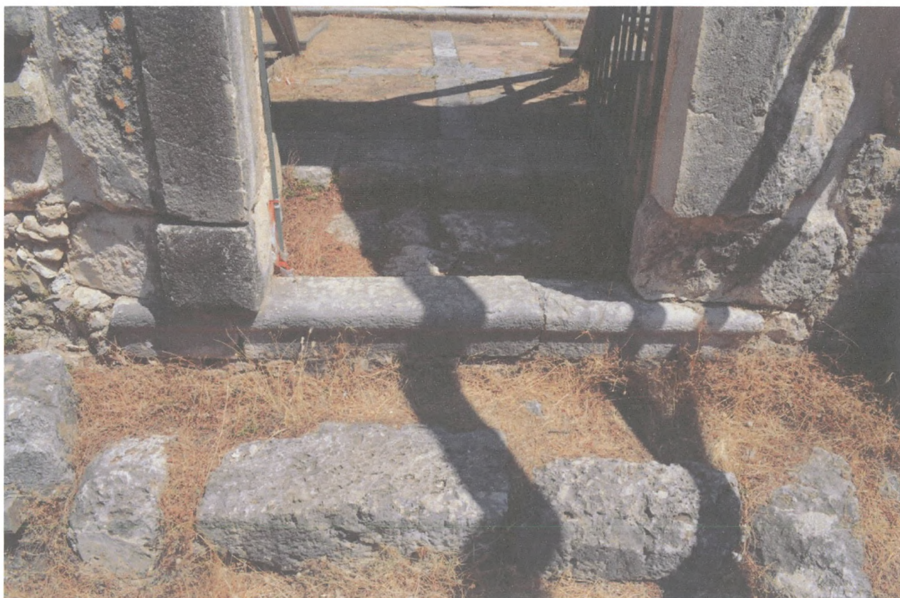
Φωτ.18 Το κάτω τμήμα της νότιας θύρας.
