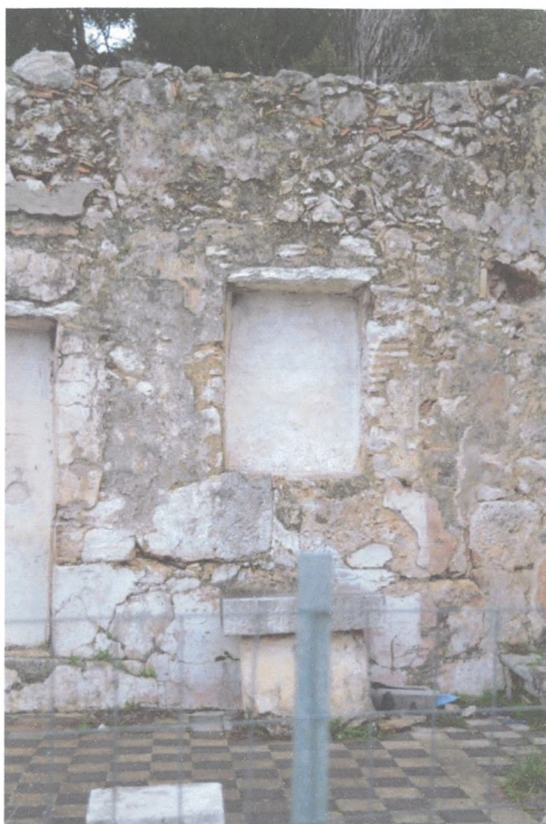
Φωτ.102 Το τοιχισμένο βόρειο παράθυρο του κυρίως ναού από το εσωτερικό.
