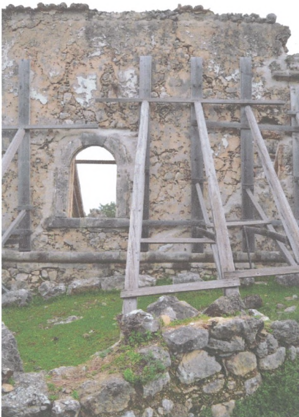
Φωτ.19 Το ανατολικό παράθυρο της νότιας πλευράς (ΠΝ2).
