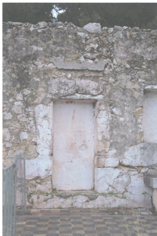
Φωτ.101 Η τοιχισμένη βόρεια θύρα από το εσωτερικό του ναού.
