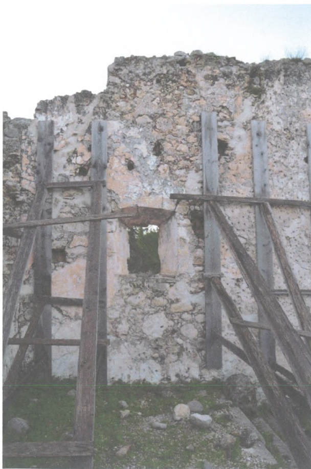
Φωτ.24 Το ανατολικό άκρο του νότιου τοίχου.
