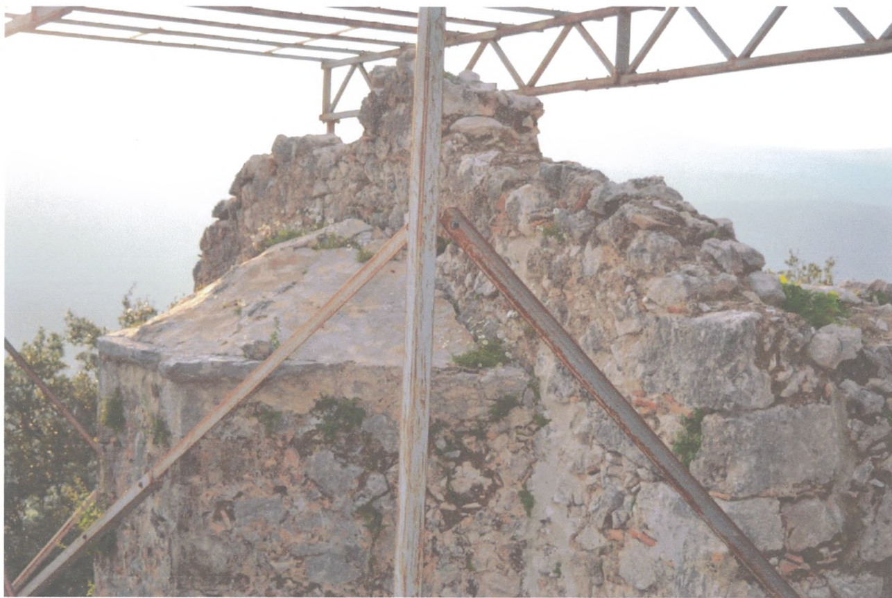
Φωτ.114 Η στέγη του τεταρτοσφαιρίου της κόγχης και η απόληξη του ανατολικού τοίχου.
