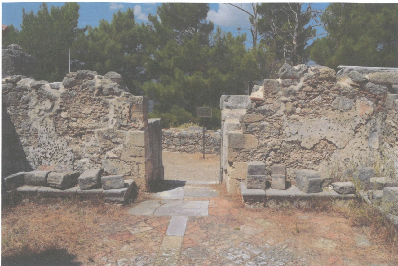
Φωτ.40 Ο δυτικός τοίχος από το εσωτερικό του ναού.
