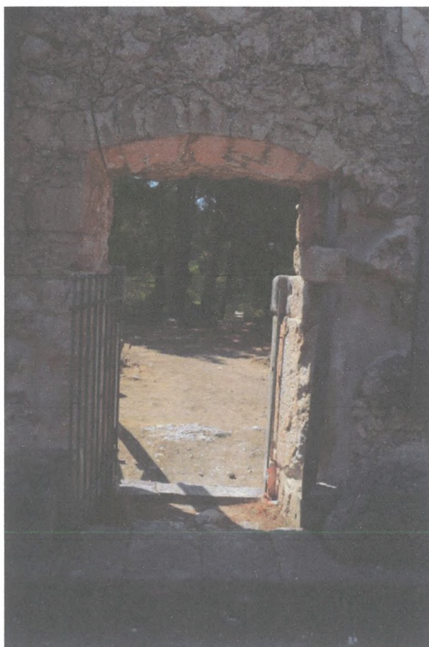
Φωτ.28 Η νότια θύρα από το εσωτερικό του ναού.
