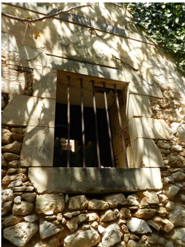
Εικ. 10, 11. Απόπτωση των επιχρισμάτων και απόπλυση των συνδετικών κονιαμάτων. Λεπτομέρεια από το νότιο τοίχο της νότιας πτέρυγας.
