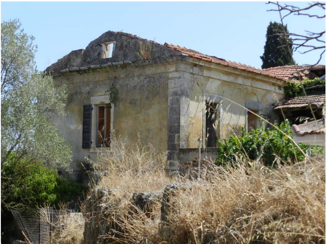
Εικ. 5. Ανατολική πτέρυγα της οικίας Βαλλιάνου. Διακρίνεται η αετωματική απόληξη (ατσούπι) του βόρειου τοίχου, καθώς και μέρος του εξώστη, που προσαρτάται στη δυτική πλευρά της πτέρυγας.
