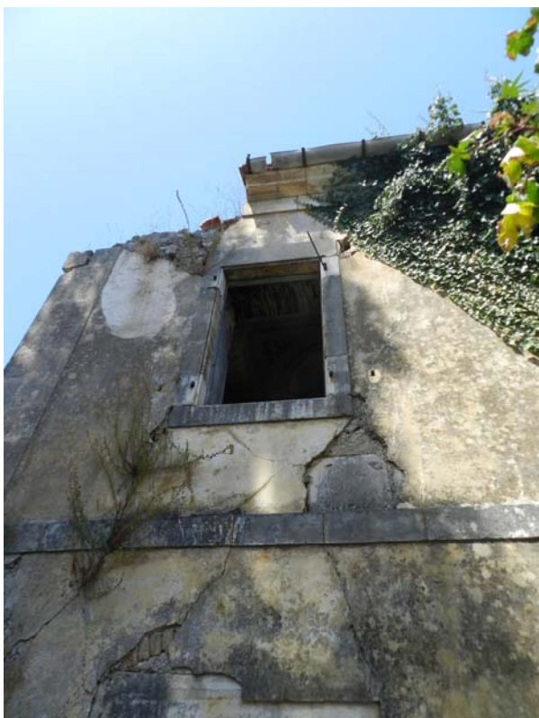
Εικ. 8, 9. Ρηγματώση των εξωτερικών τοίχων (επιχρισμένων αργολιθοδομών) και τοπικές απώλειες υλικού άνω.
