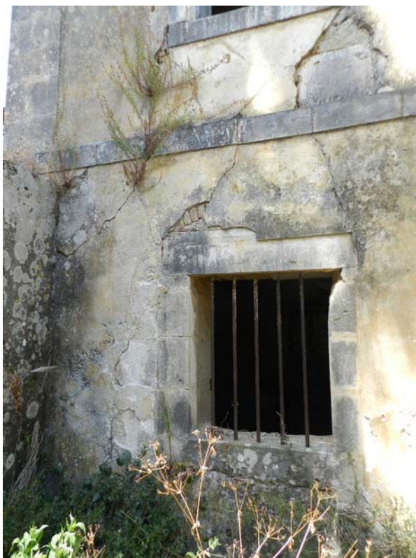
Εικ. 8, 9. Ρηγματώση των εξωτερικών τοίχων (επιχρισμένων αργολιθοδομών) και τοπικές απώλειες υλικού άνω.
