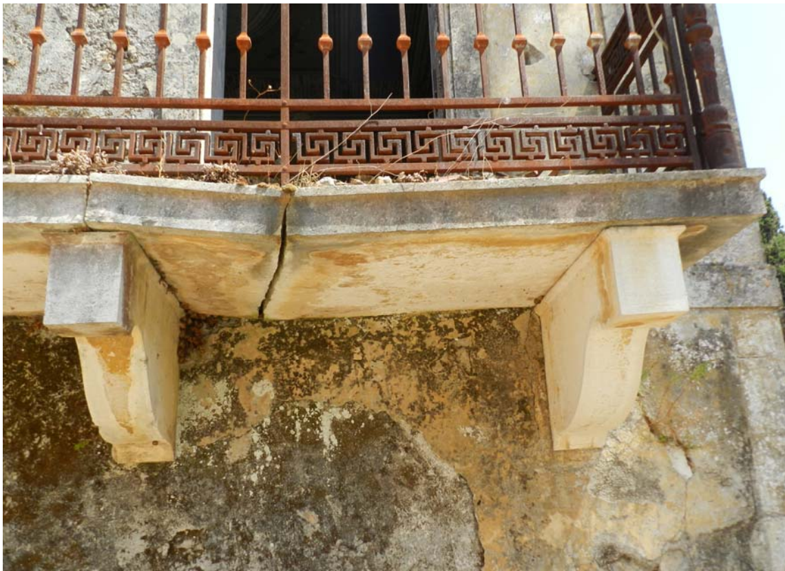
Εικ. 17. Θραύση της λίθινης πλάκας (της εδραζόμενης στα λίθινα φουρούσια) του εξώστη της δυτικής πλευράς.
