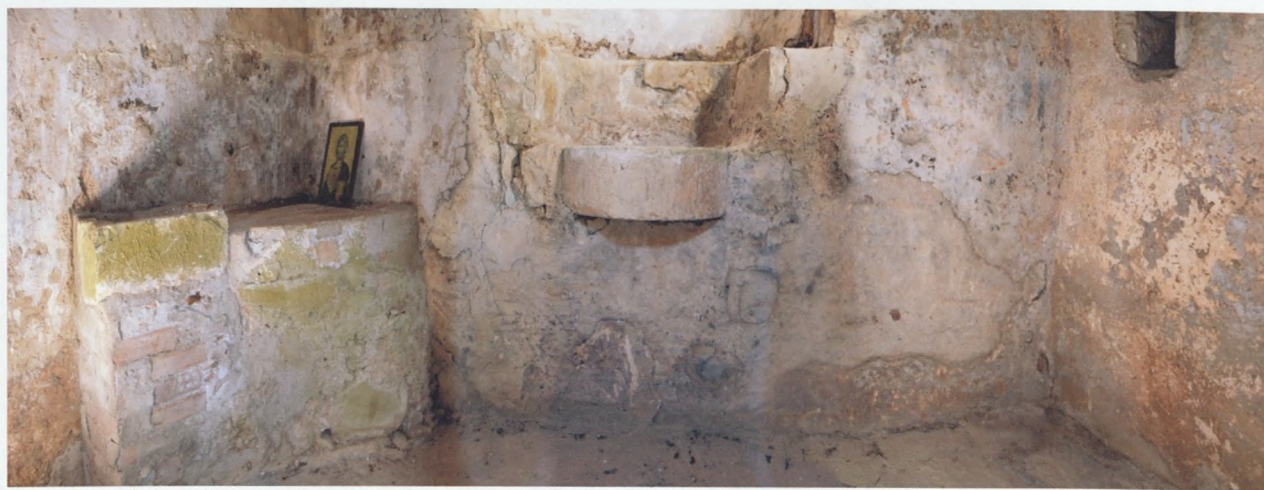
φωτ.23 Κάτω ζώνη κόγχης Ιερού Βήματος
