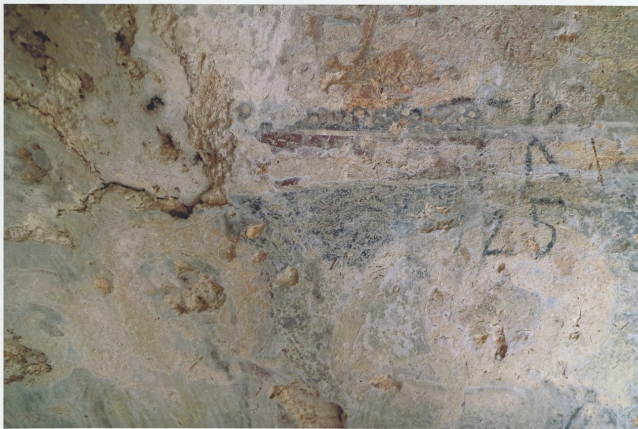
φωτ.37 Επικαθίσεις αδιάλυτων αλάτων στη χρωματική επιφάνεια
