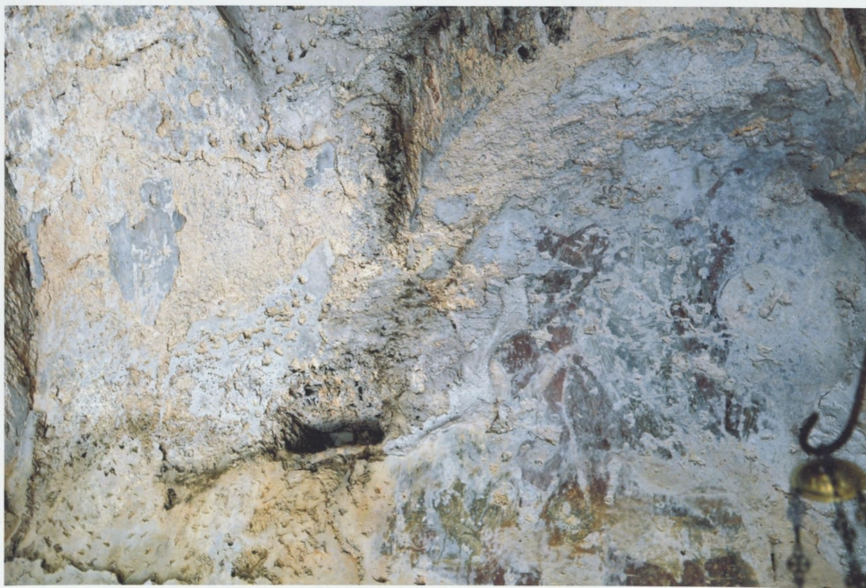
φωτ.60 Υπάρχουσα κατάσταση του βόρειου τοίχου της εκκλησίας του Αγίου Ανδρέα
