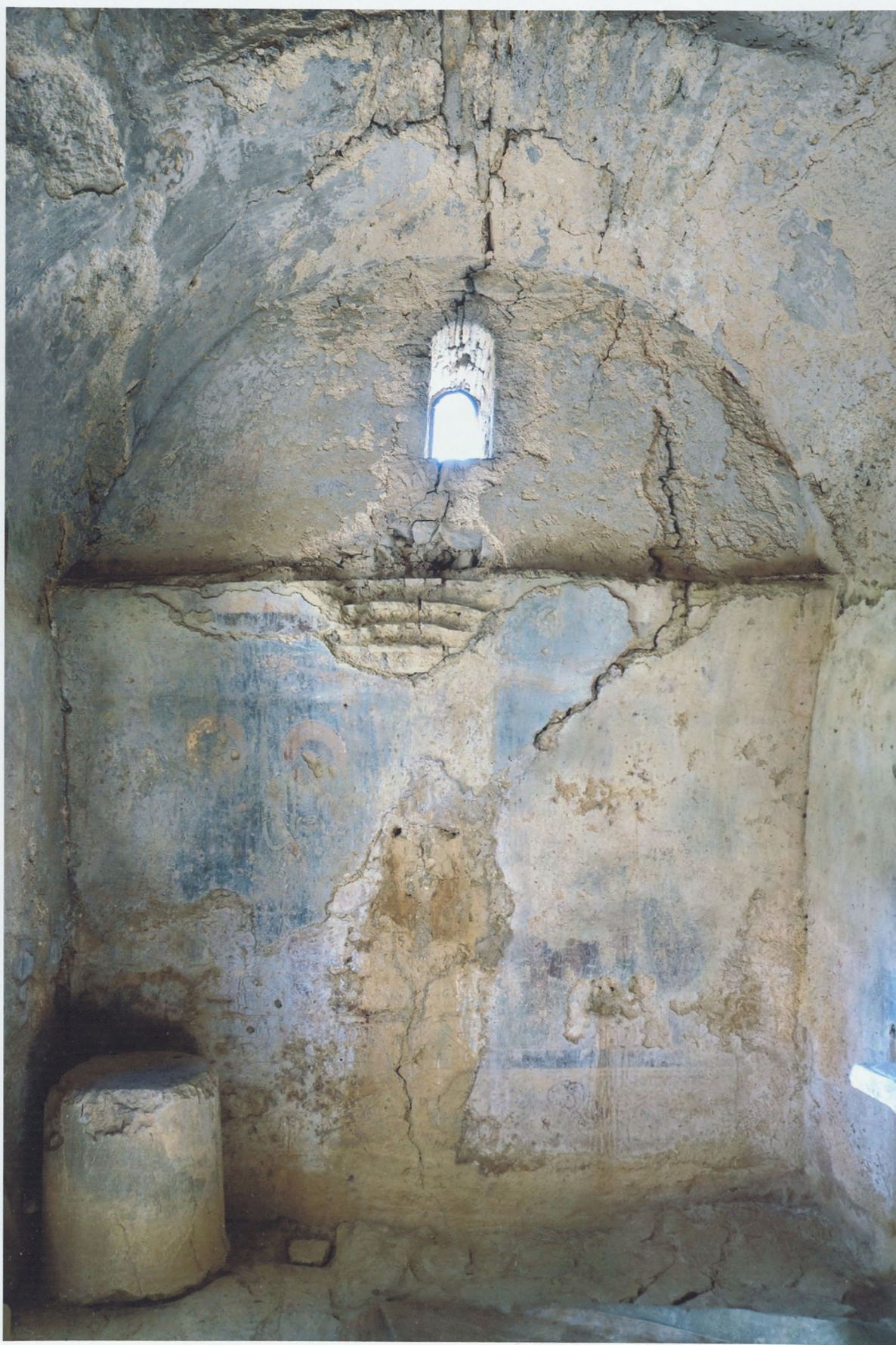
φωτ.42 Όψη δυτικού τοίχου εκκλησίας Αγίου Ανδρέα
