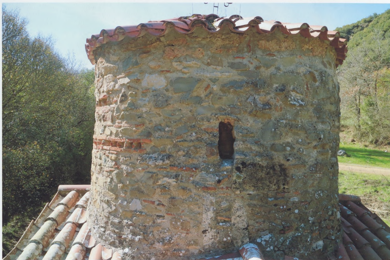
φωτ.11 Ανατολική πλευρά τρούλου
