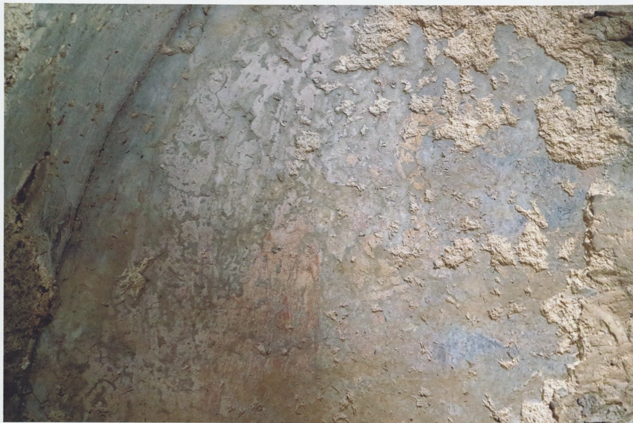
φωτ.45 Νότια πλευρά τόξου δυτικού τοίχου
