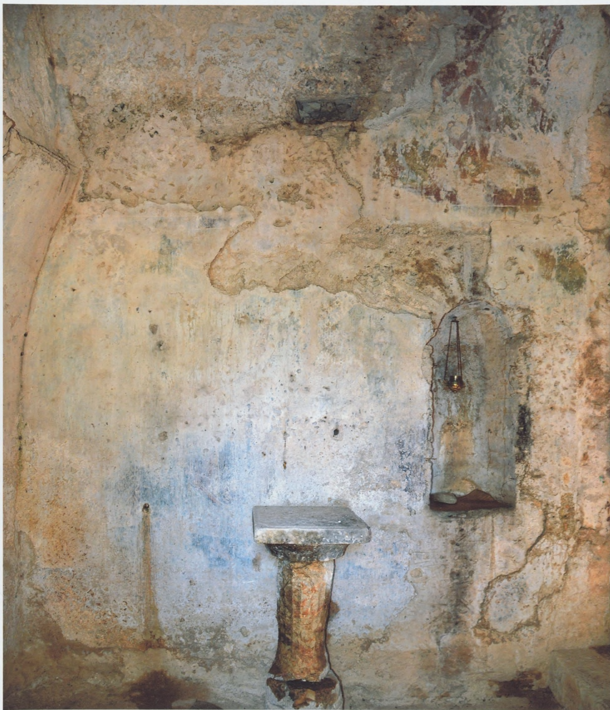
φωτ.57 Όψη βόρειου τοίχου από την εκκλησία του Αγίου Ανδρέα
