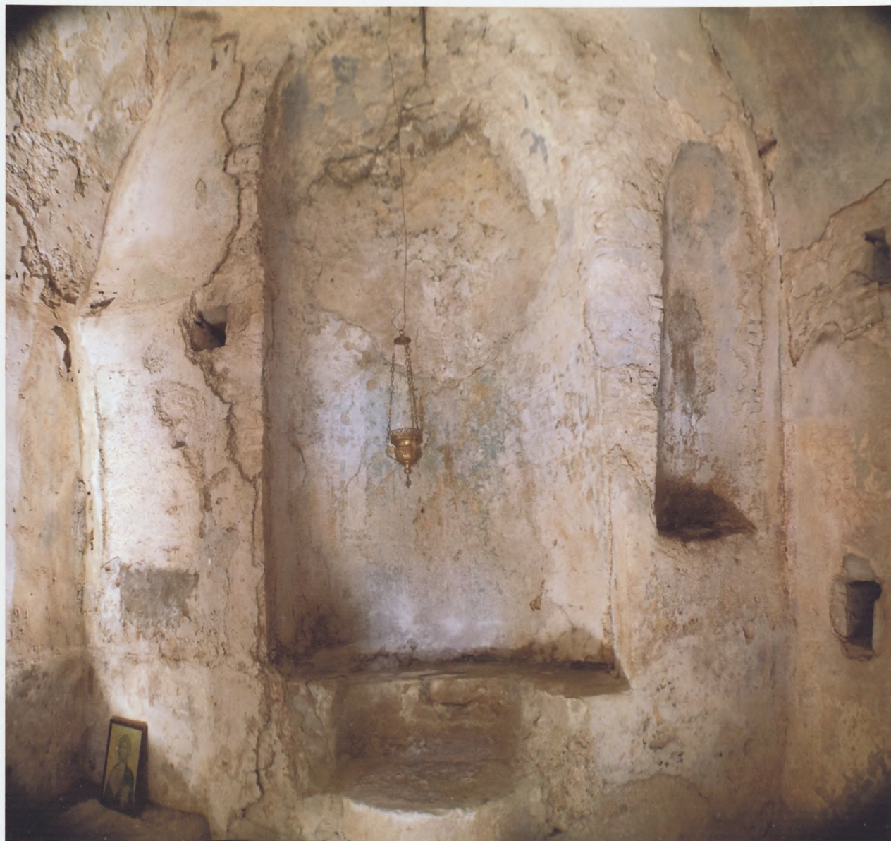
φωτ.22 Κόγχη Ιερού Βήματος
