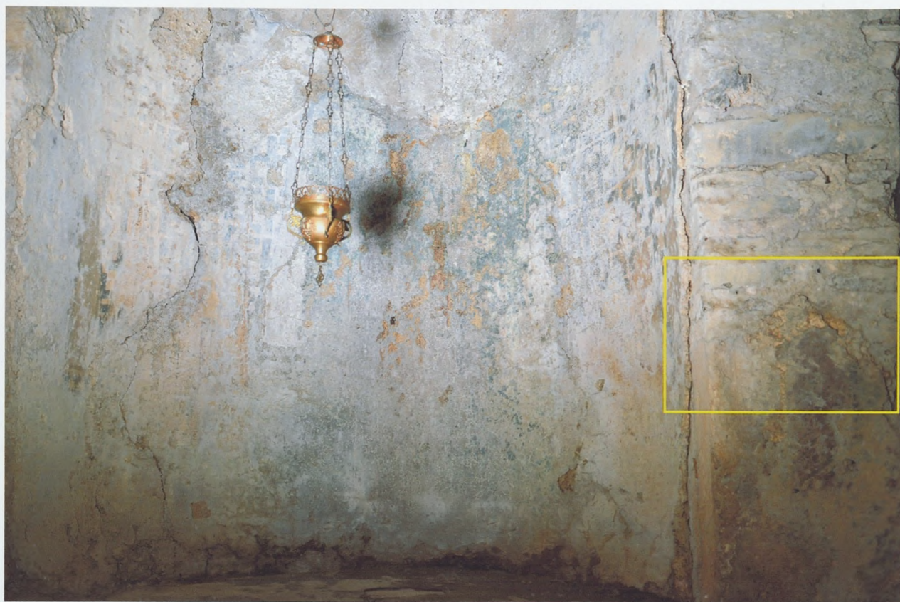
φωτ.27 Κόγχη Ιερού Βήματος
