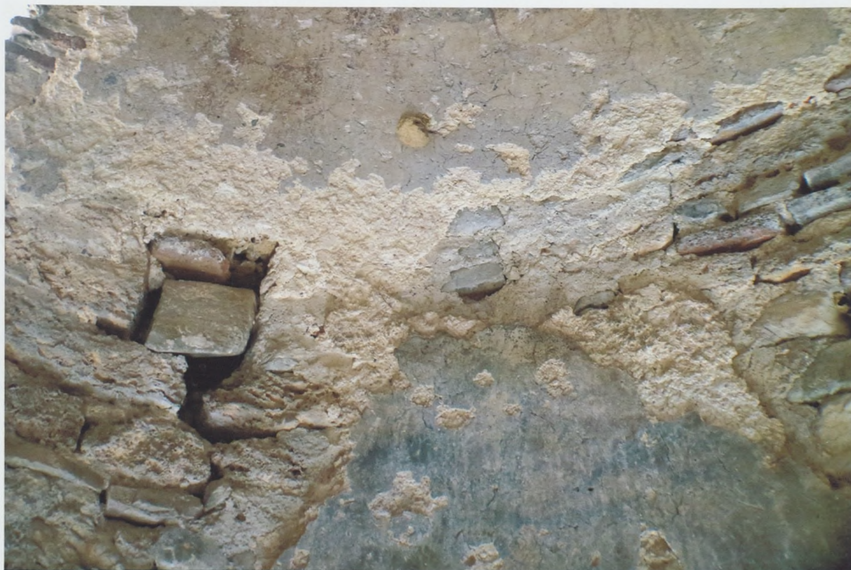
φωτ.71 Προβλήματα στο νοτιο τμήμα του τρούλου με δομικές φθορές
