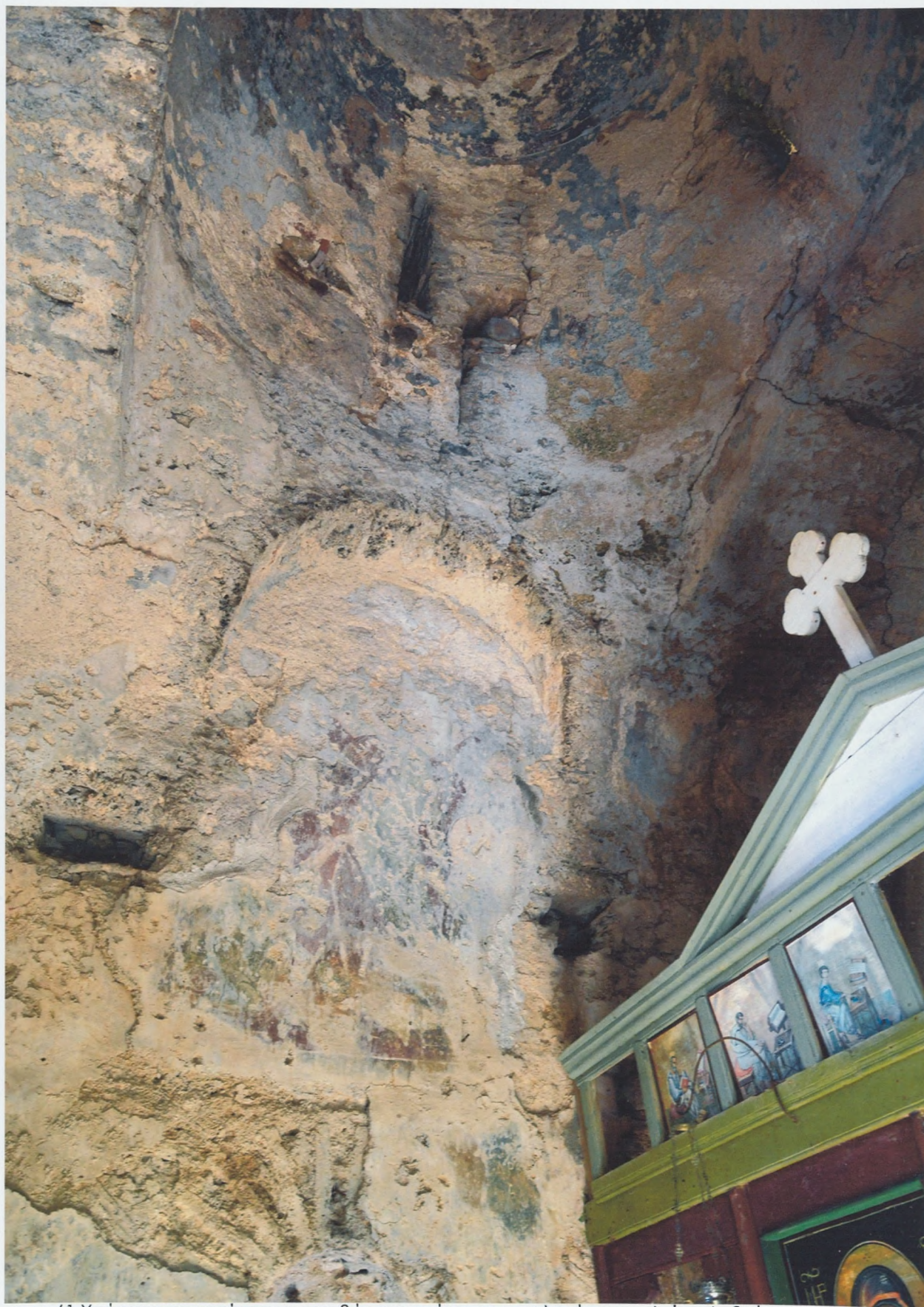
φωτ.61 Υπάρχουσα κατάσταση του βόρειου τοίχου της εκκλησίας του Αγίου Ανδρέα
