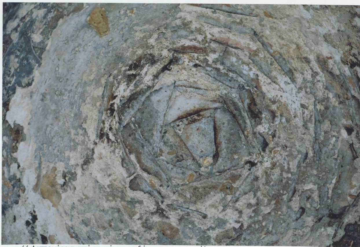
φωτ.66 Λεπτομέρεια από το σύστημα δόμησης του τρούλου
