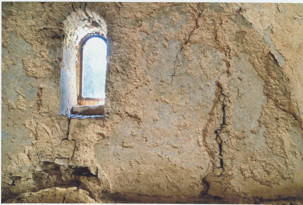
φωτ.46 Παράθυρο και βόρεια πλευρά τόξου δυτικού τοίχου
