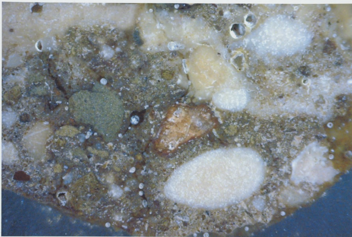
φωτ.87 Τσιμεντοκονία που χρησιμοποιήθηκε για συγκράτηση του Εαγγελισμού στο Νότιο τοίχο
