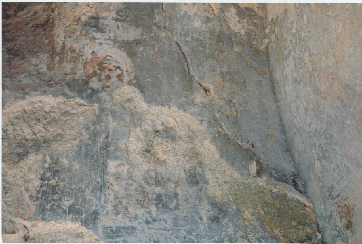
φωτ.41 Τμήμα του νότιου τοίχου στη δυτική πλευρά
