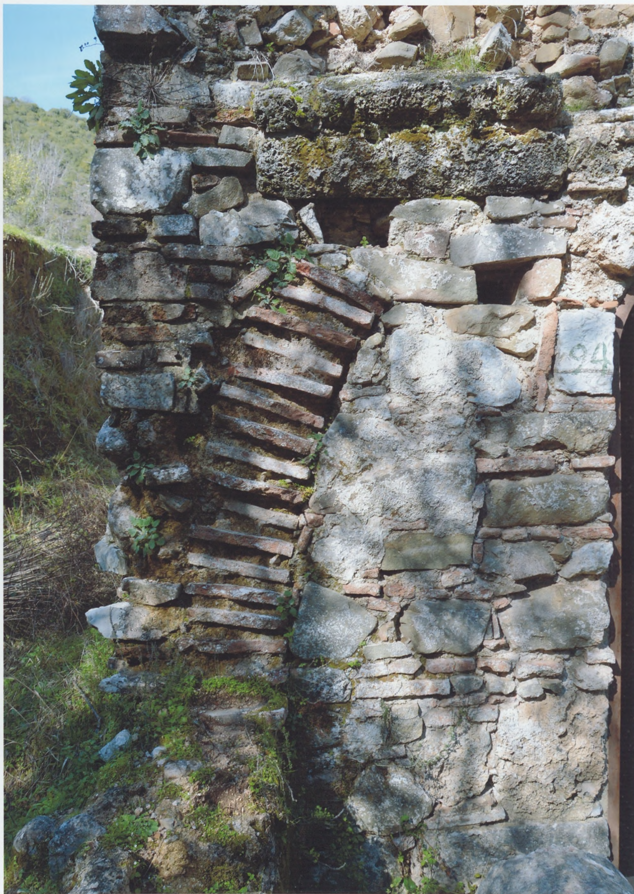
φωτ.14 Διαφορετικές κτιριολογικές φάσεις στη νότια πλευρά της εκκλησίας του Αγ. Ανδρέα
