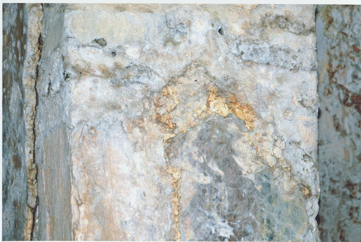
φωτ.28 Λεπτομέρεια από επιλεγμένο τμήμα που εμφανίζεται η υπάρχουσα κατάσταση
