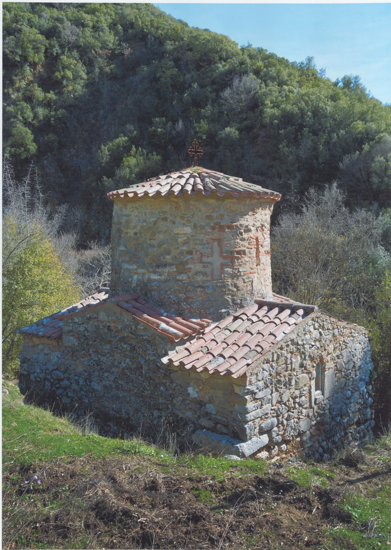
φωτ.09 Βορειοδυτική πλευρά της εκκλησίας
