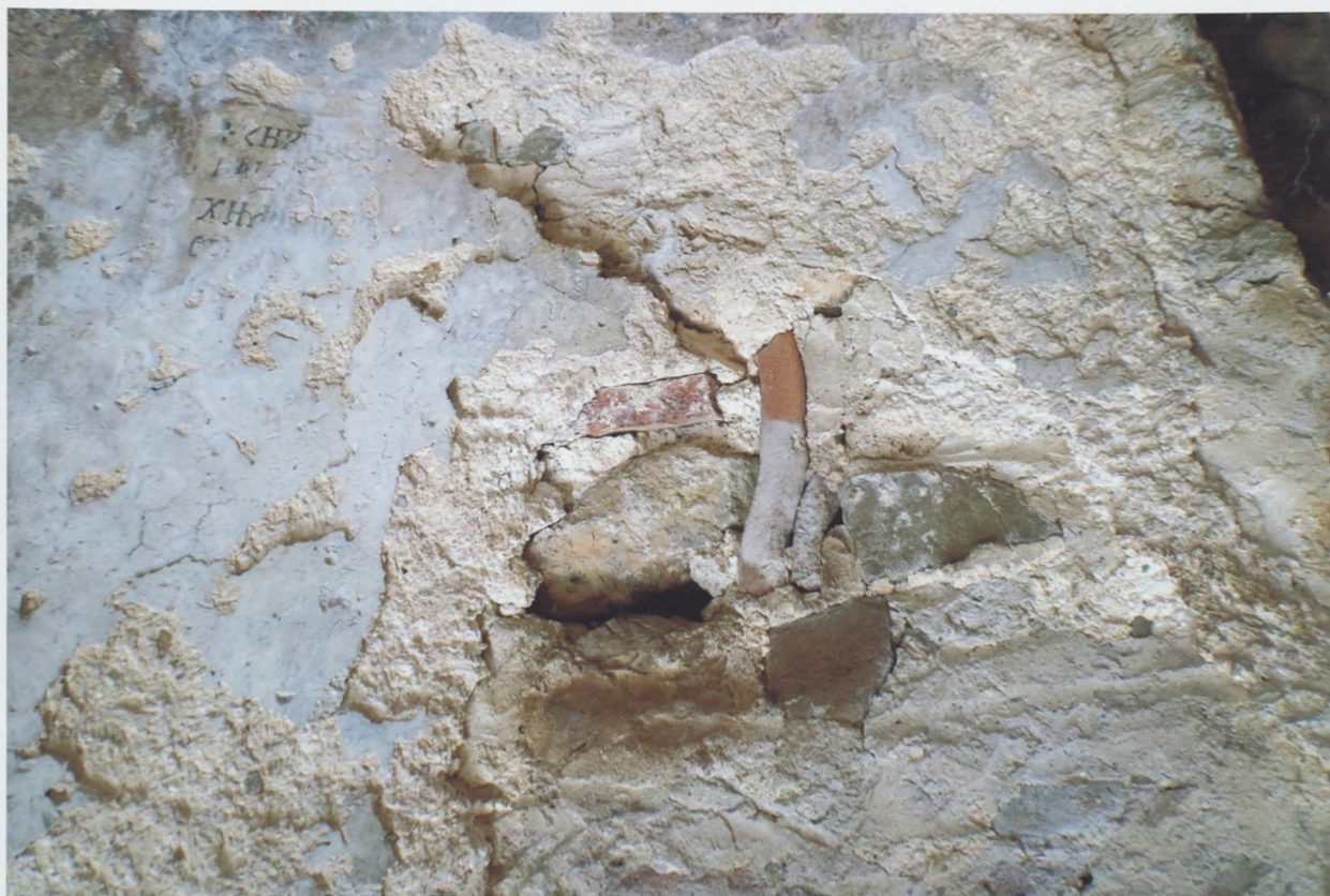
φωτ.73 Λεπτομέρεια από βόρεια πλευρά του τρούλου
