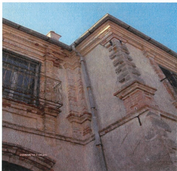
32 ΠΛΑΪΝΗ ΑΠΟΨΗ ΟΡΟΦΟΥ.
