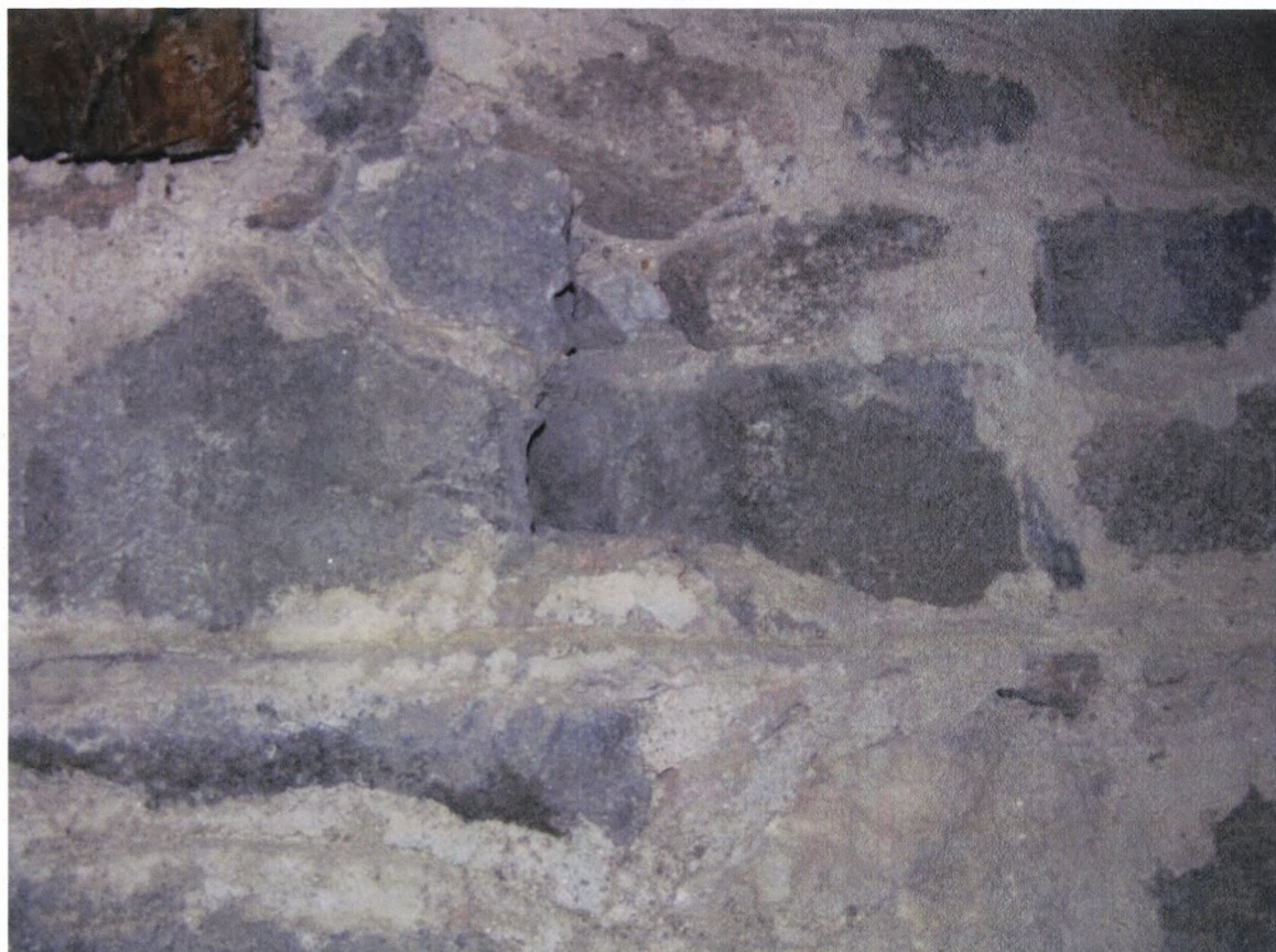
16 ΦΕΡΟΥΣΑ ΤΟΙΧΟΠΟΙΑ ΛΙΘΟΔΟΜΗΣ (γρανίτης και συνδετικό ασβεστοκονίαμα).
