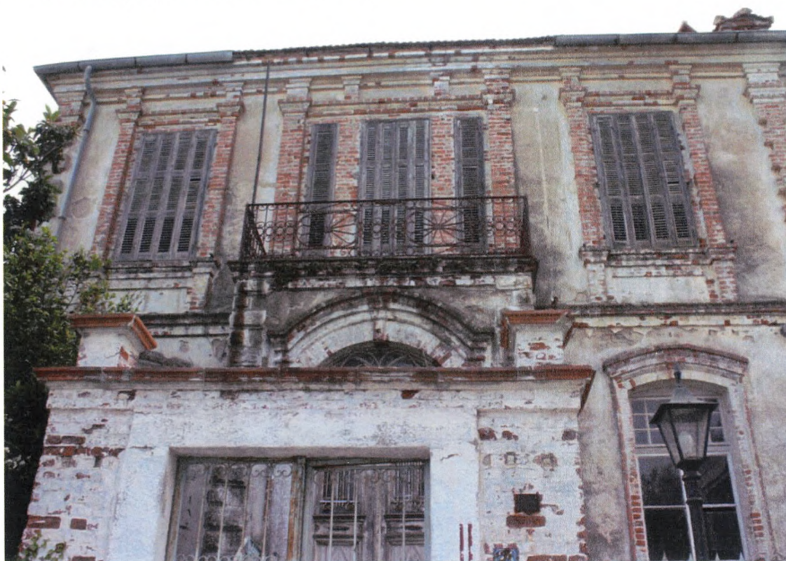
1 ΑΠΟΨΗ Α' ΚΤΗΡΙΟΥ ΑΠΟ ΤΗΝ ΟΔΟ ΑΓ. ΒΛΑΣΙΟΥ
