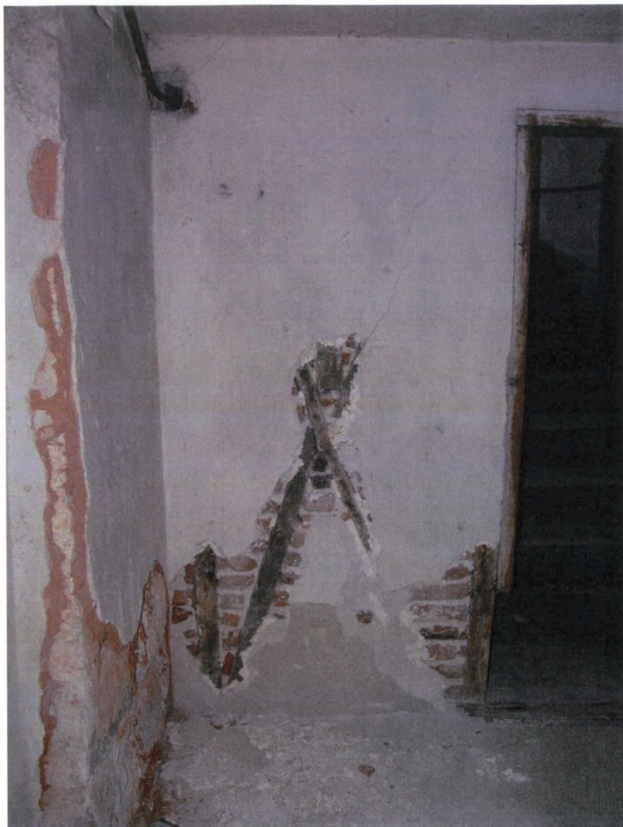
17 ΞΥΛΟΠΙΚΤΗ ΤΟΙΧΟΠΟΙΙΑ ΥΠΟΓΕΙΟΥ
