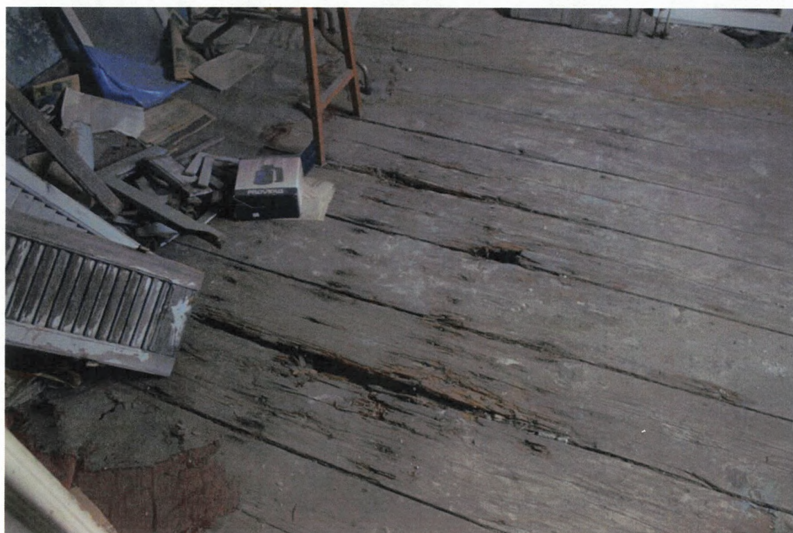
40 ΔΙΑΒΡΩΣΗ ΠΑΤΩΜΑΤΩΝ ΛΟΓΩ ΔΙΑΡΡΟΗΣ ΤΗΣ ΣΤΕΓΗΣ
