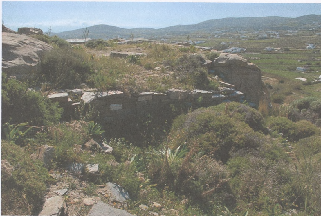
Πιν.23 Τομέας Η, Άνδηρο Αθηνάς, αναλημματικός τοίχος ναού.
