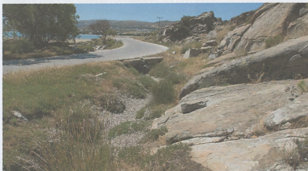
Πιν.61 Η περιοχή στις ΒΔ υπώρειες του λόφου, που αντιμετωπίζουν πρόβλημα συγκέντρωσης υδάτων.
