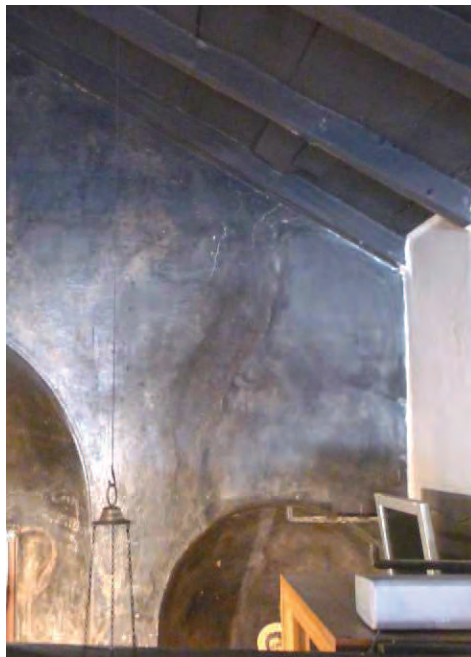
Εικόνα 11 Σημάδια επισκευής στον ανατολικό τοίχο εσωτερικά
