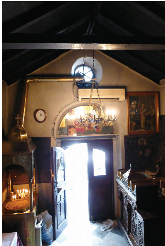
05. Γενική άποψη του δυτικού τοίχου και της εισόδου του ναού
