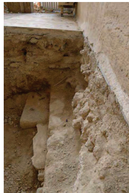
Εικόνα 14 Άποψη της διερευνητικής τομής στα θεμέλια του νότιου τοίχου
