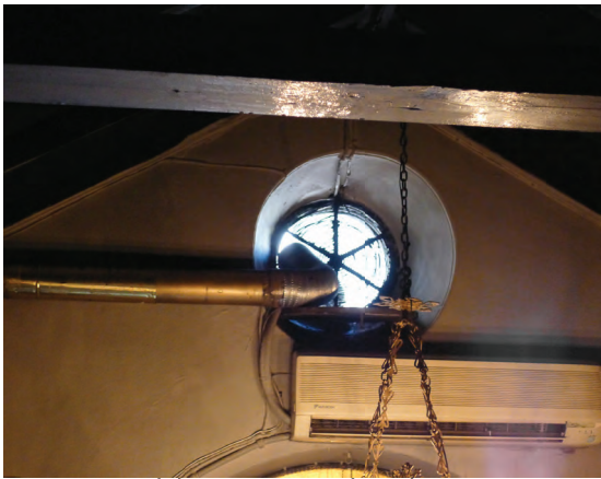
22. Εσωτερική όψη φωτιστικού ανοίγματος στον δυτικό τοίχο
