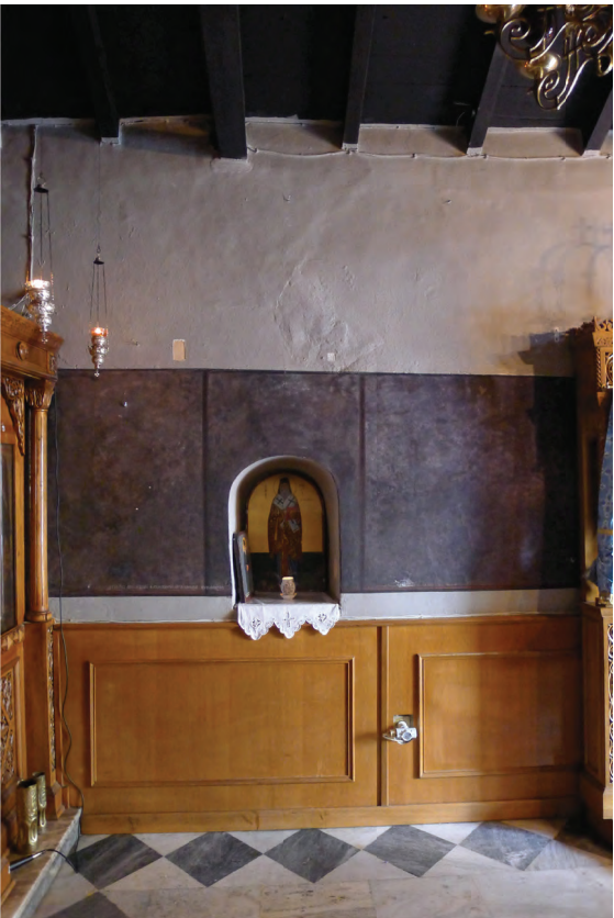
08. Άποψη του νότιου τοίχου
