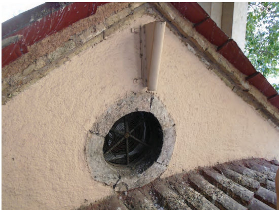
23. Εξωτερική όψη φωτιστικού ανοίγματος στον ανατολικό τοίχο
