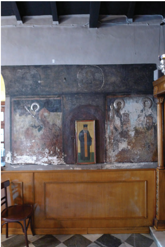
07. Άποψη του βόρειου τοίχου
