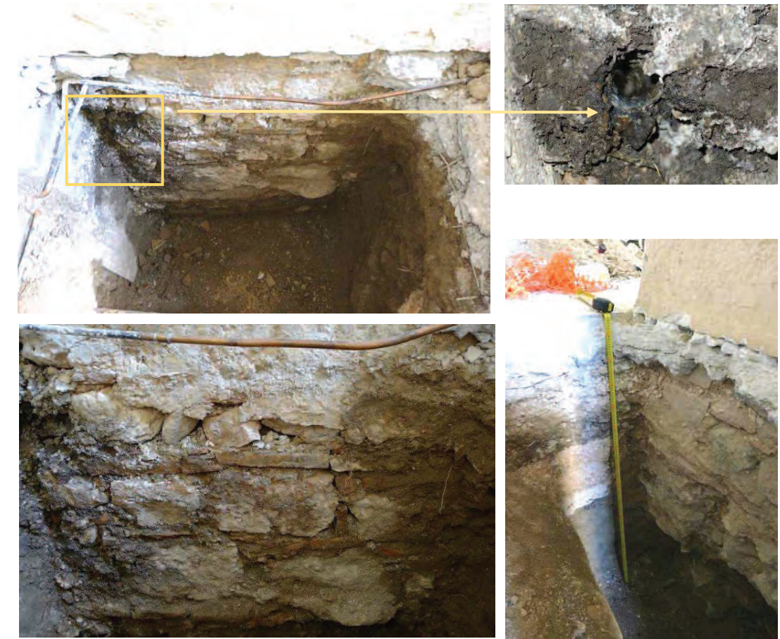
Εικόνα 10 α-δ : Απόψεις της διερευνητικής τομής στα θεμέλια του βόρειου τοίχου.
