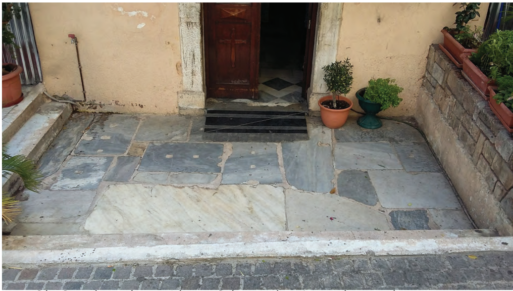
20. Το δάπεδο από μαρμαρίνες πλάκες σε δεύτερη χρήση εξωτερικά του ναού
