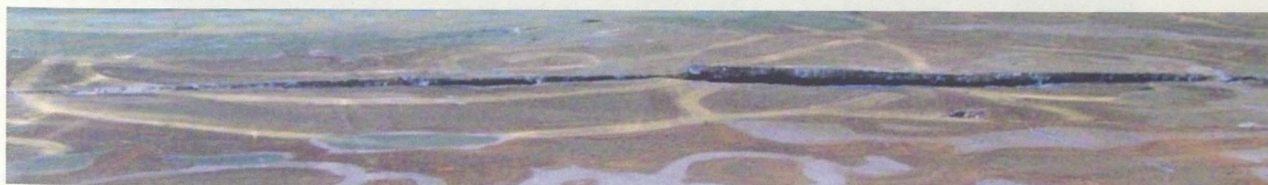
Φωτογραφία 5. Αποκόλληση του κονιάματος από τον τοίχο.
