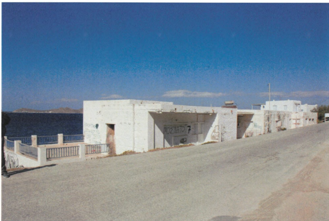
Εικ. 2 Άποψη του κτηρίου από ΝΔ στο επίπεδο του δρόμου.
