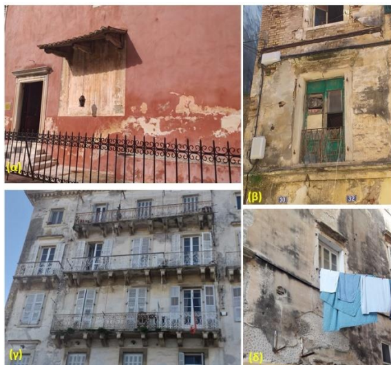
Εικόνα 27. Παθολογίες επιχρισμάτων. (α) Άγιος Φραγκίσκος, (β) Περιοχή της Εβραϊκής, (γ) Πλατεία Δημαρχείου, (δ) Ι. Ν. Παναγίας Αντιβουνιώτισσας, (ε) Ιόνιος Βουλή, (ζ) Περιοχή Campiello
