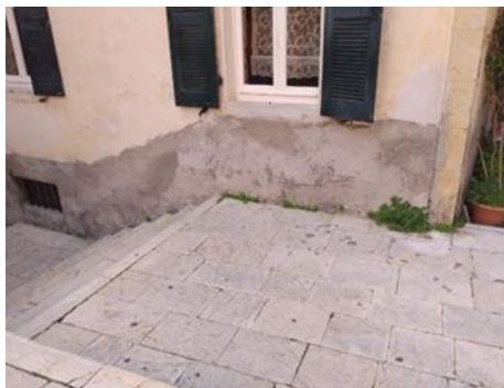
Εικόνα 36. Παραδείγματα επεμβάσεων με τσιμέντο
