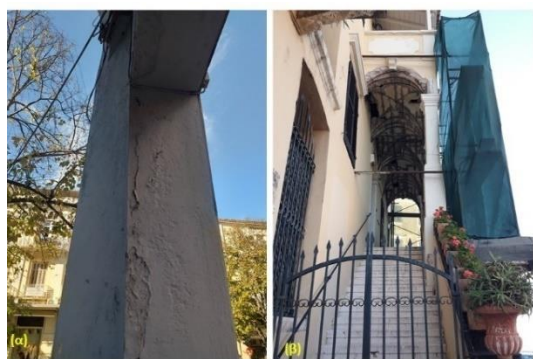
Εικόνα 31. Φθορές ΟΣ. (α) Δημοτικό Θέατρο Κέρκυρας, (β) Αναγνωστική Κέρκυρας
