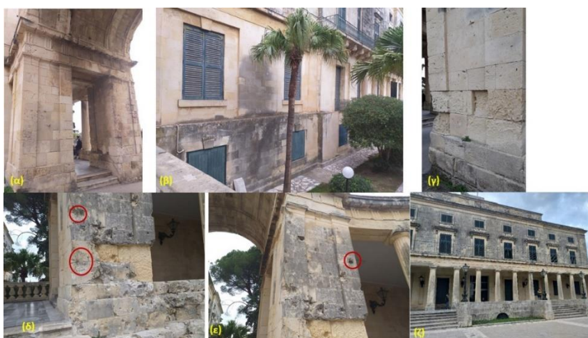
Εικόνα 26. Φθορές στο Ανάκτορο Αγίων Μιχαήλ και Γεωργίου (Σε κόκκινο κύκλο χτυπήματα από βλήματα)
