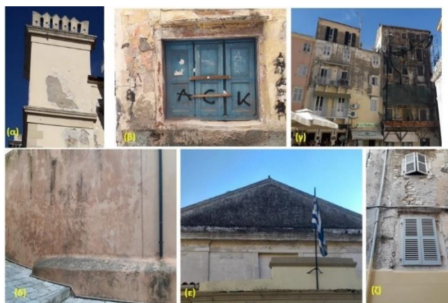
Εικόνα 27. Παθολογίες επιχρισμάτων. (α) Άγιος Φραγκίσκος, (β) Περιοχή της Εβραϊκής, (γ) Πλατεία Δημαρχείου, (δ) Ι. Ν. Παναγίας Αντιβουνιώτισσας, (ε) Ιόνιος Βουλή, (ζ) Περιοχή Campiello
