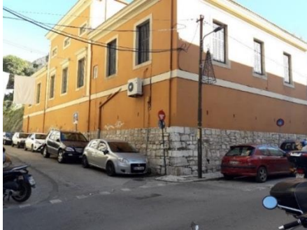
Εικόνα 34. Παράδειγμα δόμησης της χαμηλότερης στάθμης με λιθοδομή-Οδός Δεσύλα
