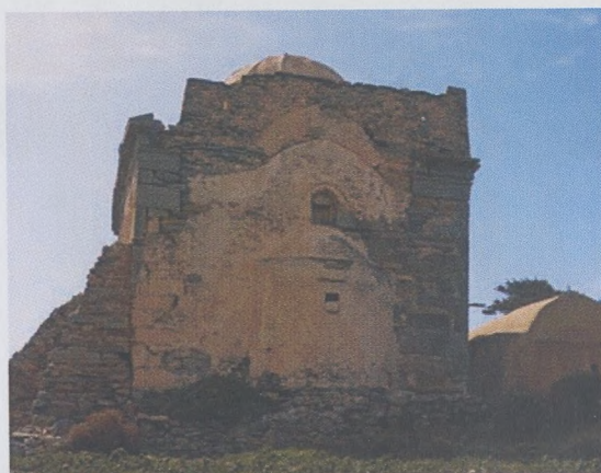
Εικ. 3.12: Ανατολικός τοίχος.
