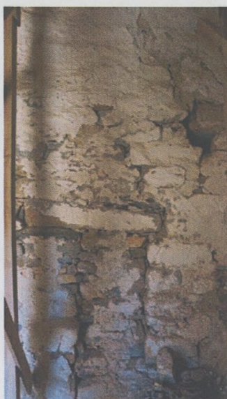
Εικ. 3.11 : Εγκάρσιος τοίχος - νότιο τμήμα.
