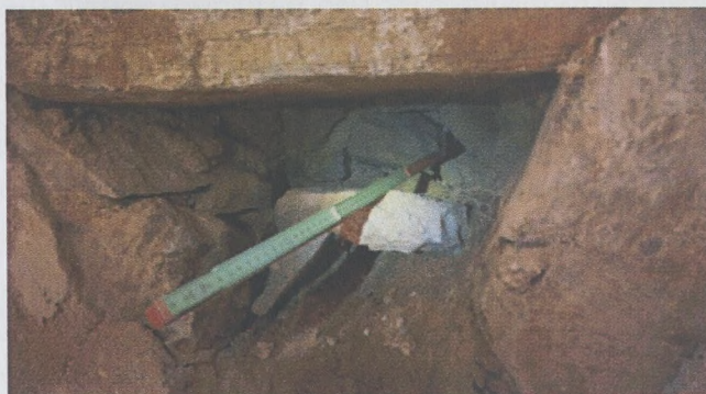
Εικ. 3.3 : Δόμηση κατά το πάχος (μεταγενέστερη φάση - στάθμη γείσου).
