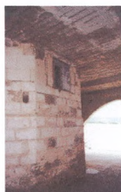
Εικ. 4-6. Οι στοές (νότια, ανατολική και δυτική) γύρω από τον κεντρικό ναό του 19 ου αιώνα. Από αυτές κατεδαφιστές θα πρέπει να θεωρηθούν μόνον οι οριζόντιες πλάκες από οπλισμένο σκυρόδεμα (βλ. Εικ..5).
