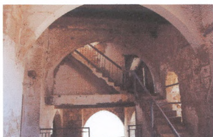
Εικ. 4-6. Οι στοές (νότια, ανατολική και δυτική) γύρω από τον κεντρικό ναό του 19 ου αιώνα. Από αυτές κατεδαφιστές θα πρέπει να θεωρηθούν μόνον οι οριζόντιες πλάκες από οπλισμένο σκυρόδεμα (βλ. Εικ..5).
