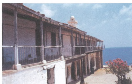
Εικ. 7-9. Απόψεις της νότιας στοάς, του υπερκείμενου ορόφου των κελιών και της ανατολικής στοάς που απυχώς έχουν προταθεί από την υφιστάμενη μελέτη G. Croci για κατεδάφιση και μερική ανακατασκευή ώστε να είναι δυνατή η υλοποίηση συγκεκριμένων εκτεταμένων δομικών ενισχύσεων στον κεντρικό ναό του 19 ου αιώνα.
