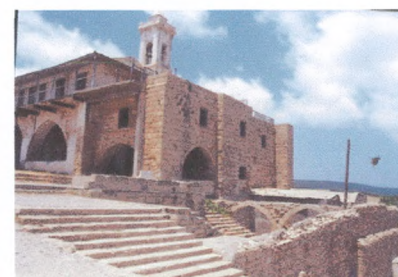
Εικ. 7-9. Απόψεις της νότιας στοάς, του υπερκείμενου ορόφου των κελιών και της ανατολικής στοάς που απυχώς έχουν προταθεί από την υφιστάμενη μελέτη G. Croci για κατεδάφιση και μερική ανακατασκευή ώστε να είναι δυνατή η υλοποίηση συγκεκριμένων εκτεταμένων δομικών ενισχύσεων στον κεντρικό ναό του 19 ου αιώνα.
