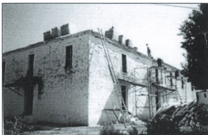
Από την αποκατάσταση της στέγης [Αύγουστος 2002]
