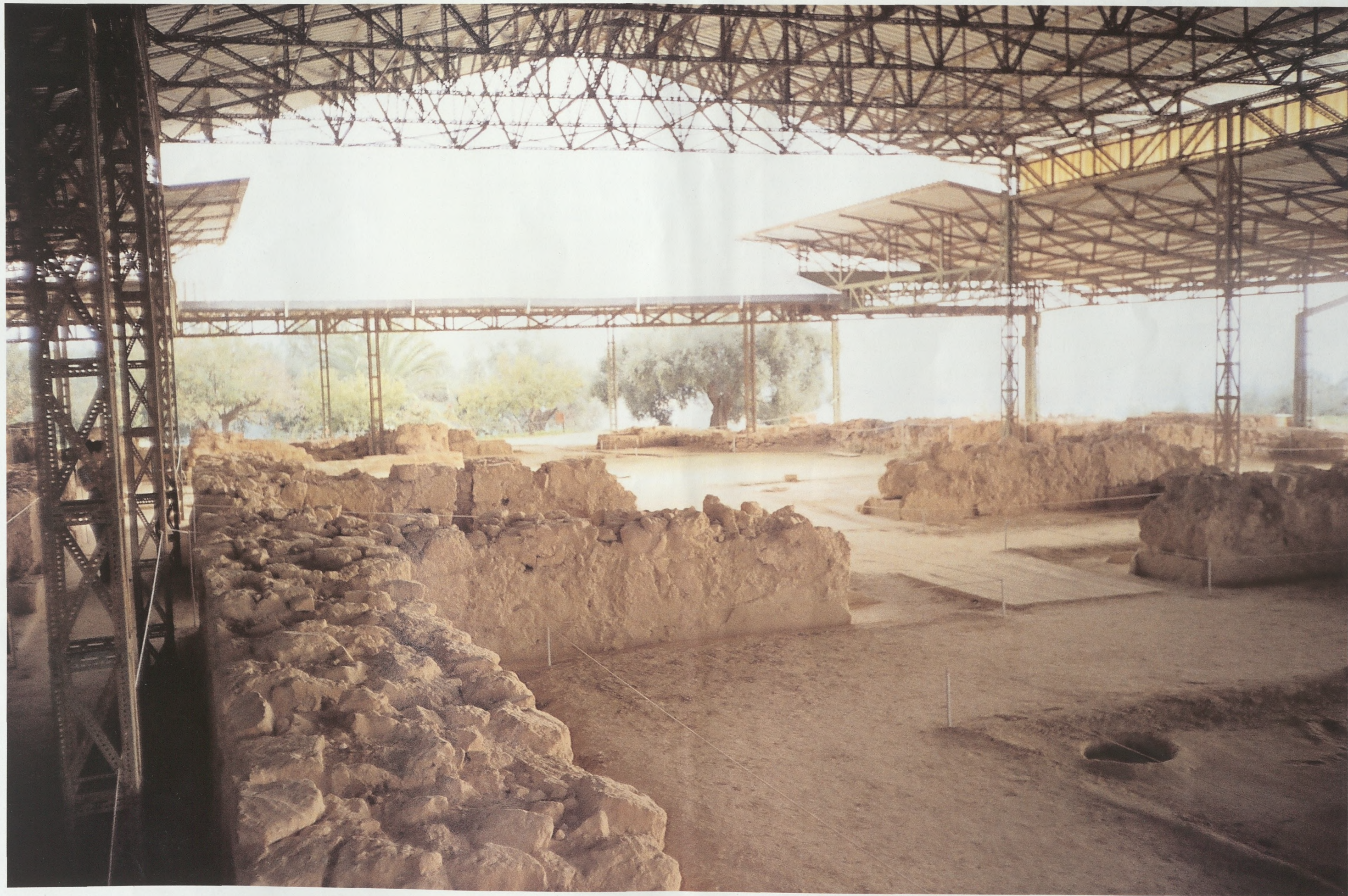
Εικ.31: Το στέγαστρο του ανακτόρου του Νέστορος από τα βορειοανατολικά. Φαίνεται το κενό πάνω από το αίθριο που αφήνει τα όμβρια να διεισδύουν στα οικοδομικά κατάλοιπα.
