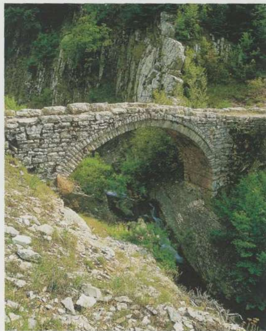
Η γέφυρα του Φίλου, στην περιοχή Χαλίκι.
