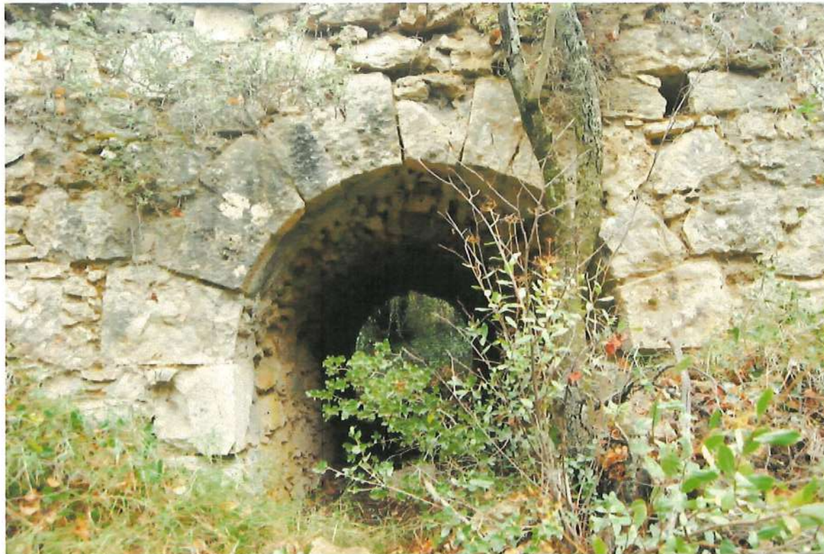
Εικ.29 Τατόι. τ. Βασιλικό κτήριο. Διαδρομή προς Λίμνη «Κιθάρα». Γέφυρα Ε'. Άποψη από τα ανατολικά.
