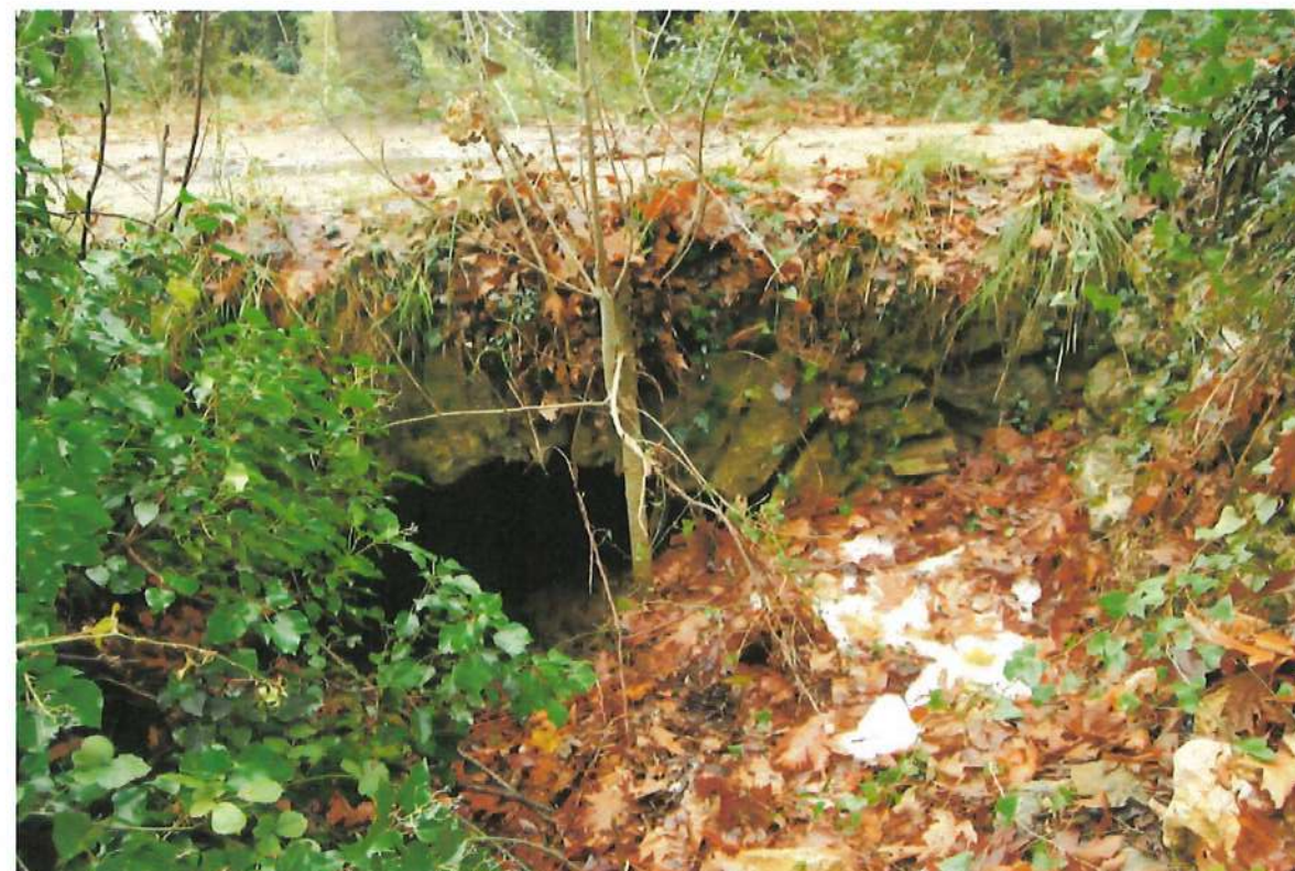
Εικ.43 Τατόι. τ. Βασιλικό κτήμα. Διαδρομή προς Λίμνη «Κιθάρα». Γέφυρα ΣΤ'. Άποψη από τα δυτικά.
