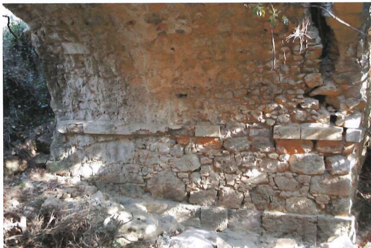
Εικ.17 Τατόι. τ. Βασιλικό κτήριο. Διαδρομή προς Λίμνη «Κιθάρα». Γέφυρα Γ'. Άποψη του εσωτερικού του τόξου από τα δυτικά.
