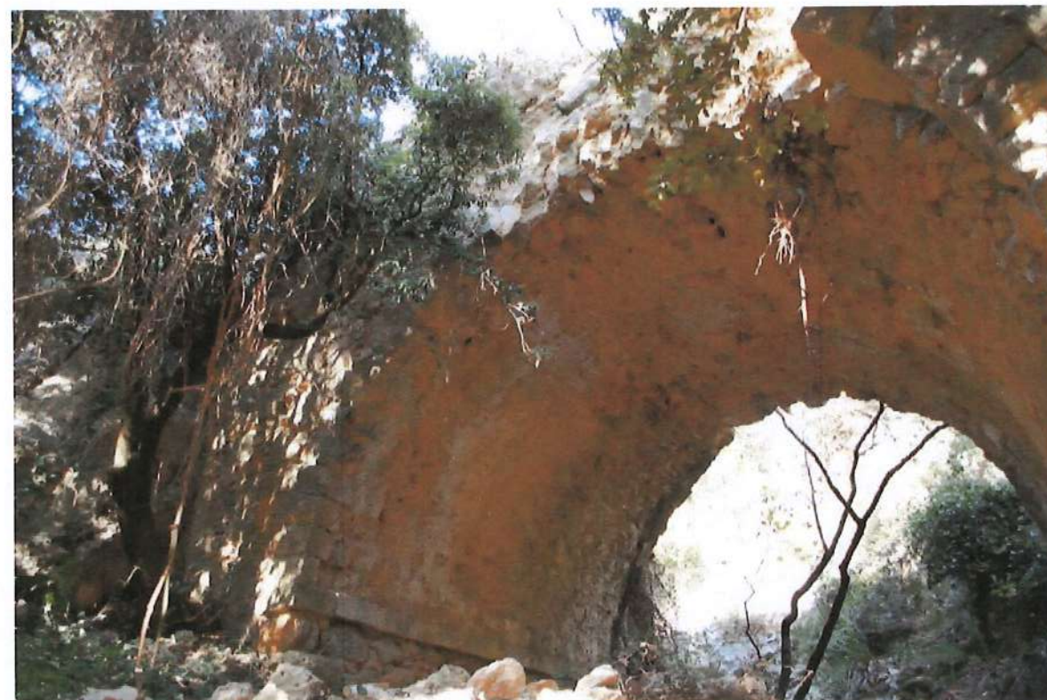
Εικ.19 Τατόι. τ. Βασιλικό κτήριο. Διαδρομή προς Λίμνη «Κιθάρα». Γέφυρα Γ'. Άποψη προς τα νοτιοδυτικά.
