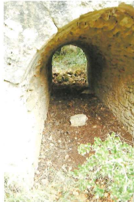
Εικ.31 Τατόι. τ. Βασιλικό κτήριο. Διαδρομή προς Λίμνη «Κιθάρα». Γέφυρα Ε'. Άποψη του εσωτερικού του τόξου προς τα δυτικά.
