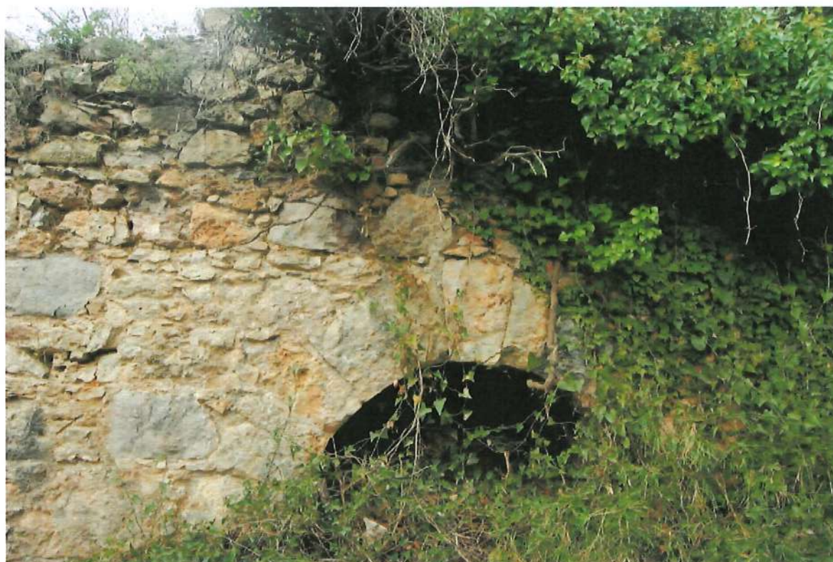
Εικ.21 Τατόι. τ. Βασιλικό κτήμα. Διαδρομή προς Λίμνη «Κιθάρα». Γέφυρα Δ'. Άποψη από τα νότια.
