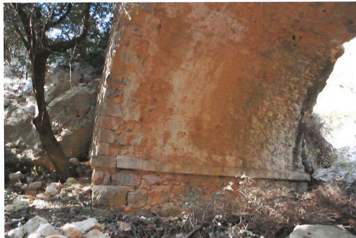
Εικ.18 Τατόι. τ. Βασιλικό κτήριο. Διαδρομή προς Λίμνη «Κιθάρα». Γέφυρα Γ'. Άποψη του εσωτερικού του τόξου από τα ανατολικά.
