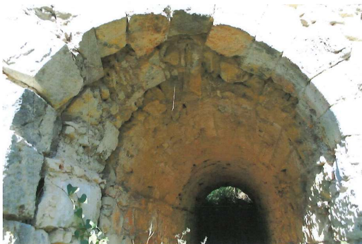
Εικ.14 Τατόι. τ. Βασιλικό κτήριο. Διαδρομή προς Λίμνη «Κιθάρα». Γέφυρα Β'. Άποψη του εσωτερικού του τόξου προς τα βόρεια.
