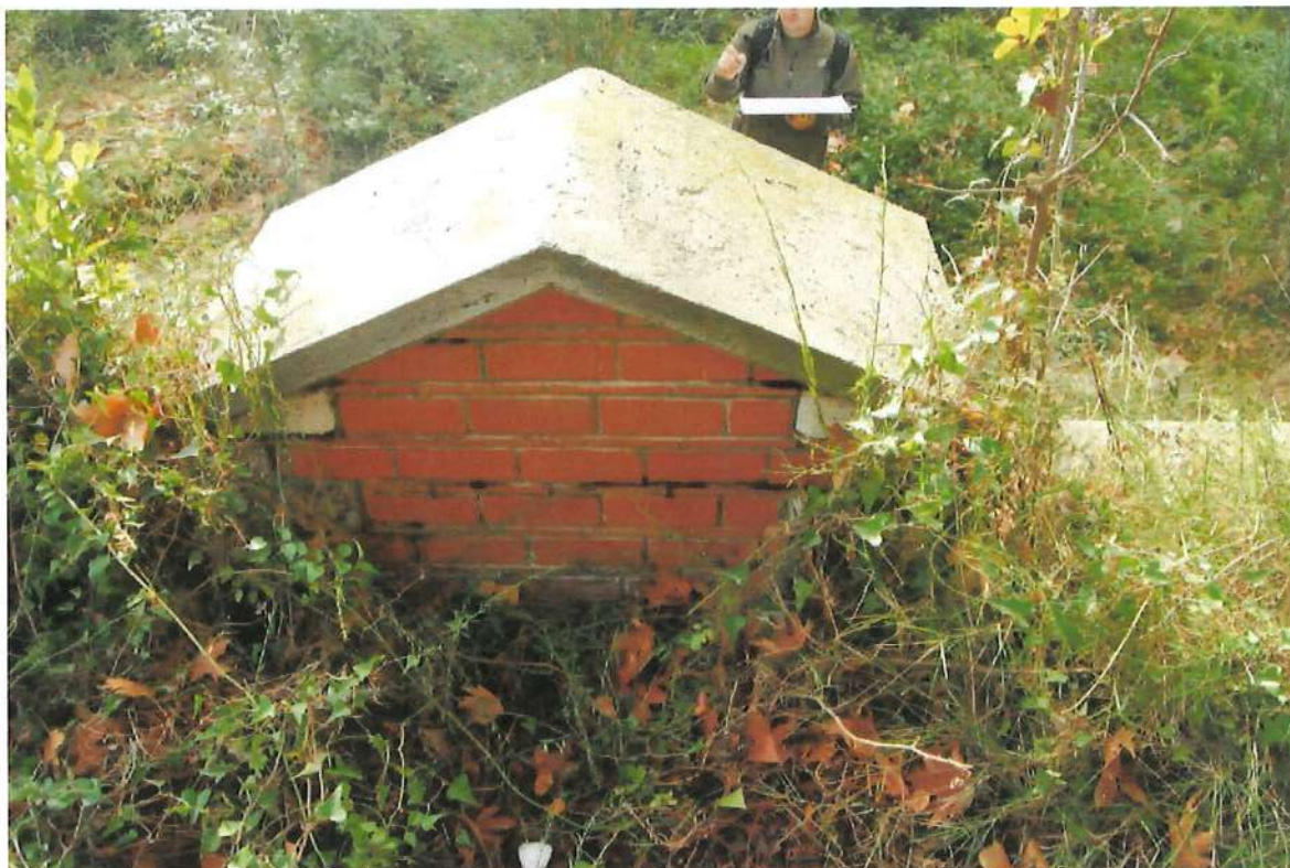
Εικ.9 Τατόι. τ. Βασιλικό κτήριο. Διαδρομή προς Λίμνη «Κιθάρα». Κρήνη «Πρίγκηπος Κωνσταντίνου». Άποψη από τα βόρεια.
