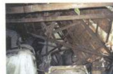
Αποψη του εσωτερικού του αρδού του τμήματος Ι. Μεγάλο μέρος της ξύλινης στήλης έχει καταρρεύσει, ενώ σε κακή κατάσταση βρίσκονται οι λιθοδομές.
