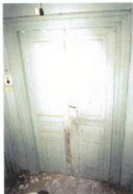
Εσωτερική Δίθυρη ξύλινη ταμπακωτή θύρα. Επιχρωματισμός με απογάλαξη λαδομπογιάς (πρόσφατος επιχρωματισμός)
