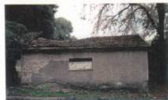
Δυτική όψη του κτιρίου στάθμευσης στην αυλή του εμψαλιωτηρίου.
