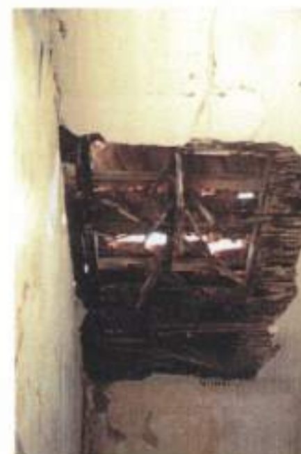
Τόσο τα οριζόντια τμήματα των μπαλκονιών όσο και αυτά παράλληλα στην κλίση της στέγης είναι ξύλινα, πρόσφατα επιχρισμένα με ασβεστοκονιάματα σε κακή κατάσταση.
