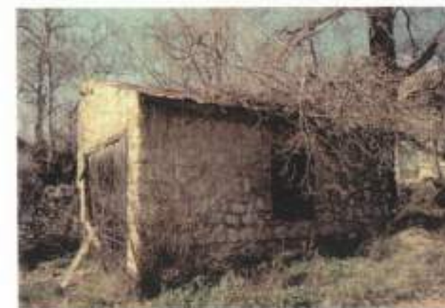
Ανατολική άποψη της αποθήκης στα ανατολικά του κελόφου κελόφου.
