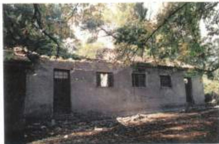
Το κυρίως κτίριο του εμψαλιωτηρίου. Ανατολική όψη.
