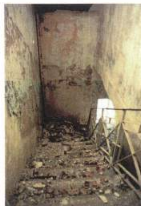
Η νεότερη κλίμακα από απλασμένο σκαρδόδεμα.
