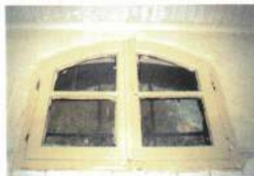
Αρχικό ξύλινο κοίφωμα σε τσιζιτό άνοιγμα της βορεινής όψης (εσωτερική άποψη)
