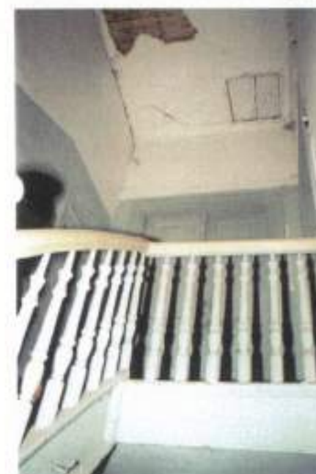
Εσωτερική ξύλινη κλίμακα ανόδου προς όροφο σε καλή κατάσταση. Χαρακτηριστικό ξύλινο στηθαίο με ξύλινες "μπαλοούστρες".
