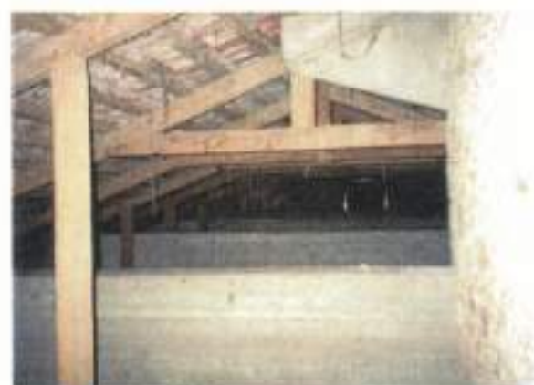
Τα τμήματα των στεγάνσεων είναι από ξύλινης δομής με παλιές κεραμίδες.
