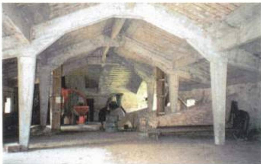
Αποψη του εσωτερικού του αρόφου με τον εξοπλισμό του. Διακρίνονται οι μηχανές αέρας τροφών, καθώς και οι ξύλινοι οδηγοί της τροφής στην κάτω στάθμη.
