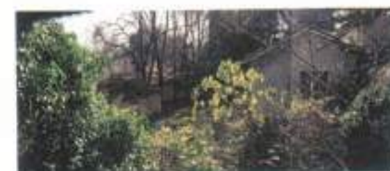
Βορεινή άποψη του συγκροτήματος. Στο μέσον διακρίνεται η αυλή και η βορεινή όψη του εμψαλιωτηρίου. Το κτίριο του Οινόποισιου βρίσκεται δεξιά.
