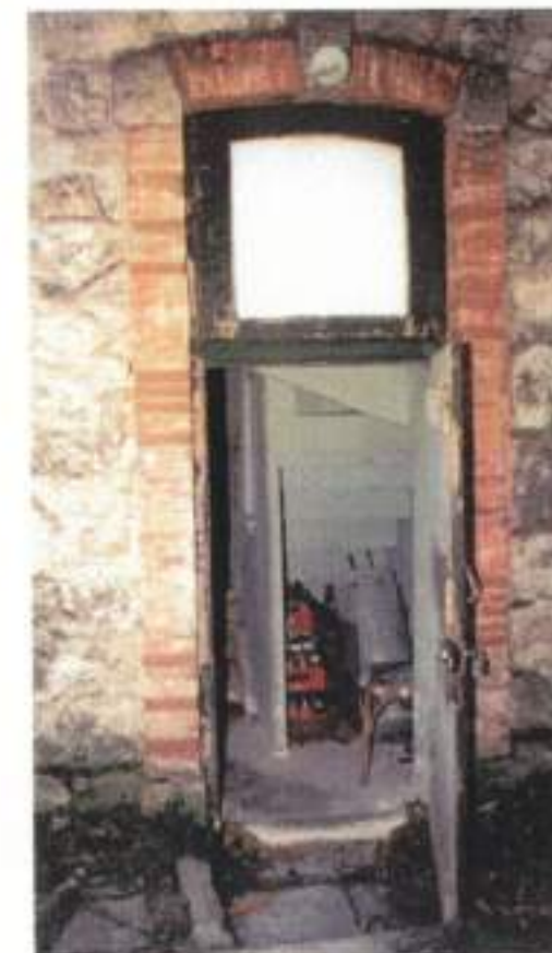
Η βορεινή είσοδος της κατοικίας στον χώρο του κλιμακοστασίου χωρίς νεότερους επιχρωματισμούς. Διακρίνονται εξωτερικά η διαμόρφωση του τοξωτού ανοίγματος από οπτοπλίνθοις και η λείδη κλειδα.
