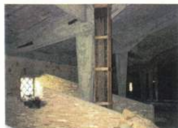
Τα τμήματα των στεγάνσεων είναι από ξύλινης δομής με παλιές κεραμίδες.
