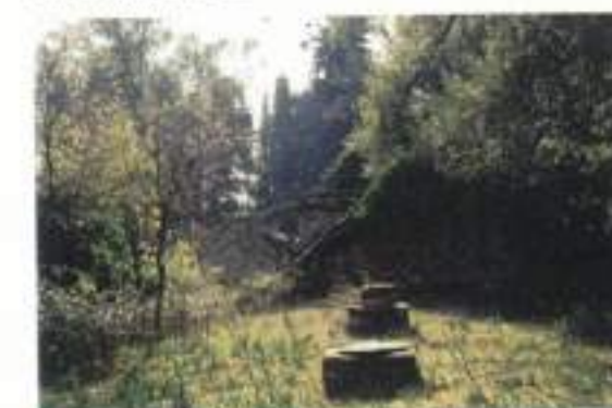
Κάτω αριστερά άποψη της βορεινής όψης του κτιρίου. Διακρίνονται οι αεραγωγοί που βρίσκονται στην οροφή του υπογείου τμήματος III.
