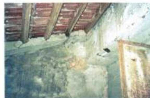
Οι περισσότεροι ξύλινοι αμείβοντες έχουν αντικατασταθεί από δακοίς σπλισμένους σκυροδέματος.
