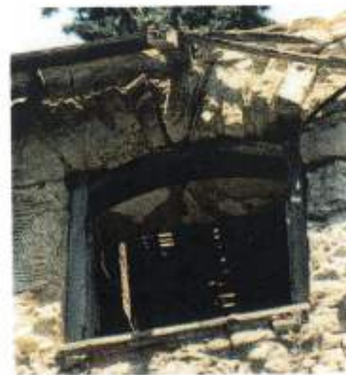
Λεπτομέρεια διαμόρφωσης ζώγιου παραθύρου σε λίθινο τοξωτό άνοιγμα στον όροφο.
