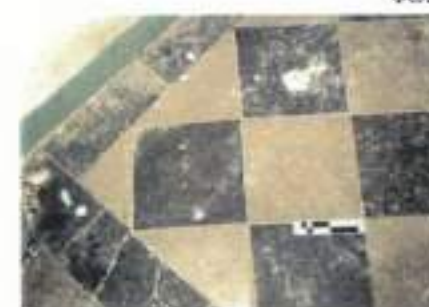
Στους "υγρούς χώρους" υπάρχουν χαρακτηριστικά τσιμεντένια πλακίδια 20 x 20 εκ σε άσπρο και μαύρο χρώμα.
