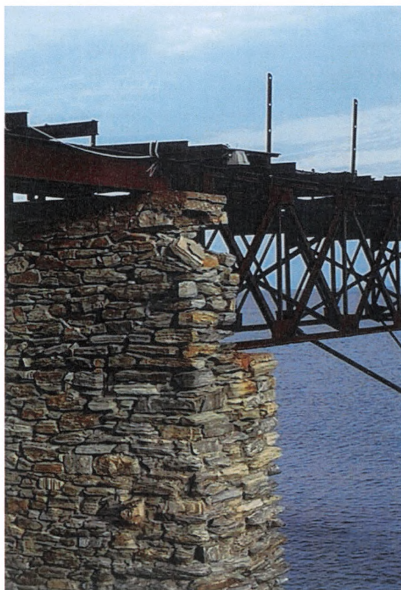
εικ. 7: απόπλυση κονιάματος και αποκόλληση λίθων, 2018
