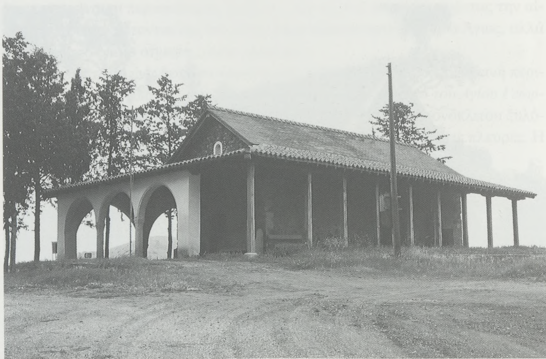
Ναός Αγίου Αποστόλου Λουκά μετά την αποκατάσταση.
