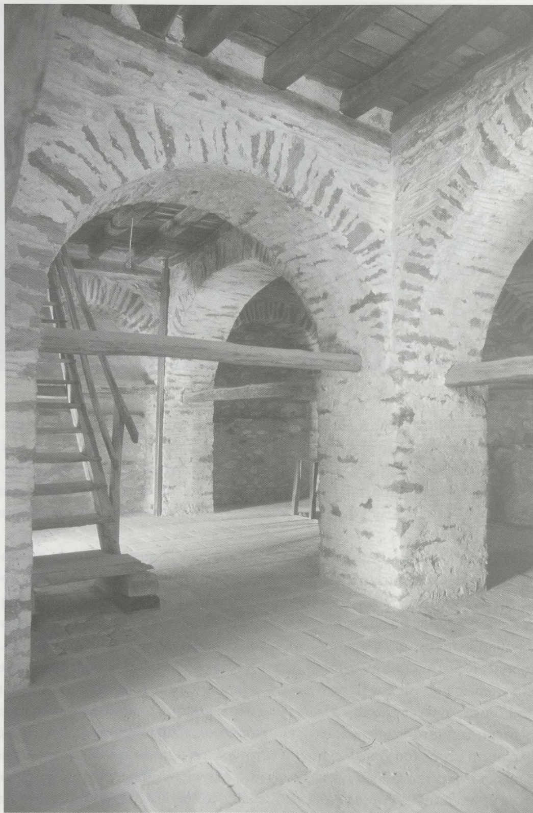
Εσωτερικό του πύργου «του Τζιμισκή» στη Μεγίστη Λαύρα, μετά την αποκατάσταση (φωτ. 2001).
