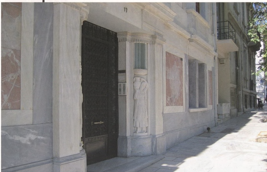
Αυτό το κτήριο, στη Διονυσίου Αρεοπαγίτου αρ. 17, σκέφτεται να γκρεμίσει το ΥΠ.ΠΟ.
