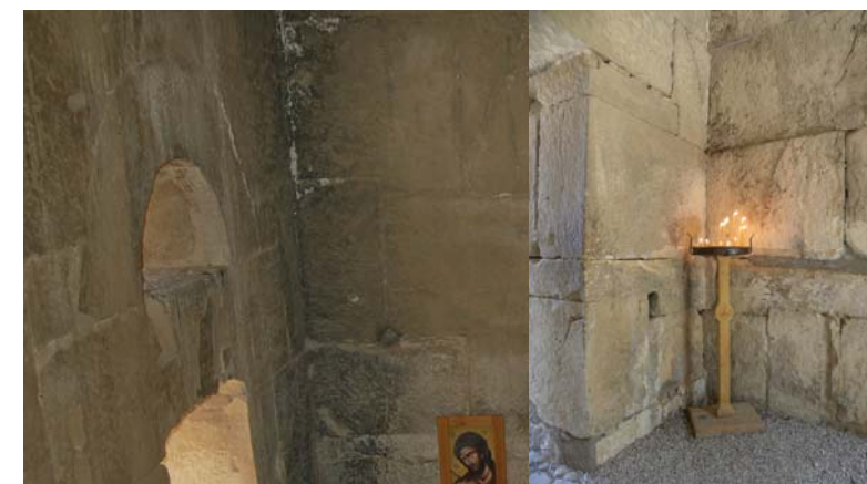
Εικ.35,36. Στις εσωτερικές επιφάνειες υπάρχουν επικαθήσεις αιθάλης στις επιφάνειες από την καύση κεριών.
