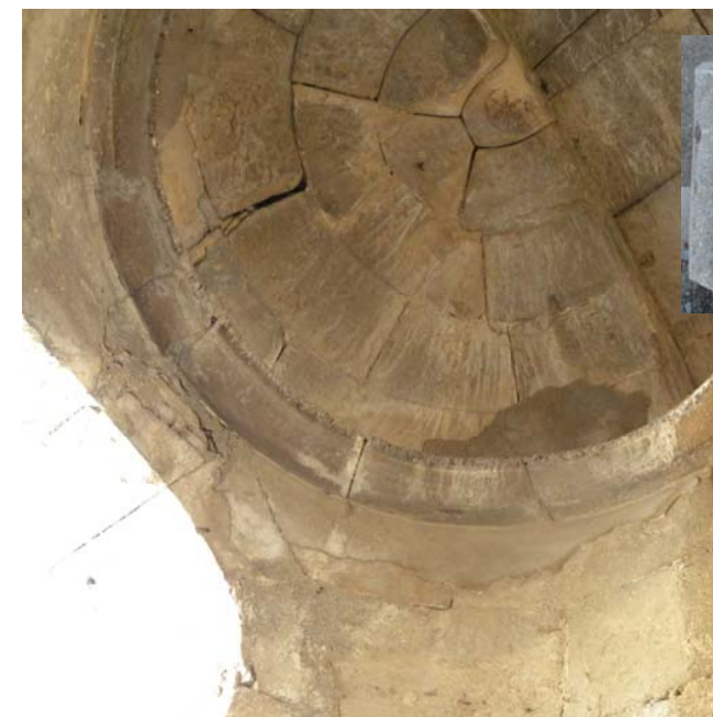
Εικ.32. Οι λευκές κρούστες σχηματίζονται όπου συμβαίνει εισροή υδάτων, από τις στέγες.
