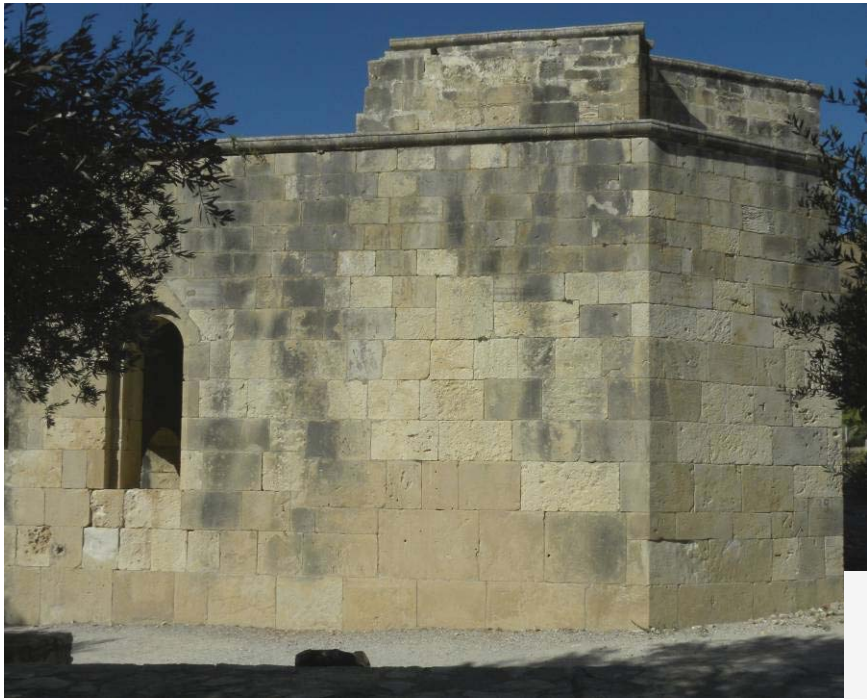
Εικ.12. Στο αναστηλωμένο νότιο παρεκκλήσιο έγινε μίμηση της ισόδομης αρχαιότερης τοιχοποιίας, με μικρότερους όμως λίθους.
