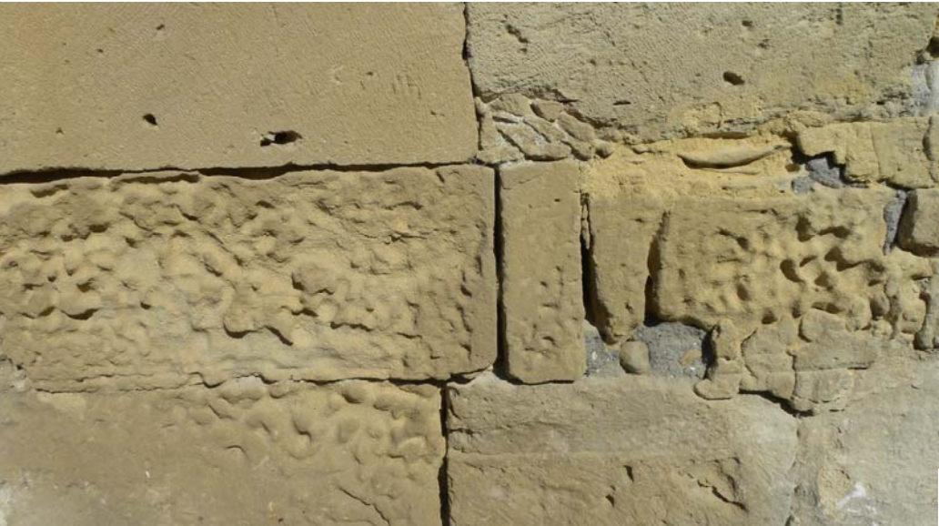
Εικ.27. Διακρίνεται η διαφορεική διάβρωση, από τη δημιουργία σπηλαιωδών σχηματισμών στην επιφάνεια.
