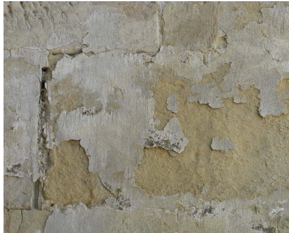
Εικ.40,41. Τα υπολείμματα των επιχρισμάτων είναι σε πολύ κακή κατάσταση και έχουν την τάση να αποχωρίζονται από την επιφάνεια, ενώ σε ελάχιστες περιπτώσεις διακρίνονται υπολείμματα από το γραπτό διάκοσμο.
