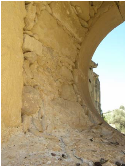
Εικ.8. Το κενό ανάμεσα στις παρειές της τοιχοποιίας είναι μεγαλύτερο και έχει πληρωθεί με μικρότερες πέτρες και κονίαμα
