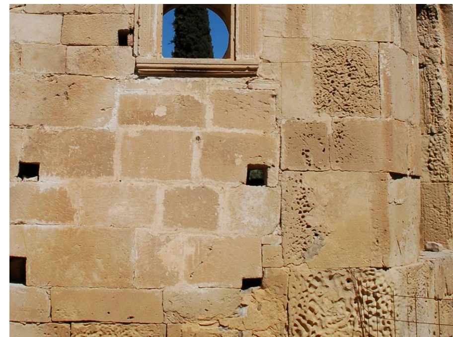
Εικ.6. Στις επεμβάσεις της τουρκοκρατίας οι αρμοί είναι ευρύτεροι με πλούσιο λευκό κονίαμα, που καλύπτει περιμετρικά το λίθο.
