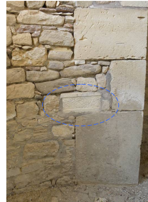
Εικ.13. Και στην αναστήλωση του '30 έχουν χρησιμοποιηθεί λίθοι από αρχαιότερες κατασκευές.
