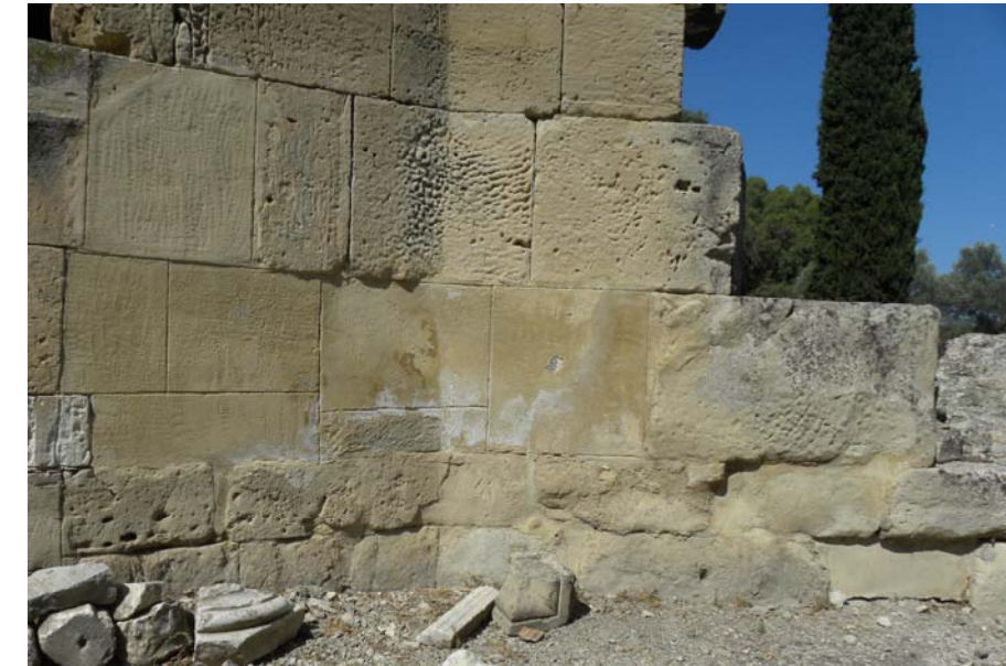
Εικ.22. Βόρειος τοίχος. Λεπτομέρεια συμπλήρωσης με κονίαμα, η οποία περιλαμβάνει περισσότερους από ένα λίθους, με τους αρμούς να υποδηλώνονται με ευθείες γραμμές σε υποθετικές θέσεις.
