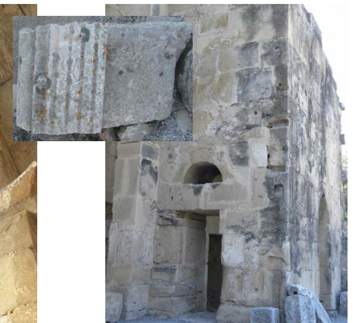
Εικ.33,34. Χρωματική αλλοίωση των λίθων προκαλούν οι βιογενείς κρούστες που σχηματίζονται από την εγκατάσταση μικροοργανισμών .
