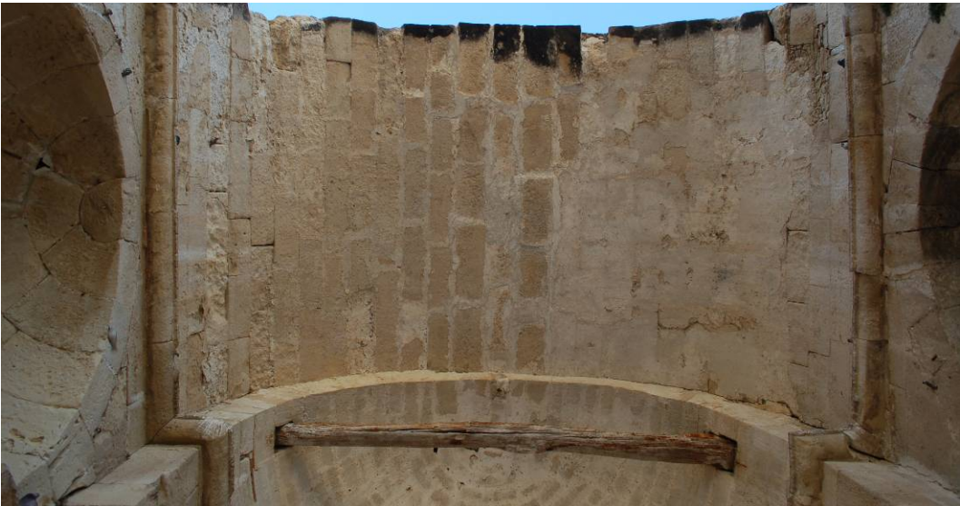
Εικ.9. Ο ημισφαιρικός θόλος του ιερού εικάζεται ότι κατασκευάστηκε επί τουρκοκρατίας, καθώς οι θολίτες είναι μικρότεροι από αντίστοιχους σε θόλους της αρχικής κατασκευής
