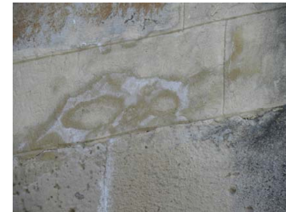
Εικ.22. Βόρειος τοίχος. Λεπτομέρεια συμπλήρωσης με κονίαμα, η οποία περιλαμβάνει περισσότερους από ένα λίθους, με τους αρμούς να υποδηλώνονται με ευθείες γραμμές σε υποθετικές θέσεις.
