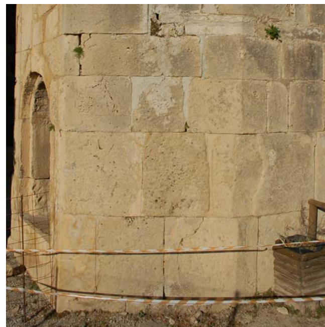
Εικ.31. Η παρουσία ρωγμών στους λίθους σχετίζεται με την ανάπτυξη τάσεων
