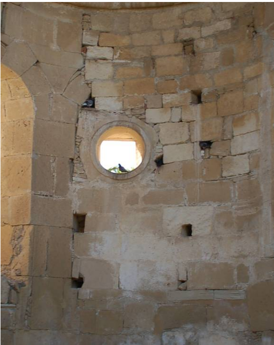
Εικ.10. Κόγχη Ιερού. Στις συμπληρώσεις αυτές έχει χρησιμοποιηθεί ένα λευκότερος λίθος.
