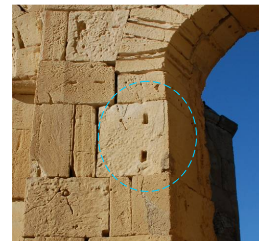
Εικ.1. Ζεύγος οπών ανάρτησης σε λίθο, που υποδηλώνει προηγούμενη χρήση του σε ύπτια θέση
