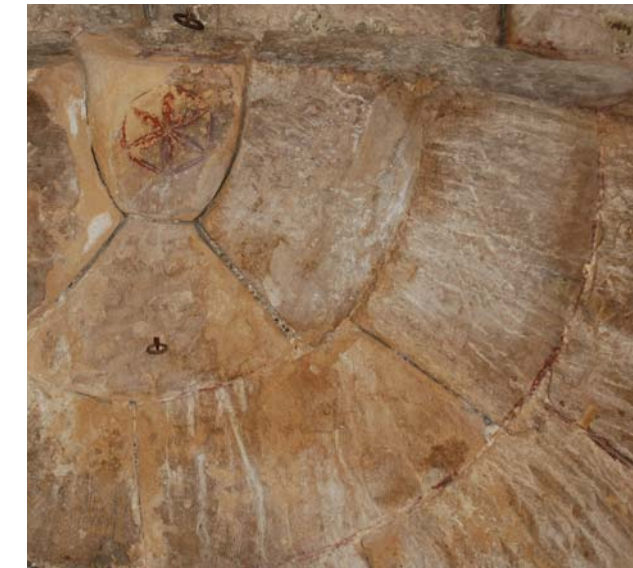
Εικ.13. Και στην αναστήλωση του '30 έχουν χρησιμοποιηθεί λίθοι από αρχαιότερες κατασκευές.
