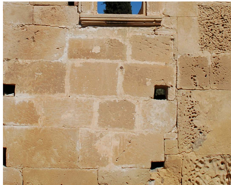
Εικ.42. Το κονίαμα της τουρκοκρατίας είναι ανθεκτικό και διατηρείται σε καλή κατάσταση.
