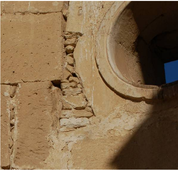
Εικ.7. Γεμίσματα με πλακοειδείς λίθους παρατηρούνται σε μικρά κενά.
