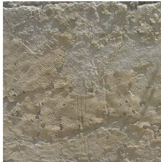
Εικ.28. Διακρίνεται η απολέπιση λεπτών επιφανειακών στιβάδων του πετρώματος που φέρουν ίχνη της αρχικής κατεργασίας.
