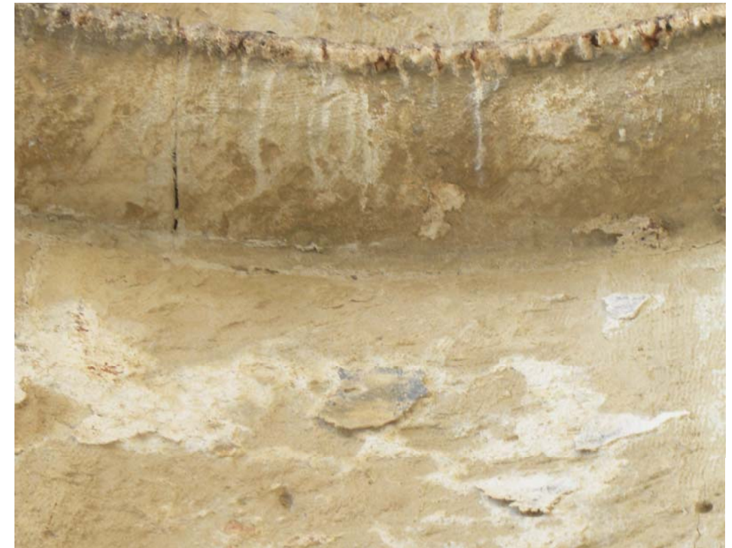
Εικ.40,41. Τα υπολείμματα των επιχρισμάτων είναι σε πολύ κακή κατάσταση και έχουν την τάση να αποχωρίζονται από την επιφάνεια, ενώ σε ελάχιστες περιπτώσεις διακρίνονται υπολείμματα από το γραπτό διάκοσμο.
