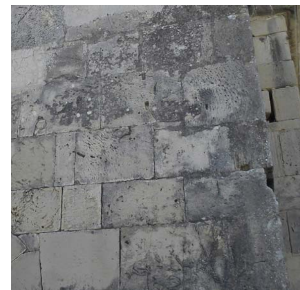
Εικ.20. Σε αρκετή έκταση στη δυτική όψη και σε μερικές περιπτώσεις και στις άλλες όψεις διακρίνεται ένα τεφρόφαιο κονίαμα σφράγισης αρμών.
