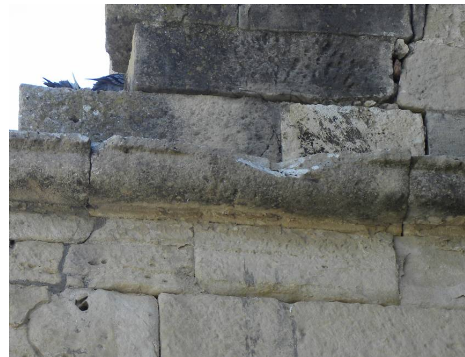
Εικ.5. Μεταλλικοί σύνδεσμοι εντοπίστηκαν στην στρώση του κοσμήτη
