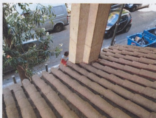
εικ. 3 Το υποστύλωμα που ενσωματώθηκε στον βόρειο τοίχο του ναού – άποψη από τη στέγη
