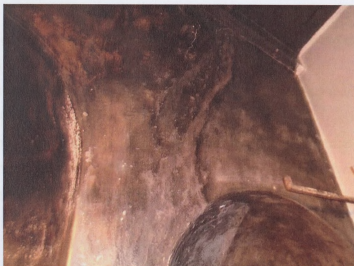
εικ. 9 σημάδια επισκευής στη δεξιά κόγχη του ιερού
