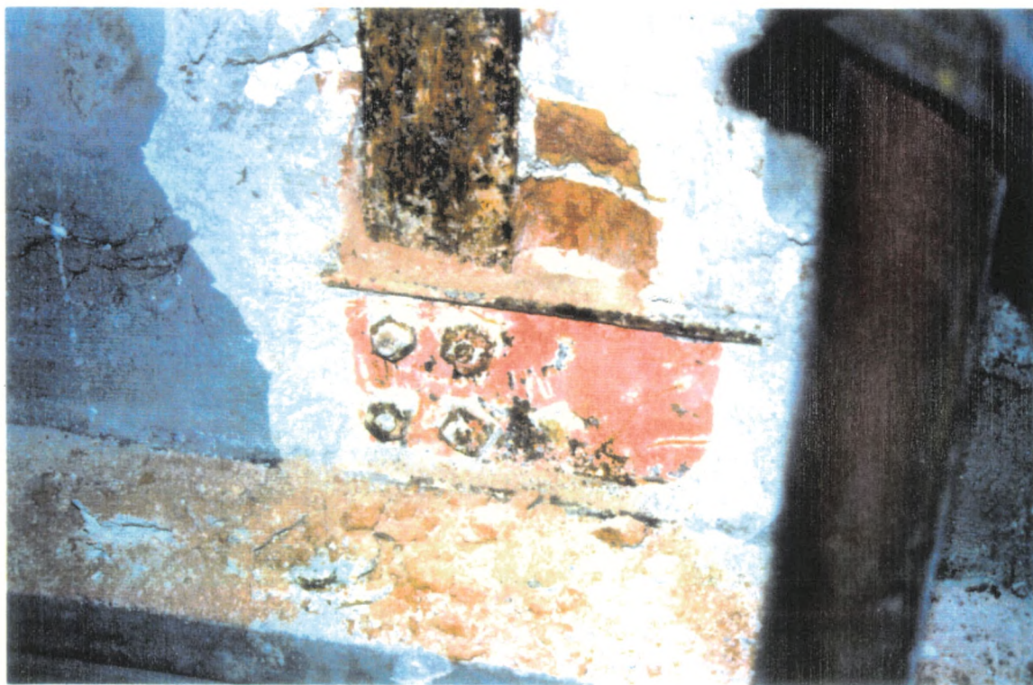
Φωτ. 8. Λεπτομέρεια μεταλλικού σκελετού τρούλου.
