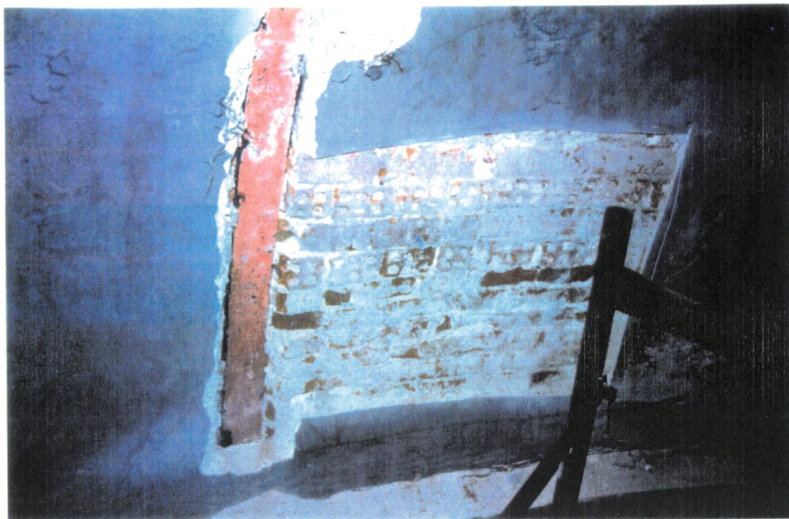
Φωτ. 7. Λεπτομέρεια θόλου του τρούλου. Διακρίνεται η μεικτή κατασκευή από συμπαγή και διάτρητα τούβλα.
