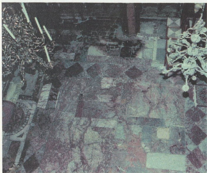
Εικ. 6. Το δάπεδο του κυρίως ναού.
