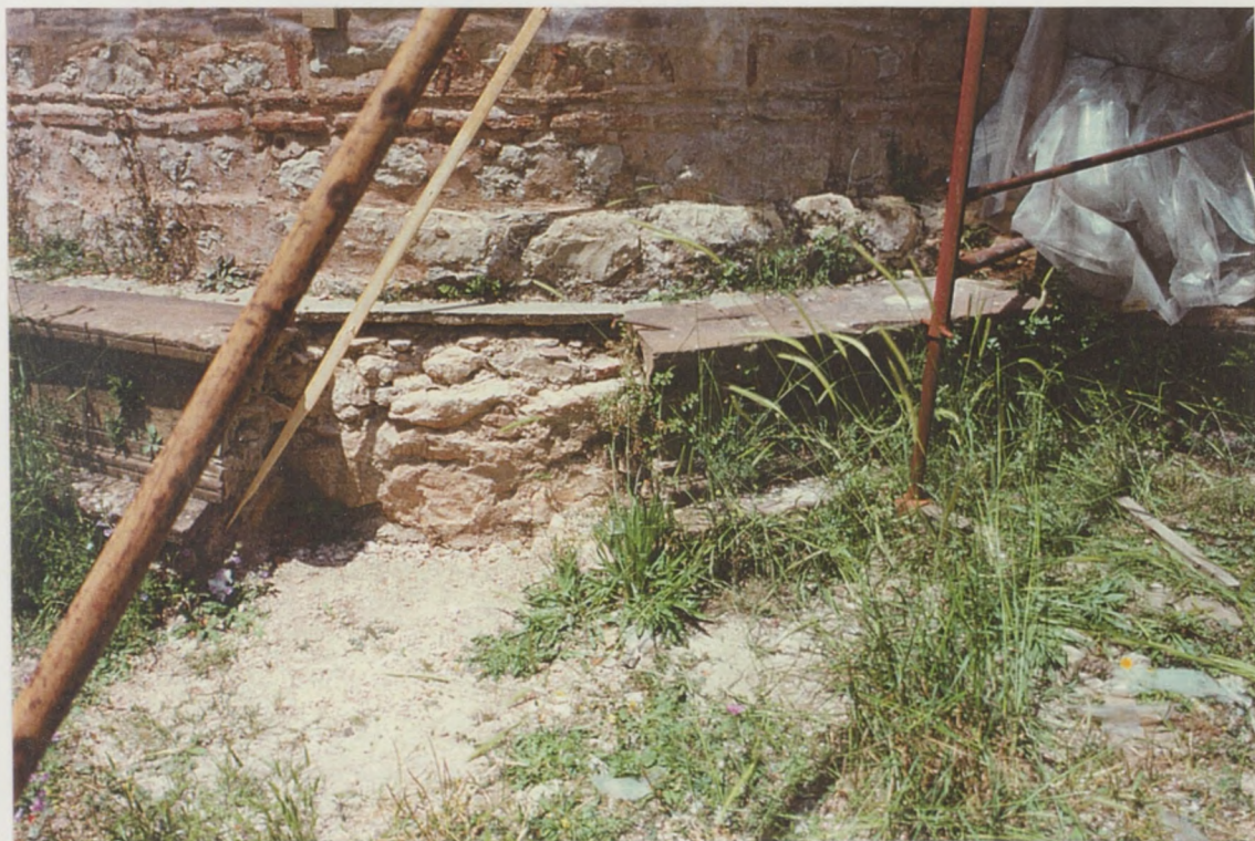
Εικ. 59. Διερευνητική τομή στο περιμετρικό θρανίο.
