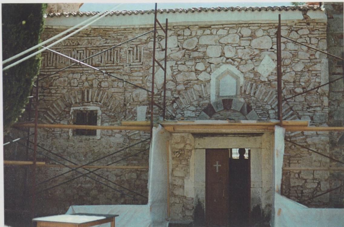
Εικ. 37. Η βόρεινή όψη του προσκτίσματος.
