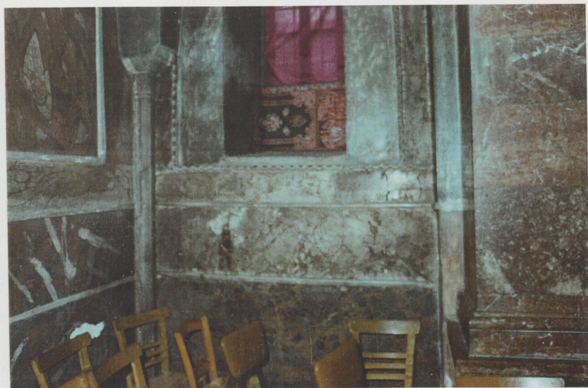
Εικ. 14. Λεπτομέρεια της πατητής χρωματιστής ασβεστοκονίας.
