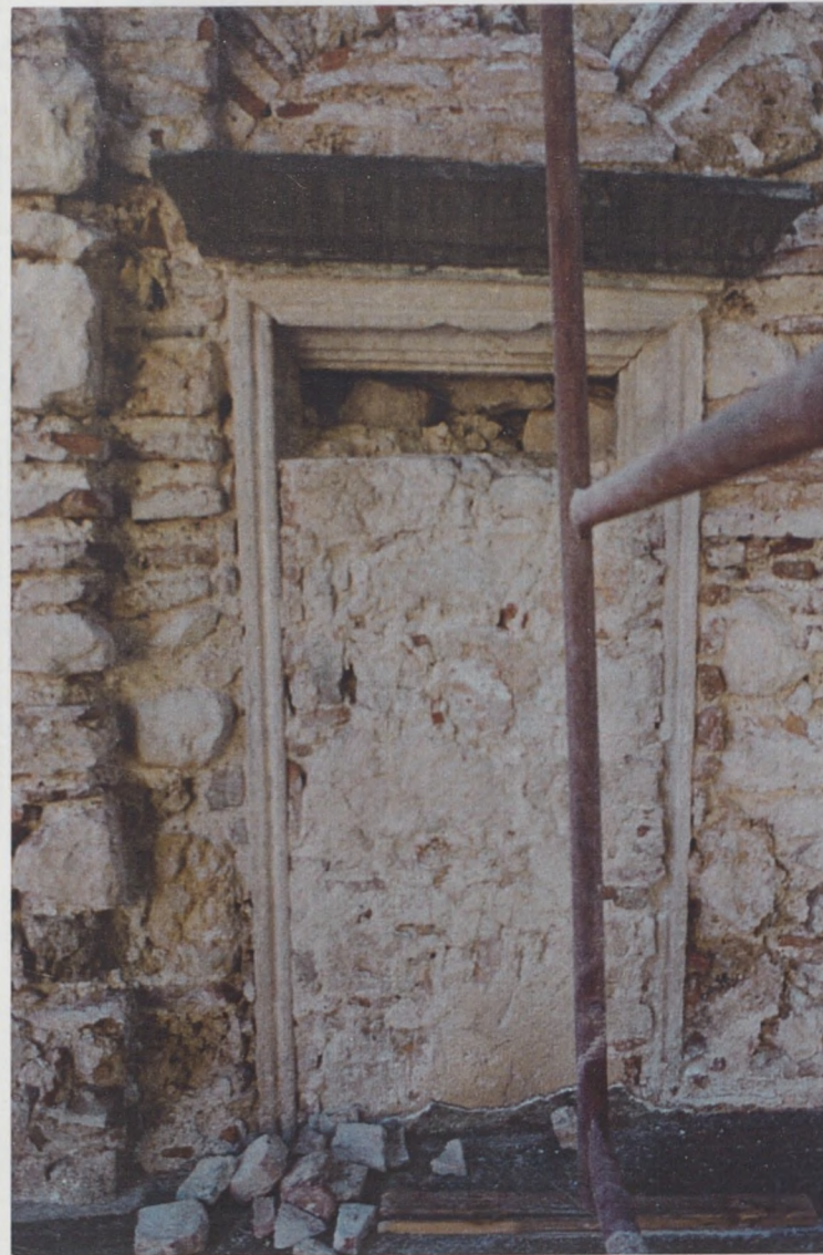
Εικ. 33. Λεπτομέρεια σύνδεσης της αψίδας του εξωνάρθηκα. Εικ. 34. Λεπτομέρεια της βορινής θύρας του κυρίως ναού.
