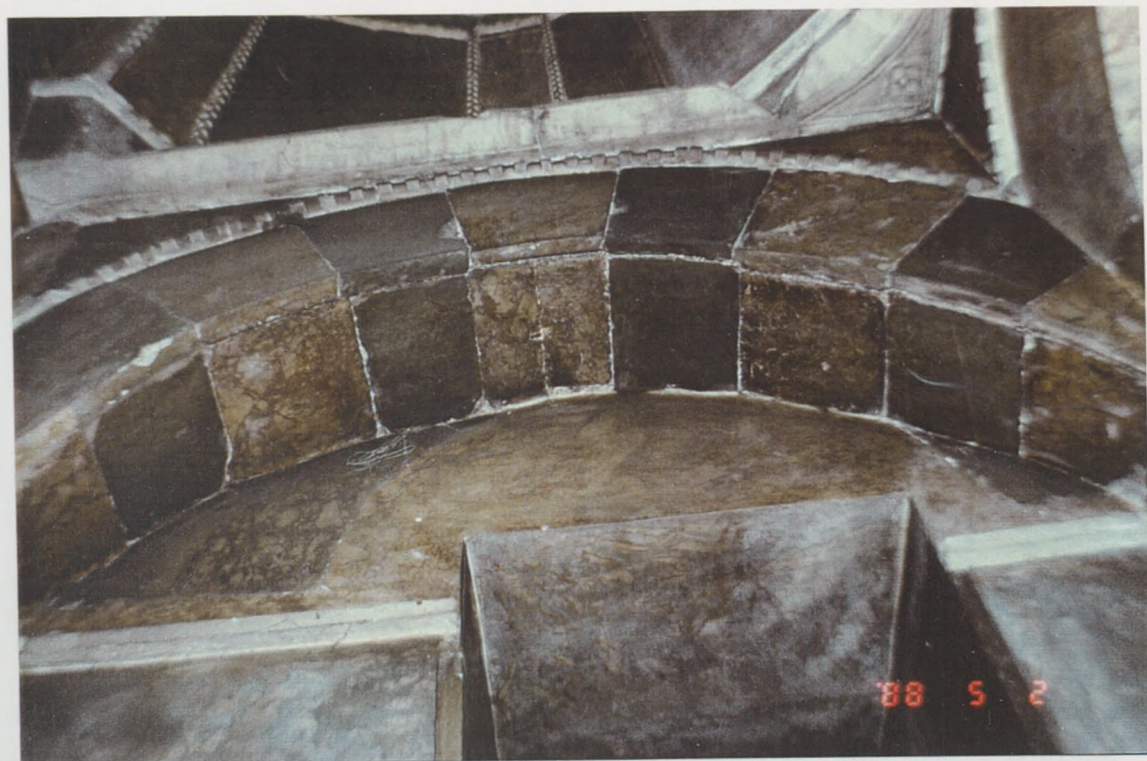
Εικ. 13. Λεπτομέρεια ορθομαρμάρωσης του κυρίως ναού.
