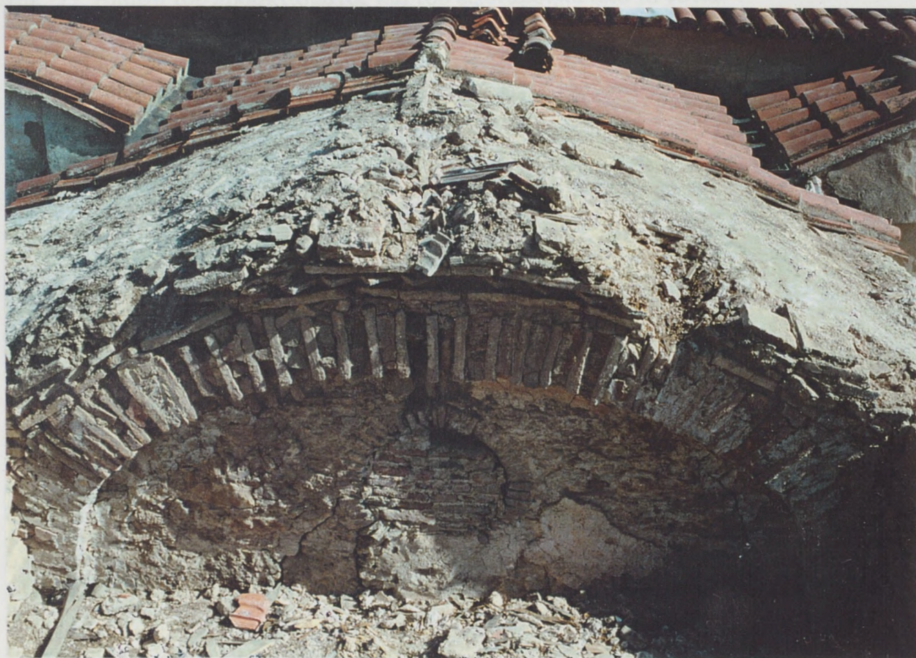
Εικ. 38. Λεπτομέρεια της κάλυψης του ανατολικού τμήματος του προσκτίσματος.
