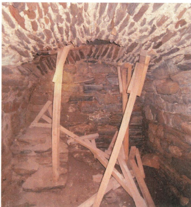
Φωτ. 10: Άποψη βόρειας κρύπτης και σκαλοπάτια εισόδου.
