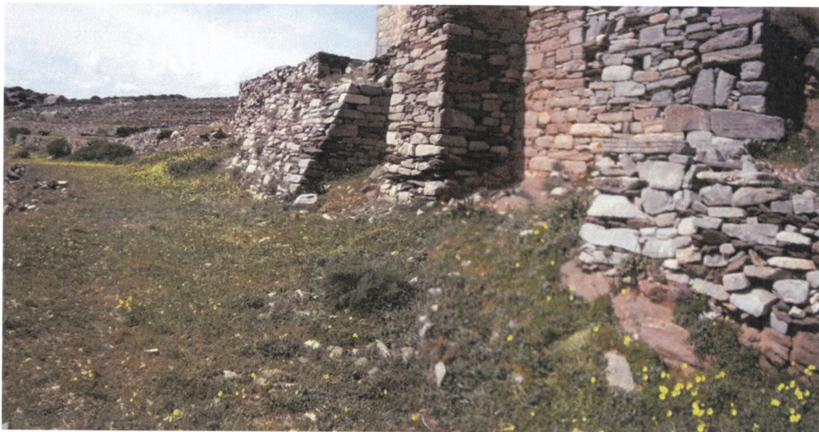
Φωτ. 19 : Άποψη επιμήκους συσσώρευσης υλικών τεχνητών επιχωματώσεων επί του νότιου τμήματος του Ναού .
