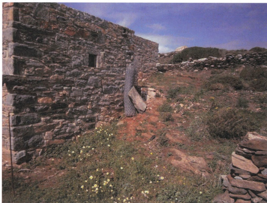
Φωτ. 17: Τυπική εμφάνιση μαρμαρυγιακών σχιστολίθων επί του χώρου θεμελίωσης των κελιών βόρεια του Ναού.
