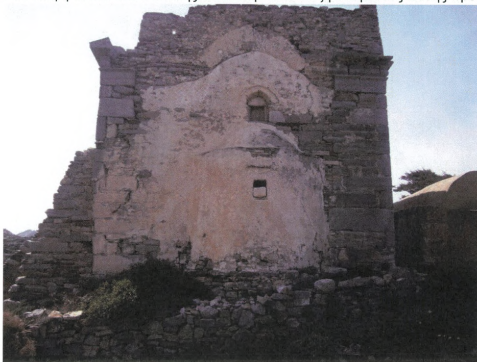
Φωτ. 15: Άποψη ανατολικής όψης Ιερού Ναού με ανάπτυξη ρωγμάτων επί της τοιχοποιίας και του ιερού.
