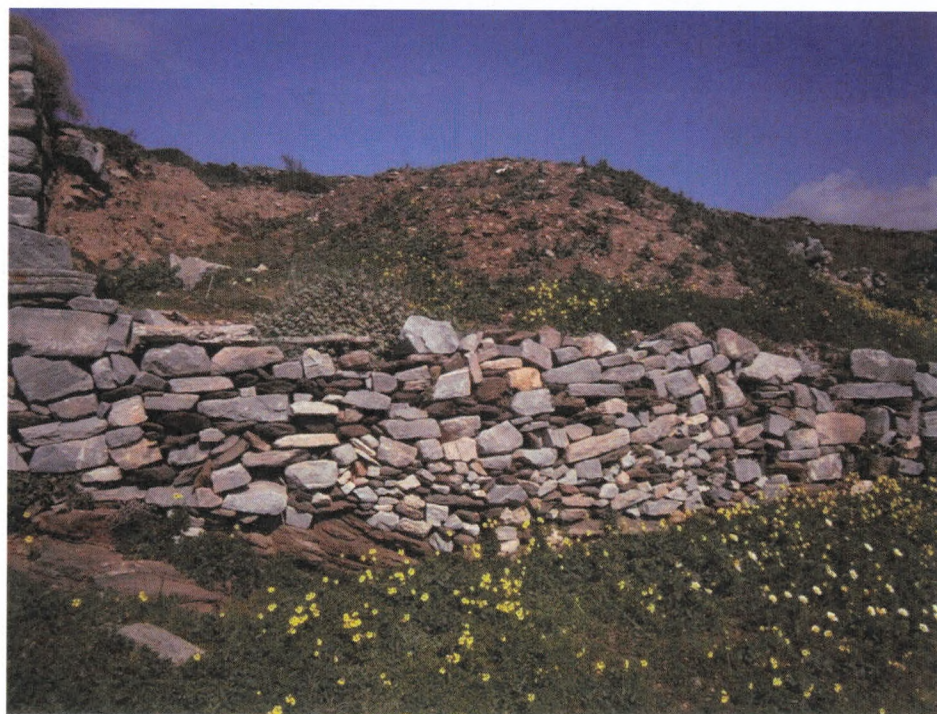
Φωτ. 4: Τυπική άποψη υλικών τεχνητών επιχωματώσεων W.
