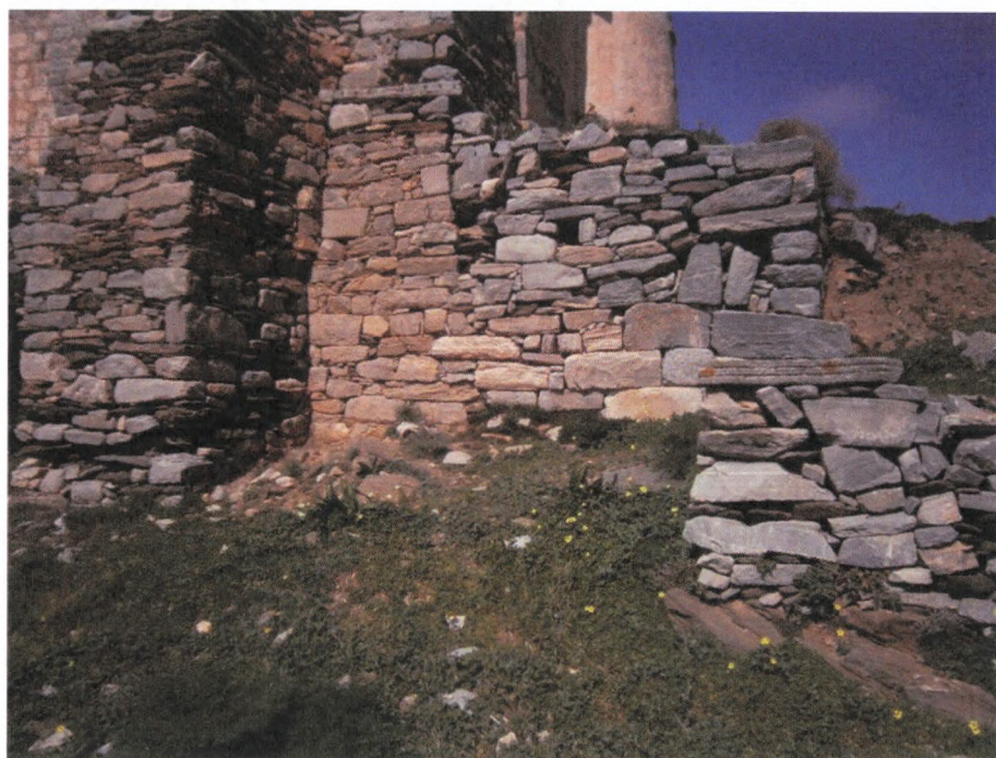
Φωτ. 18 : Επιφανειακή εμφάνιση βραχώδους υποβάθρου επί του νοτιοανατολικού άκρου του μνημείου κάτω από την πρώτη και δεύτερη αντηρίδα.
