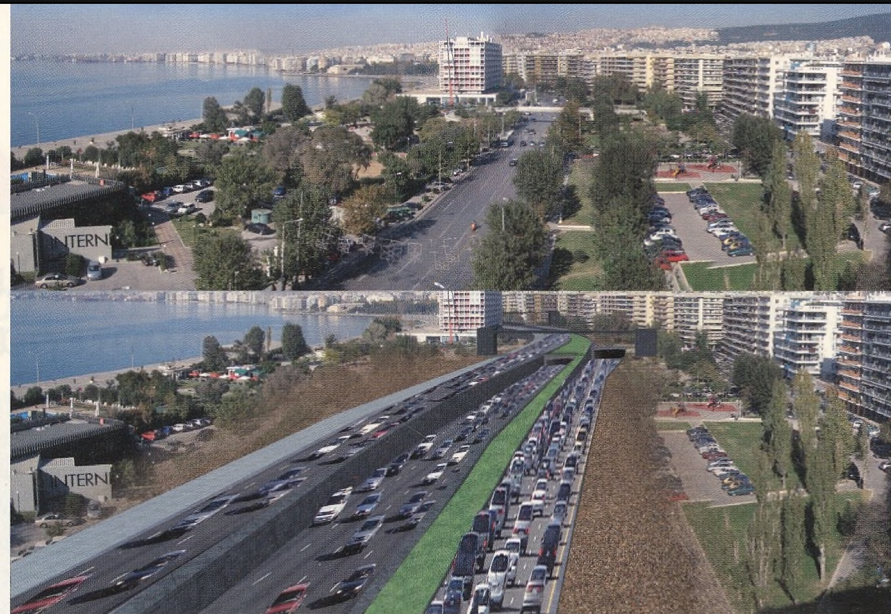
Επάνω: άποψη παραλίας Θεσσαλονίκης σήμερα. Κάτω: άποψη μετά την κατασκευή της υποθαλάσσιας
