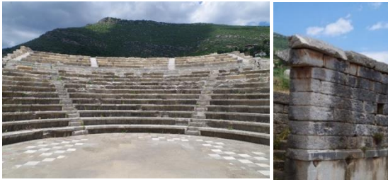
Εικόνα 63: Μακροσκοπική απεικόνιση α- Εικόνα 64: Μακροσκοπική απεικόνιση ασβεστόλιθων στο Σεβάστειο. ασβεστόλιθων στο Εκκλησιαστήριο
