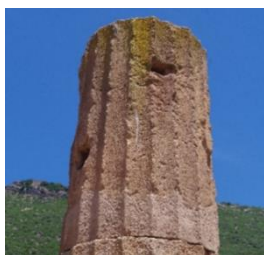
Εικόνα 53: Μακροσκοπική απεικόνιση κατάστασης ψαμμίτη στην στοά της Αγοράς.
