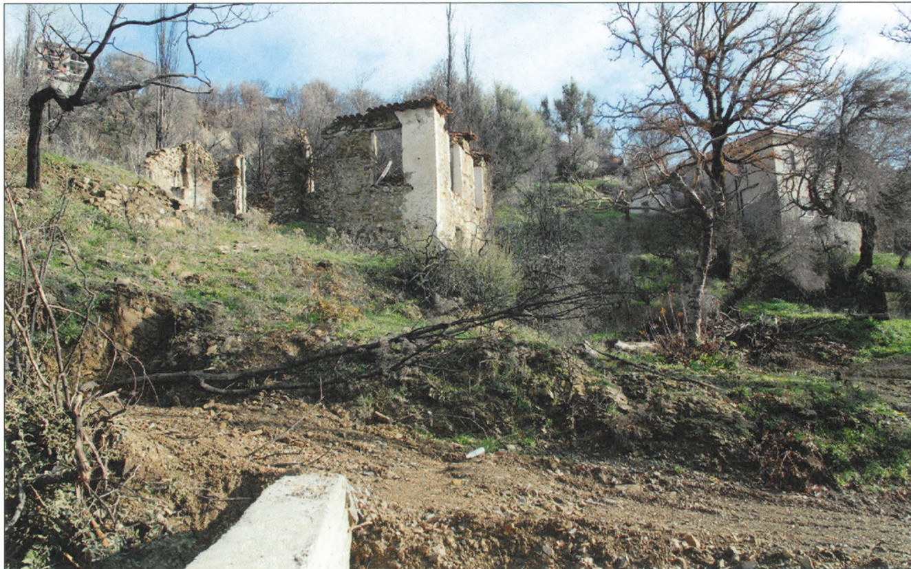
Εικ.14 Άποψη του περιβάλλοντος χώρου του κτηρίου από Δ.
