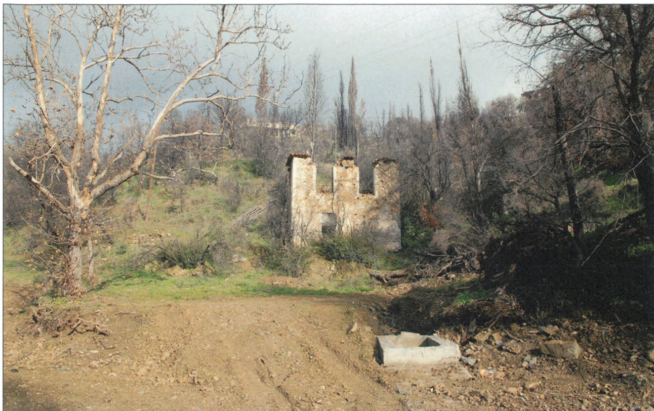
Εικ.13 Άποψη του, υπό επισκευή κτηρίου "Σπίτι του Νικηταρά, από Ν.
