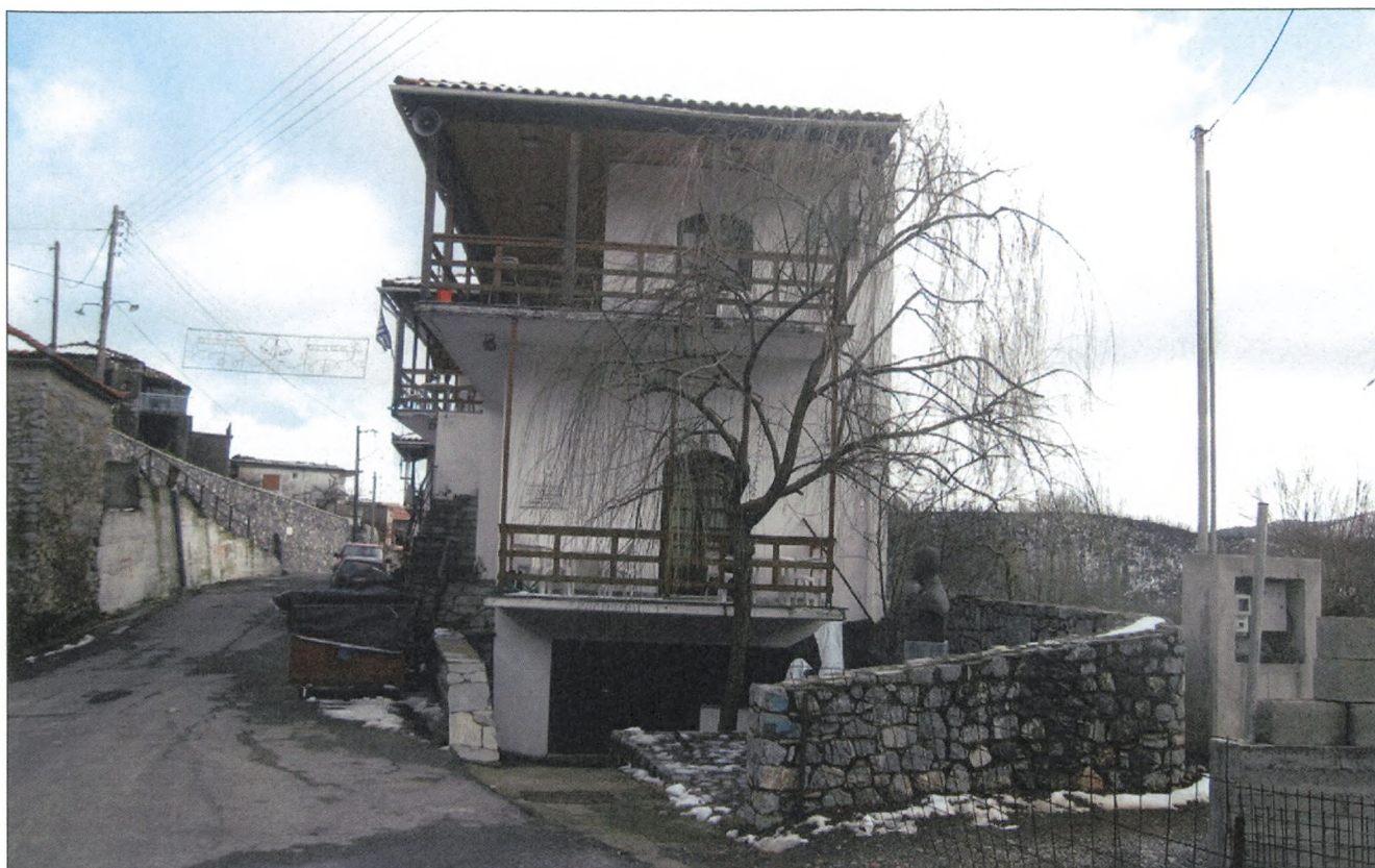
Εικ.3 Το κτήριο του ξενώνα στην είσοδο της περιοχής μελέτης.
