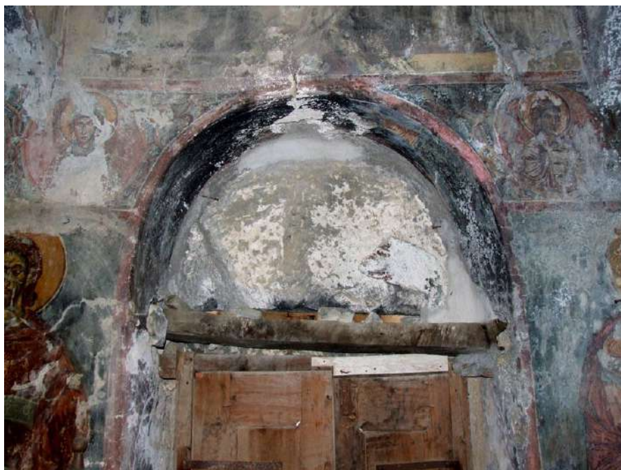
Εικ. 12. Εσωτερική άποψη του δυτικού θυραίου ανοίγματος του κυρίως ναού.
