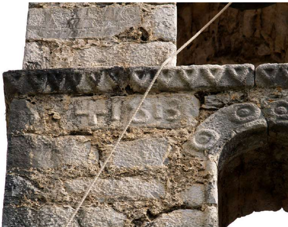
Εικ. 30. Η ανάγλυφη χρονολογία κατασκευής του κωδωνοστασίου.
