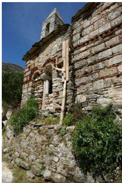
Εικ. 137. α-β) Εμφαίνεται το σημείο που αντιμετωπίζει προβλήματα στατικότητας, γ) τοποθέτηση πρόχειρου ελκυστήρα.
