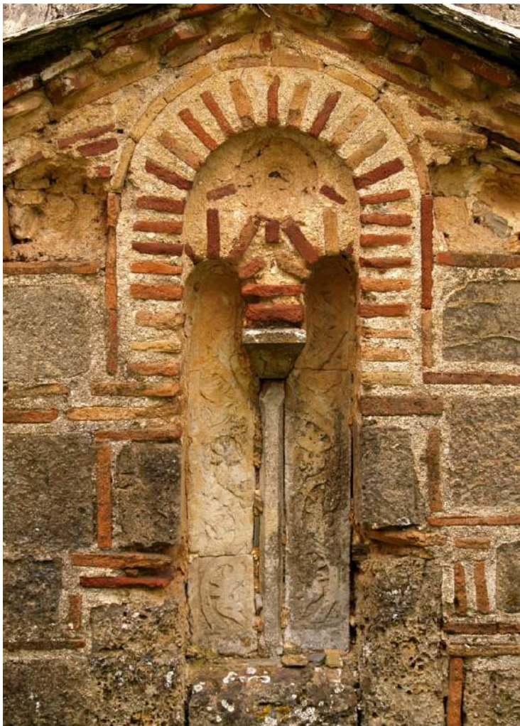
Εικ. 87. Το δίλοβο παράθυρο του βόρειου σταυρικού σκέλους. Διακρίνονται στη θέση τους τα λίθινα φράγματά του.
