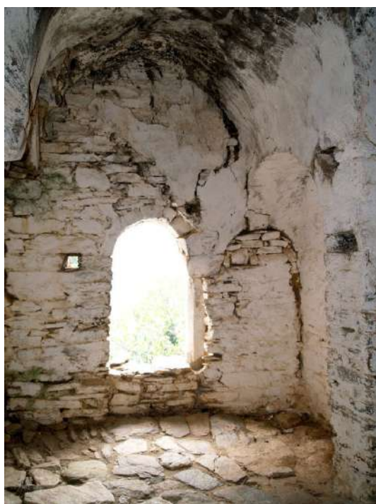
Εικ. 22. Εσωτερική άποψη του νότιου δίβηλου ανοίγματος του νάρθηκα.
