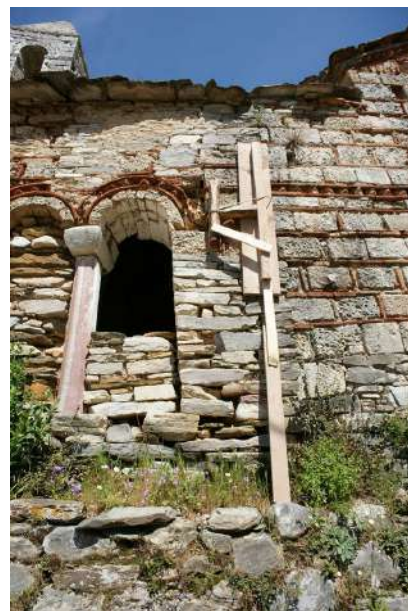
Εικ. 137. α-β) Εμφαίνεται το σημείο που αντιμετωπίζει προβλήματα στατικότητας, γ) τοποθέτηση πρόχειρου ελκυστήρα.
