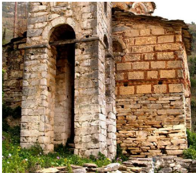
Εικ. 63. Η δυτική πλευρά του νάρθηκα. Διακρίνεται μέρος του νότιου αψιδώματος, που καλύπτεται από το μεταγενέστερο κωδωνοστάσιο.
