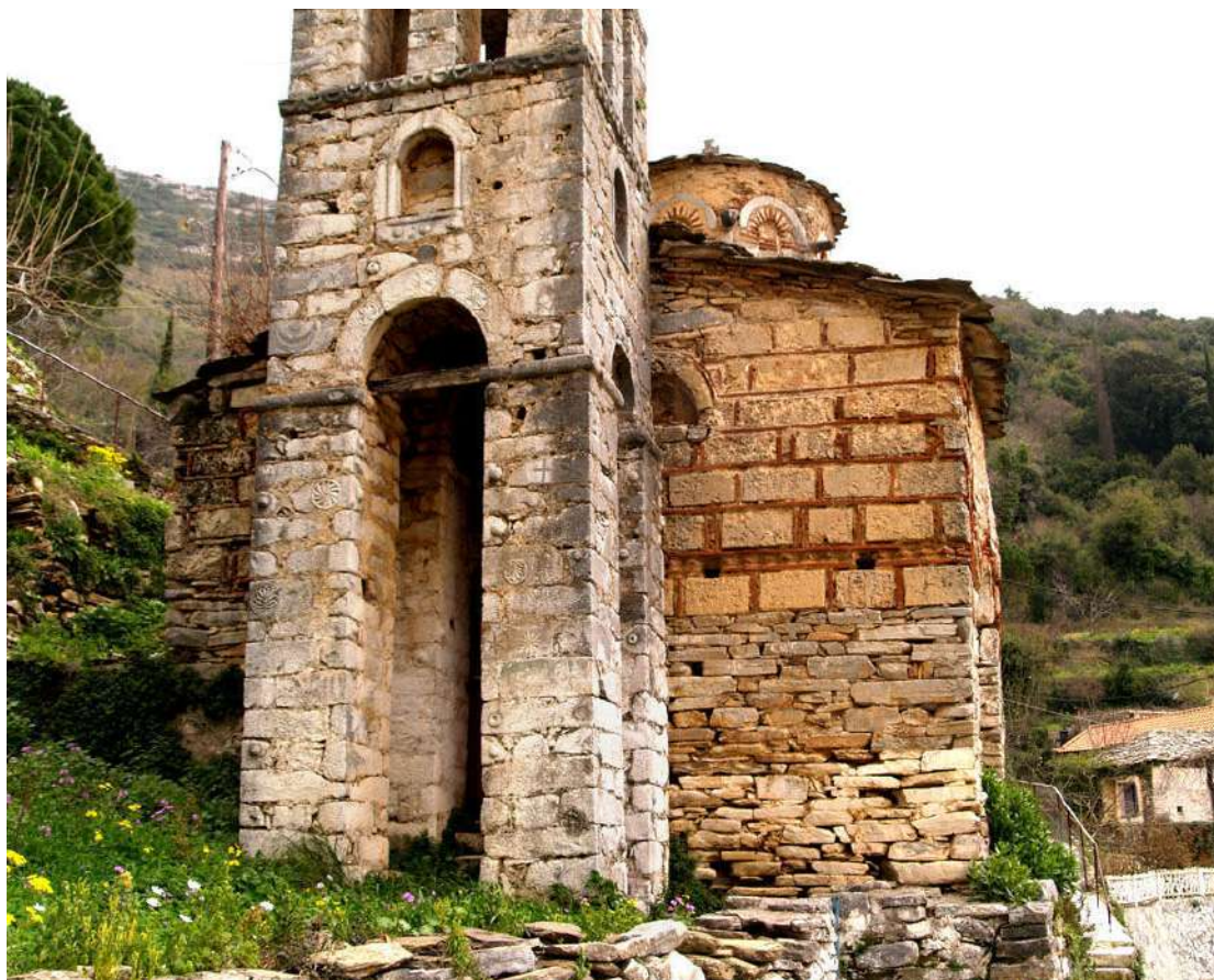
Εικ. 21. Άποψη της δυτικής πλευράς του νάρθηκα.
