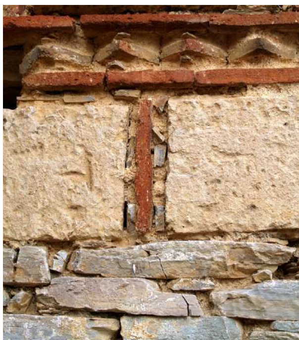
Εικ. 67. Λεπτομέρεια της τοιχοποιίας του νάρθηκα. Διακρίνονται οι μικρές πέτρες ανάμεσα στους πωρόλιθους και τις πλίνθους για την καλύτερη πρόσφυση του κονιάματος.
