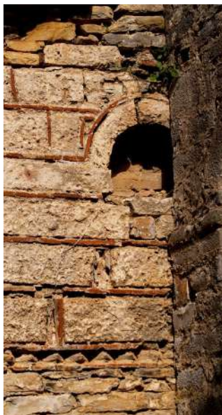
Εικ. 62. Λεπτομέρεια του βορειότερου αψιδώματος στη δυτική πλευρά του νάρθηκα.
