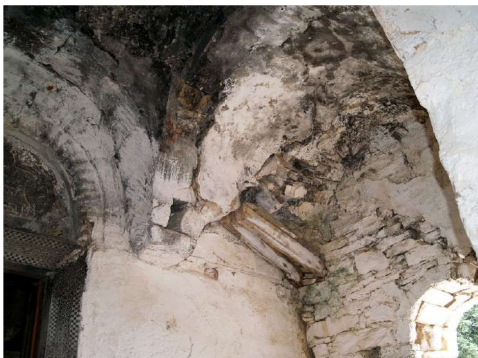
Εικ. 16. Εσωτερική άποψη του νάρθηκα. ΝΑ όψη.
