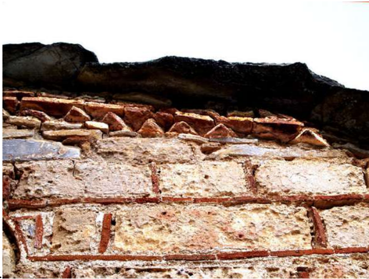
Εικ. 75. Λεπτομέρεια του νότιου καταέτιου γείσου της δυτικής πλευράς του νάρθηκα.
