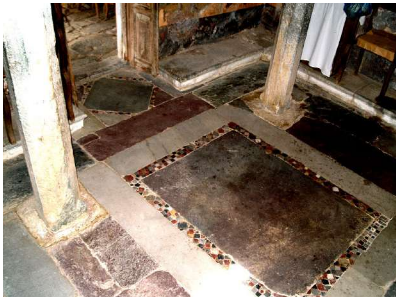
Εικ. 82. Το δάπεδο του κυρίως ναού.
