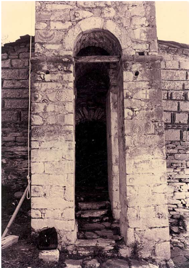
Εικ. 29. Άποψη της κατώτερης βάσης του κωδωνοστασίου από δυτικά.
