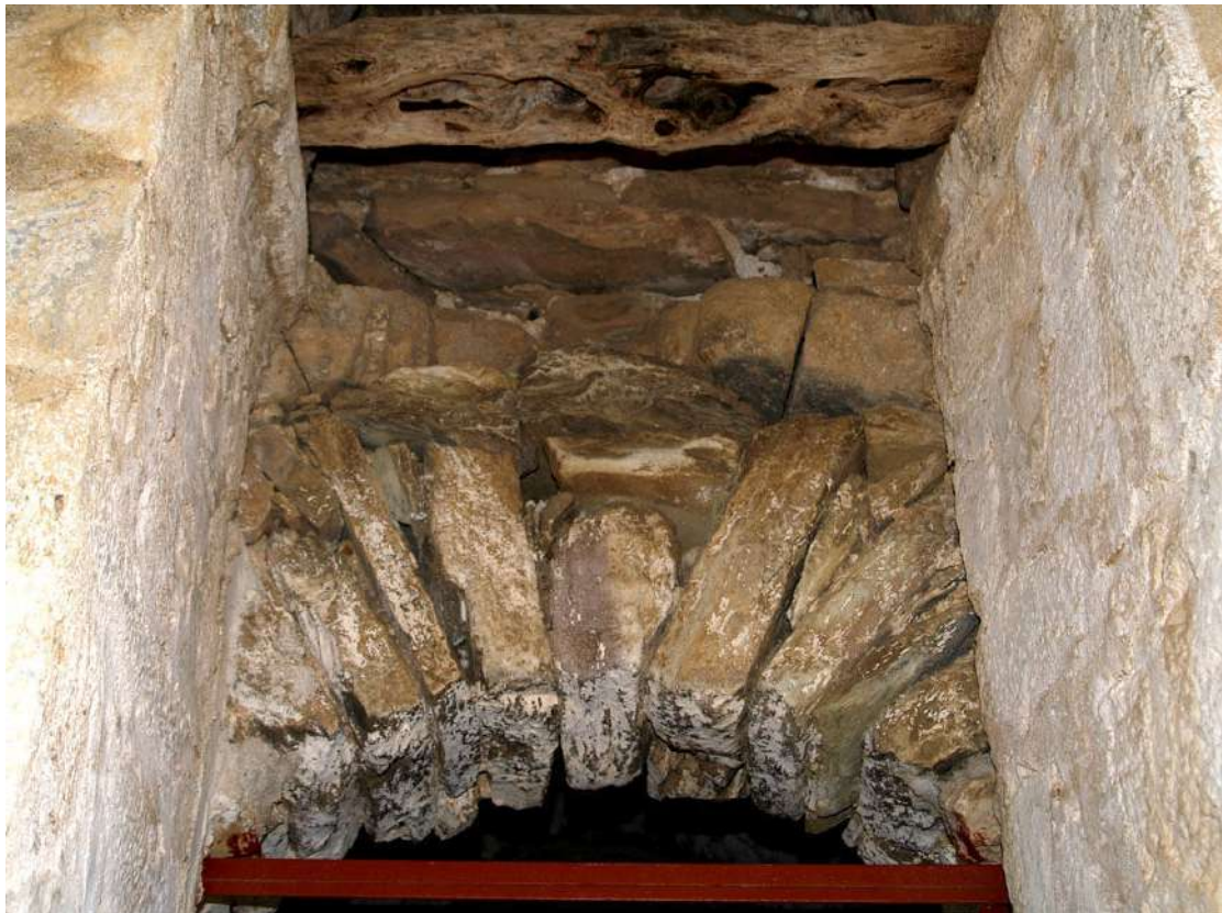
Εικ. 44. Λεπτομέρεια των τόξων του δυτικού θυραίου ανοίγματος του νάρθηκα.
