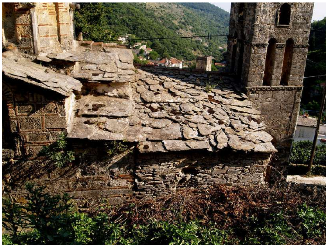
Εικ. 81. Λεπτομέρεια της στέγης του δυτικού τμήματος του σταυροειδούς πυρήνα και του νάρθηκα.
