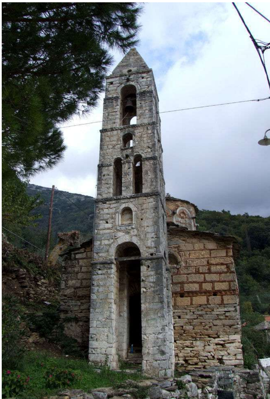
Εικ. 28. Γενική άποψη κωδωνοστα- σίου από δυτικά.
