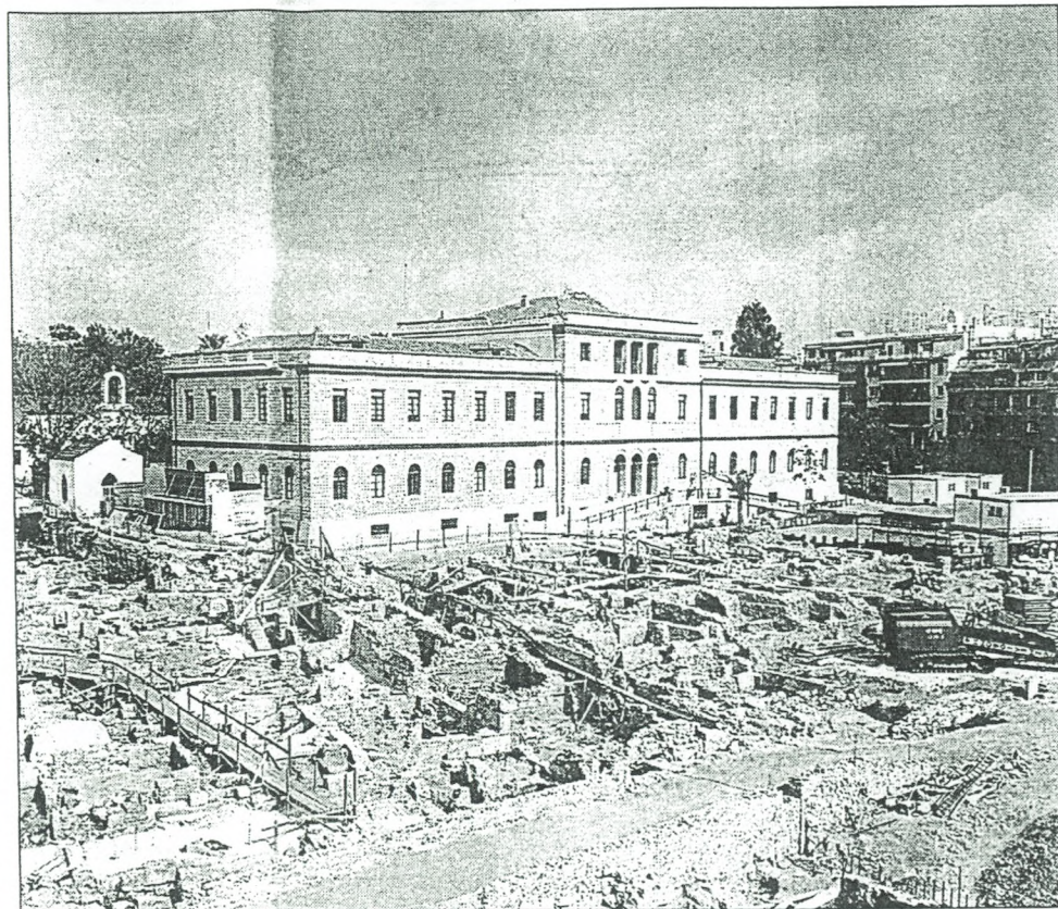
Το κτίριο του Βάιλερ και μπροστά ο αρχαιολογικός χώρος όπου θα ανεγερθεί το μουσείο.
