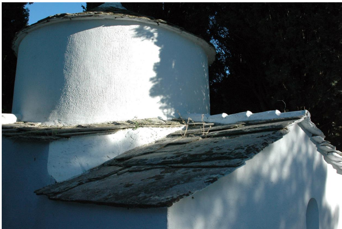
Εικ. 8. Όψη της στέγας του ναού.
