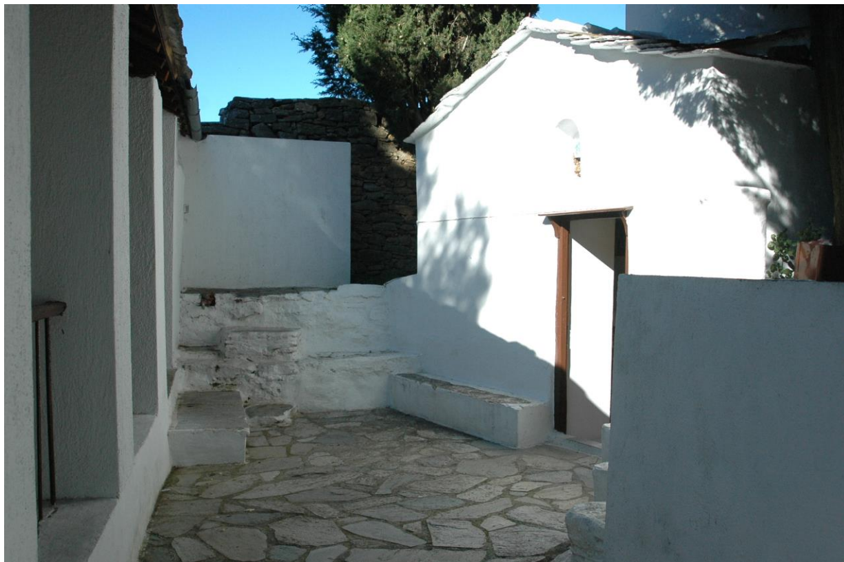
Εικ. 7. Δυτική όψη του ναού
