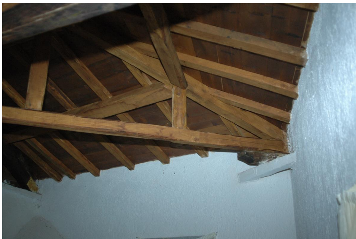
Εικ. 24. Αποψη της στέγης από εσωτερικό της πτέρυγας.
