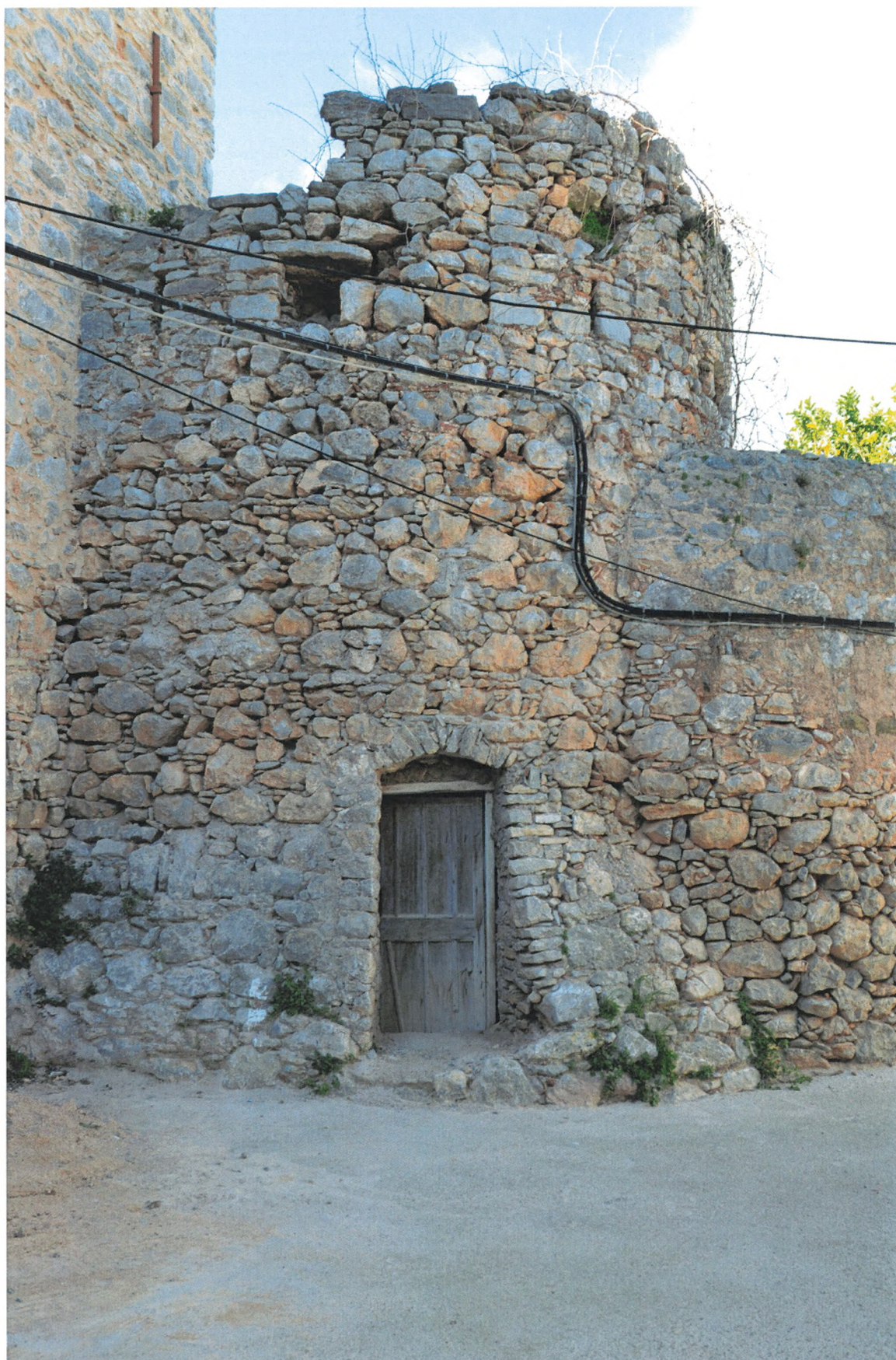
21. Ο γειτονικός μεσαιωνικός πύργος
