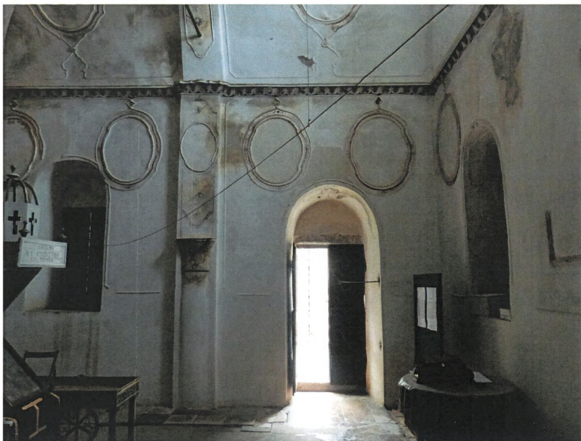
28. Τμήμα του νότιου τοίχου εσωτερικά
