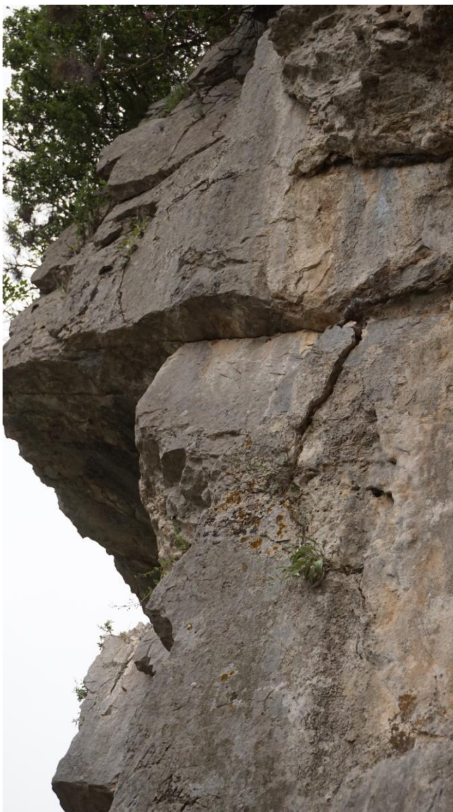
ΦΩΤ. 3. Οι αρνητικές κλίσεις των πρανών αυξάνουν τον βαθμό επικινδυνότητας πιθανών αποκολλήσεων βραχωδών τεμαχών.
