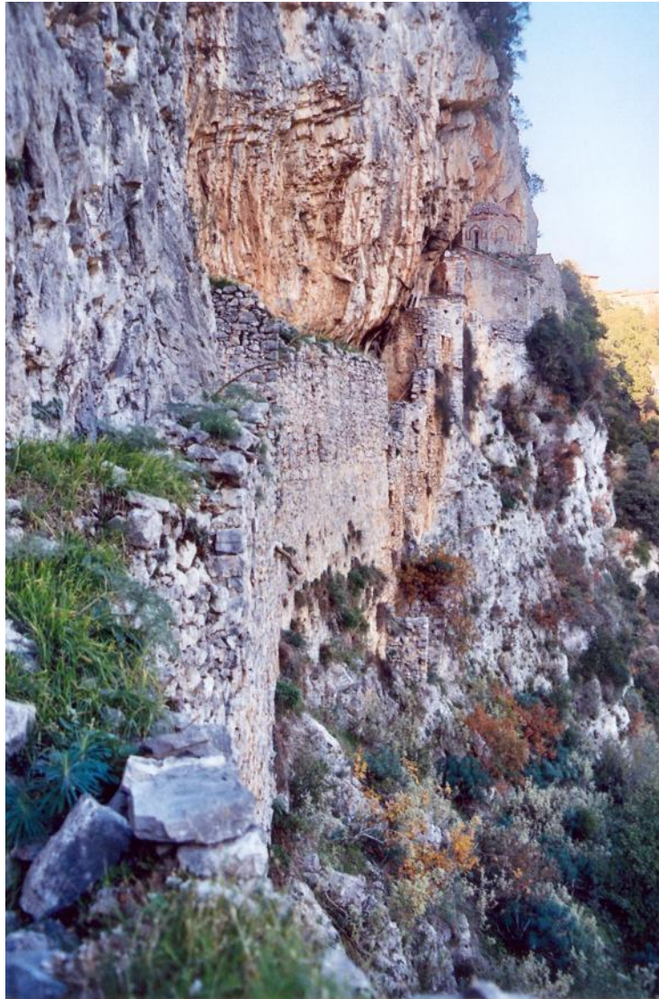
ΦΩΤ. 4. Οι αρνητικές κλίσεις των πρανών αυξάνουν τον βαθμό επικινδυνότητας πιθανών αποκολλήσεων βραχωδών τεμαχίων.
