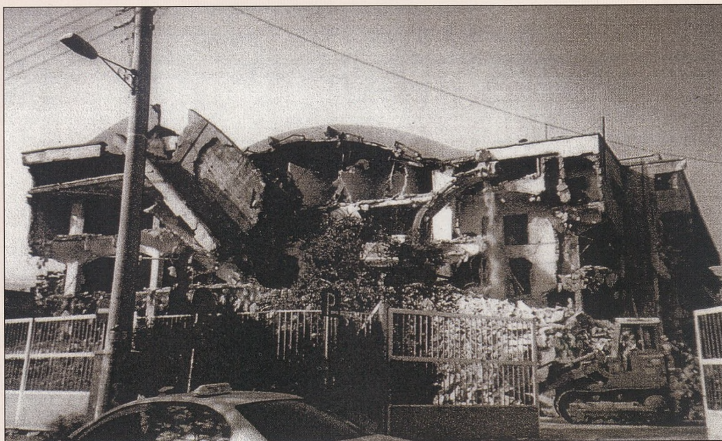
Βιομηχανικό κτίριο στα Καμίνια Πειραιά, έργο Ι. Σαπόρτα
