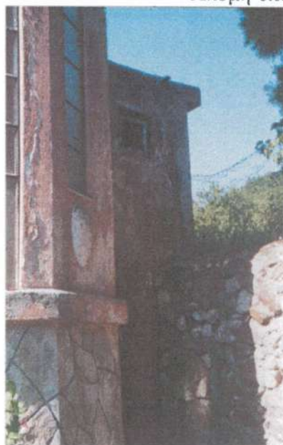
18 Λεπτομέρειες στοιχείων εξωτερικών του κτίσματος και των τοίχων αντιστήριξης από τη βορινή πλευρά
