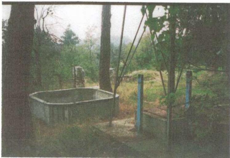
7 Α επίπεδο κτίσματος ανοικτή δεξαμενή νερού με γεώτρηση
