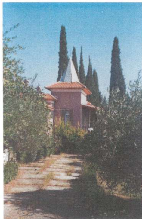
4 Σύνδεση διαδρόμου εισόδου με την αίσθηση των φυτεύσεων και του όγκου του κτίσματος
